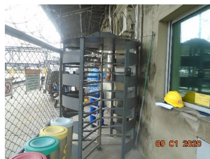
Foto 2.2.1-6: O controle de acesso interno de pedestres é realizado de forma híbrida – com o uso de cancelas eletrônicas e porteiro.
