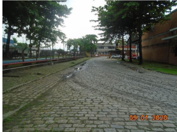
Foto 1.5.2-6: Posto de espera - Área III.
