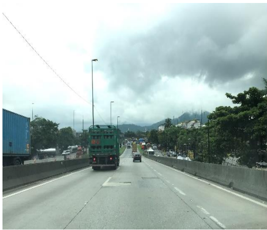
Foto 2.2.2-3: Término do Viaduto Dr. Paulo Bonavides.
