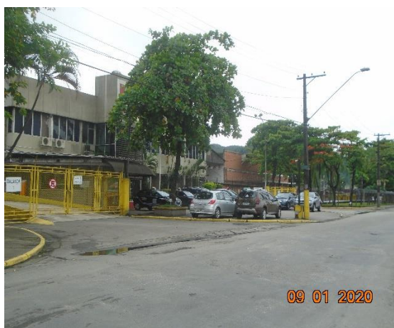
Foto 2.2.2-1: Estacionamento para visitantes.
