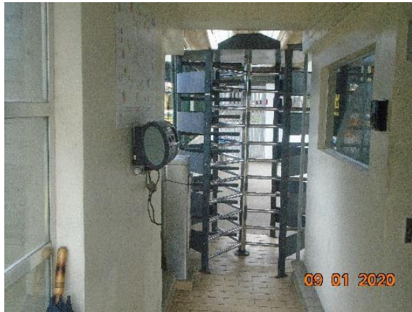
Foto 2.2.1-7: O controle de acesso interno de pedestres é realizado de forma híbrida – com o uso de cancelas eletrônicas e porteiro.
