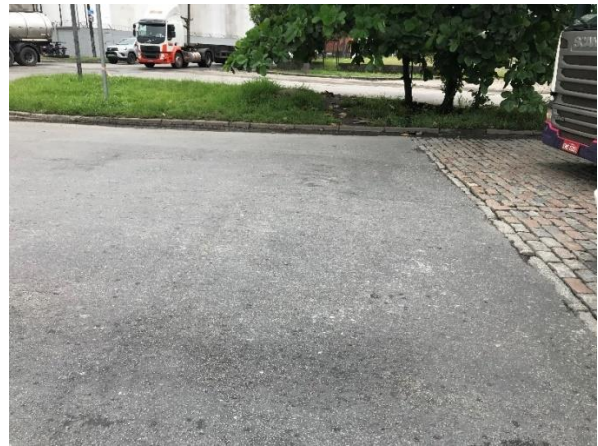
Foto 2.2.2-6: Cruzamento entre a Rua Augusto Scaraboto com a Rua Dr. Alberto Schwedtzter – ausência de calçada.
