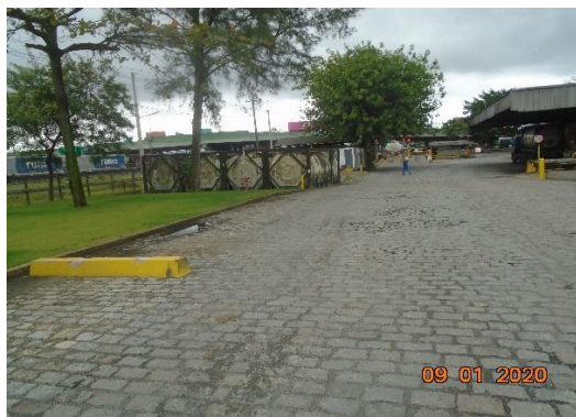
Foto 1.5.2-9: Posto de espera - Área III.
