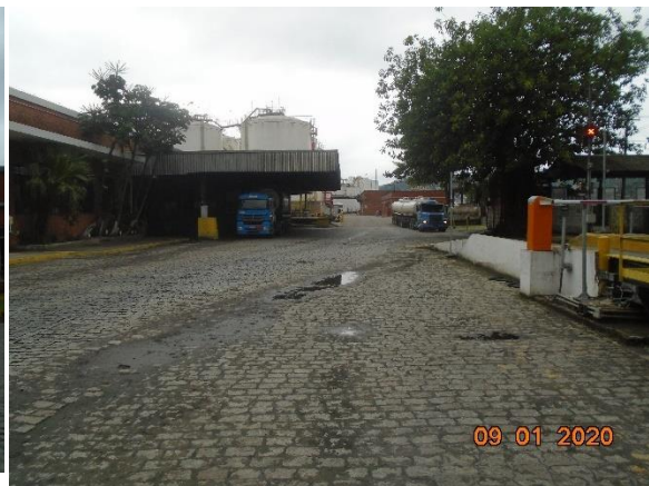
Foto 1.5.2-8: Posto de espera - Área III.
