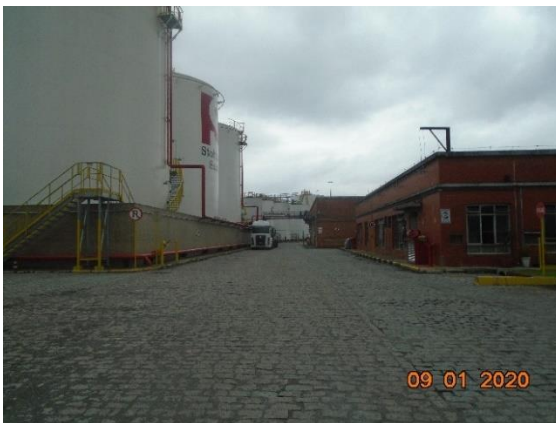
Foto 1.5.2-7: Posto de espera - Área III.
