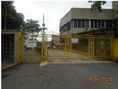
Foto 2.2.1-1: Acesso de veículos – Área I
