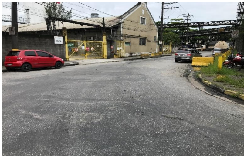
Foto 2.2.2-1: Rua Dr. Alberto Schwedtzer. - Faixa de rolamento com excesso de desníveis ao longo do greide.
