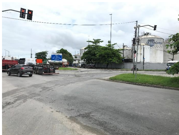
Foto 2.2.2-4: Cruzamento entre a Rua Augusto Scaraboto com a Rua Dr. Alberto Schwedtzer – ausência de calçada.
