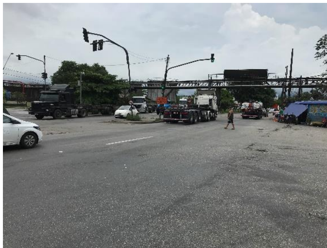
Foto 2.2.2-2: Cruzamento entre a Rua Augusto Scaraboto com a Rua Dr. Alberto Schwedtzer – ausência de faixa de pedestres.
