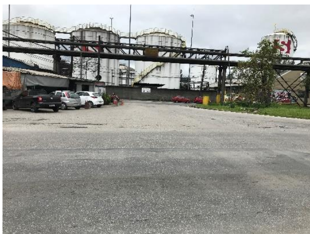
Foto 2.2.2-3: Foto 2.5 2: Cruzamento entre a Rua Augusto Scaraboto com a Rua Dr. Alberto Schwedtzer – ausência de faixa de pedestres.
