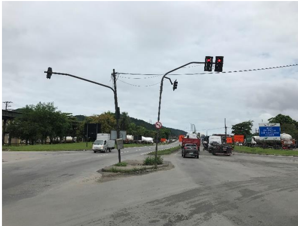
Foto 2.2.2-5: Cruzamento entre a Rua Augusto Scaraboto com a Rua Dr. Alberto Schwedtzter – ausência de calçada.
