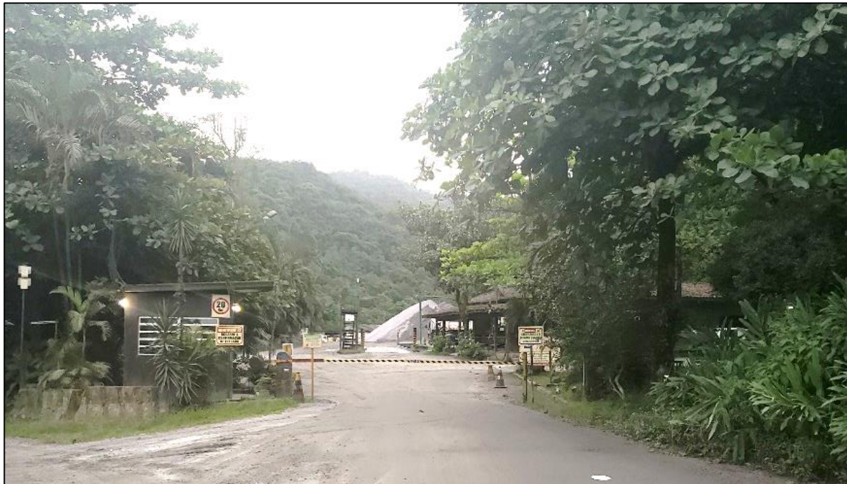
VISTA DAS CONDIÇÕES DE ACESSO À ENGBRITA E PORTARIA.
