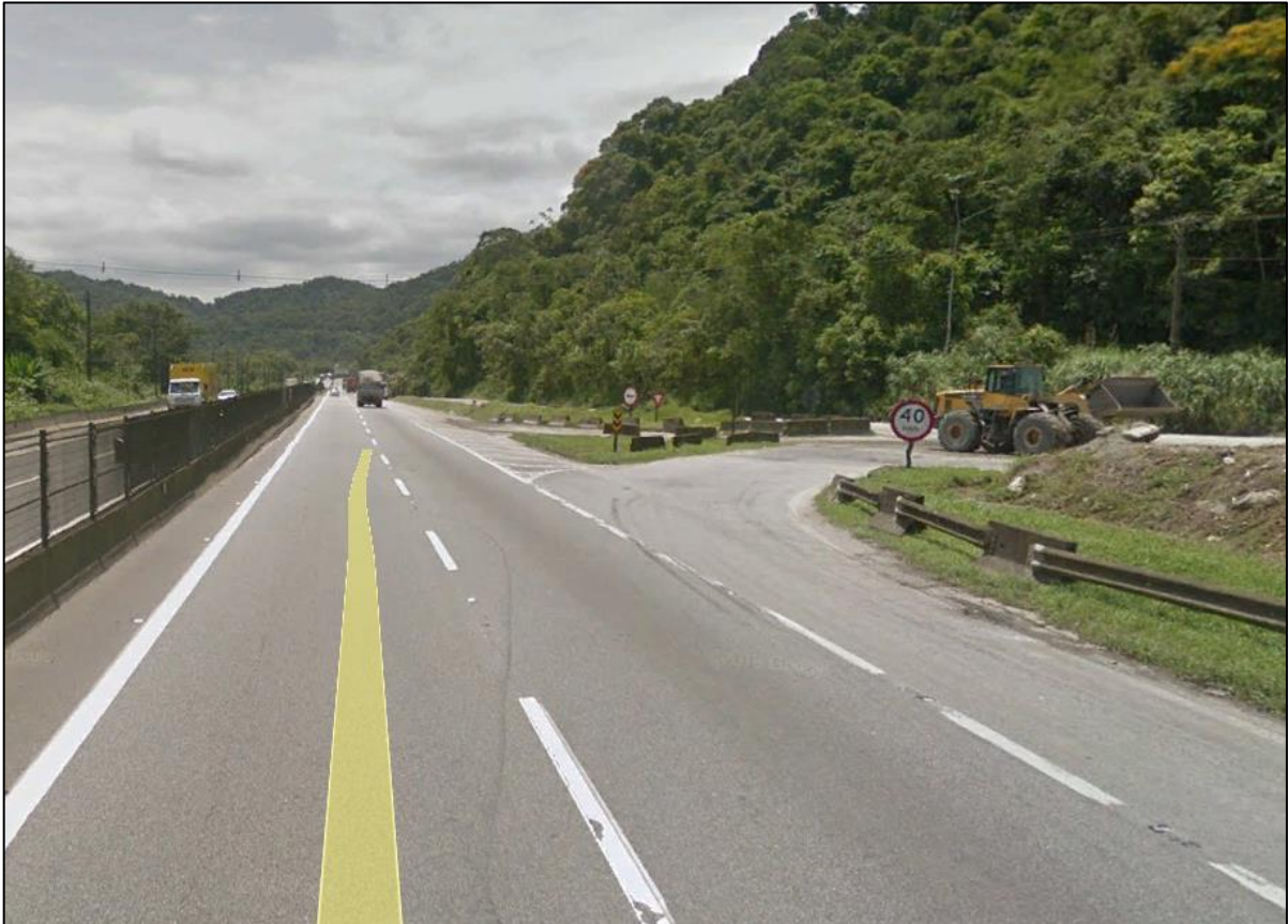
VISTA DAS CONDIÇÕES DE ACESSO ENGBRITA - RODOVIA CONEGO DOMENICO RANGONI E ALÇA DE ACESSO À ESTRADA PARA PORTARIA.
