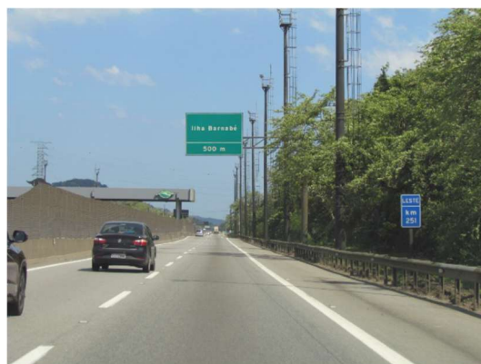
Foto 2.15. - SP-055, sentido Guarujá. A imagem mostra a sinalização vertical de indicação do acesso à Ilha Barnabé, localizado no km 250 + 500m da rodovia.
