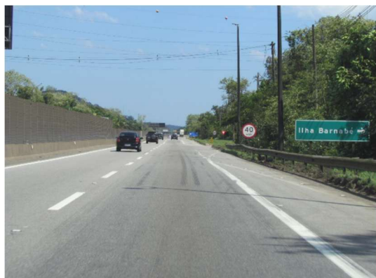
Foto 2.1. – SP-055 – Rodovia Cônego Domênico Rangoni, sentido Guarujá. A imagem mostra o acesso à Estrada Particular da APS, localizado no km 250+500m da SP-055.
