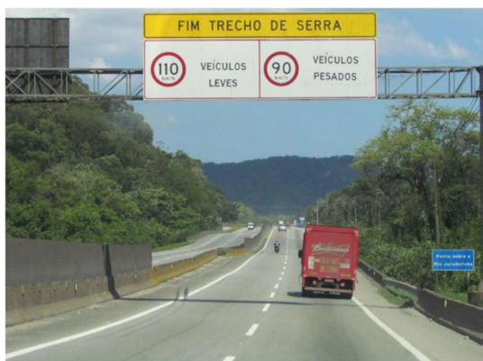
Foto 2.14. - SP-055 – Rodovia Cônego Domêmico Rangoni, sentido Guarujá. Após o trecho de serra, que termina há aproximadamente 2,5 km do acesso à Estrada Particular da APS, as regulamentações de velocidade voltam às condições anteriores. Entretanto, a via mantém seu desenvolvimento com duas faixas de rolamento por sentido.
