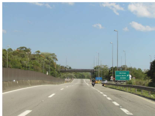
Foto 2.15. - SP-055, sentido Guarujá. No km 248 da rodovia, ou seja, aproximadamente 2,5 km do acesso à Ilha Barnabé está localizado o dispositivo de retorno da via. Tal dispositivo possibilita que os veículos com viagem originada no terminal retomem o trajeto sentido Cubatão e demais localidades.
