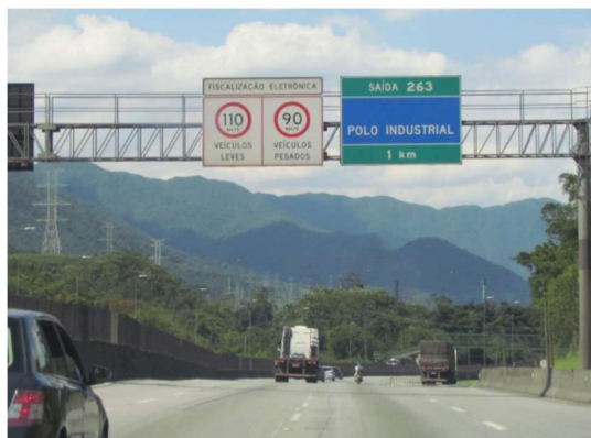
Foto 2.14. - SP-055 – Rodovia Cônego Domêmico Rangoni, sentido Guarujá, após o acesso à área urbana de Cubatão. Neste trecho a via desenvolve-se em pista dupla, com três faixas de rolamento por sentido. A via encontra-se em bom estado de conservação, com sinalizações horizontal e vertical adequadas. Sua velocidade máxima está regulamentada em 110Km/h para veículos leves e 90km/h para veículos pesados.
