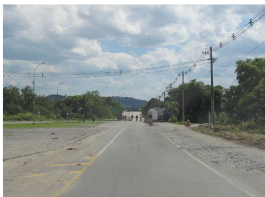
Foto 2.7. – A pós aproximadamente 1.700 metros a partir da SP-055 encontra-se o pré gate. Neste ponto, coincidente com o acesso à DP World, é realizada a primeira triagem dos veículos destinados ao terminal da Adonai, impedindo aqueles que não possuem o devido agendamento de adentrarem no complexo portuário, evitando que vários caminhões cheguem ao mesmo tempo no terminal.
