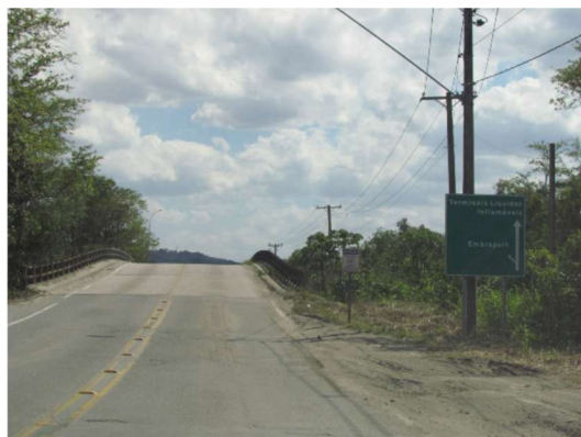
Foto 2.6. – Trecho inicial de Obra de Arte Especial (OAE) sobrepondo curso d'água existente no local. No total, e Estrada Particular da APS possui duas OAE's.
