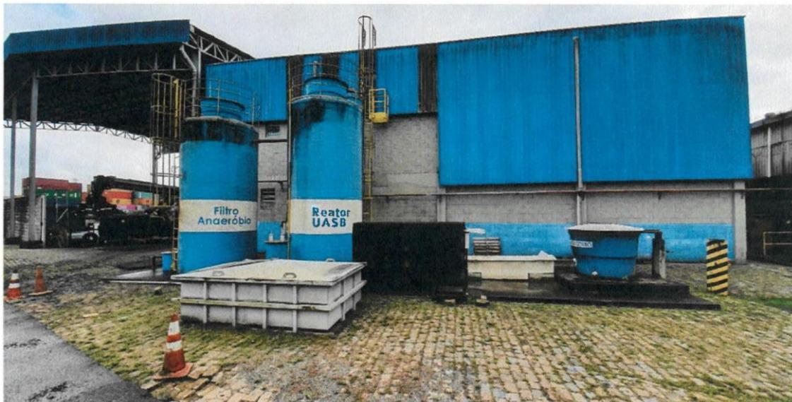
*Figura 2: Figura extraída do EIV: Estação de Tratamento de Efluentes (ETE) Biológica do Terminal CLIA Santos*
