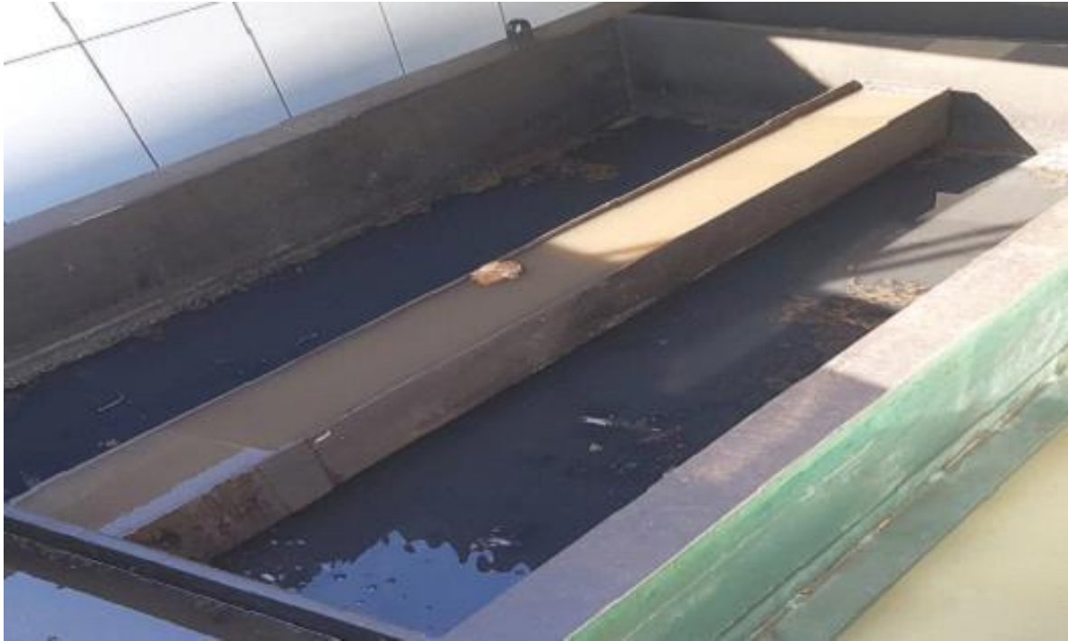
Figura 7 – Imagem extraída do EIV em que mostra a Caixa SAO da saída do sistema de lavagem de veículos.
