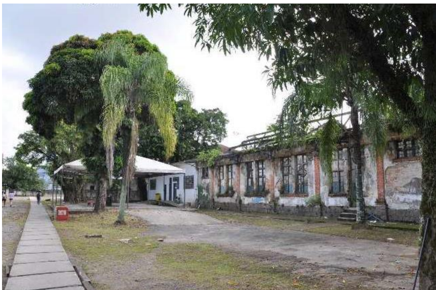
Figura 4 – Imagem extraída do EIV em que mostra o estado atual do imóvel que antes abrigava o antigo Colégio Docas.
