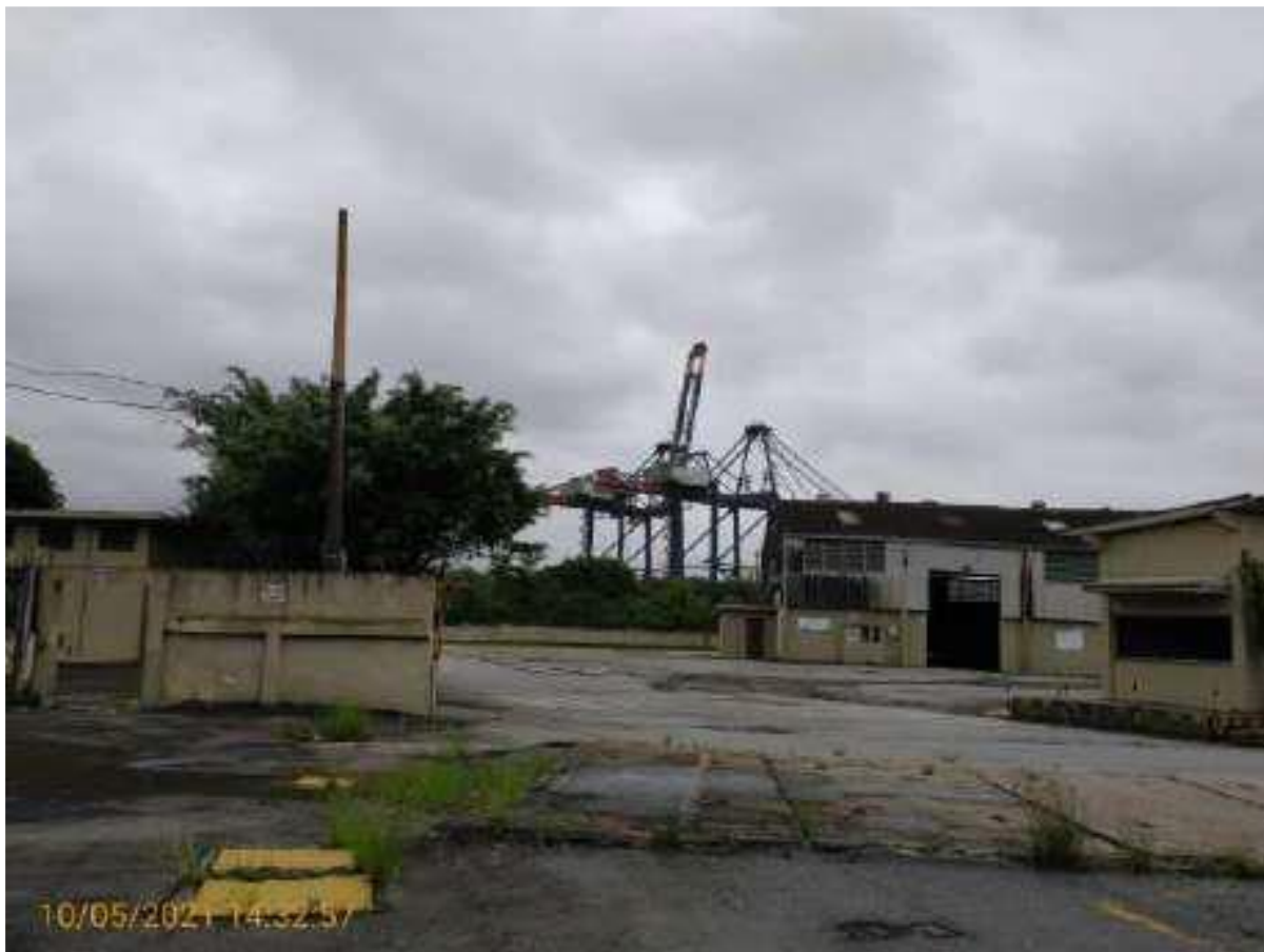
Figura 2 – Imagem extraída do EIV em plano aberto da vista geral da área do empreendimento.
