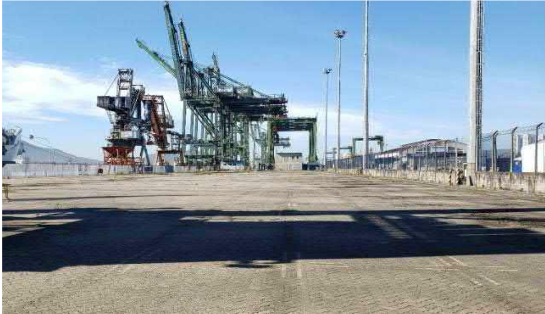
Figura 3 – Imagem extraída do EIV em que se pode observar a área do futuro armazém as estruturas remanescentes a serem demolidas e o pavimento articulado intertravado de blocos de cimento.
