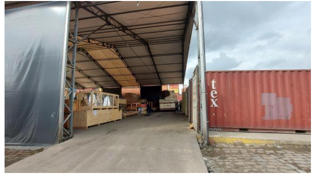
Figura 5: Imagem extraída do EIV: Interior do Armazém Lonado 1
