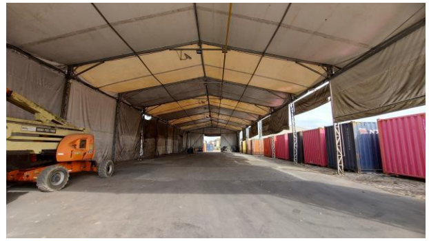
Figura 7- Imagem extraída do EIV : Interior do Armazém Lonado 3
