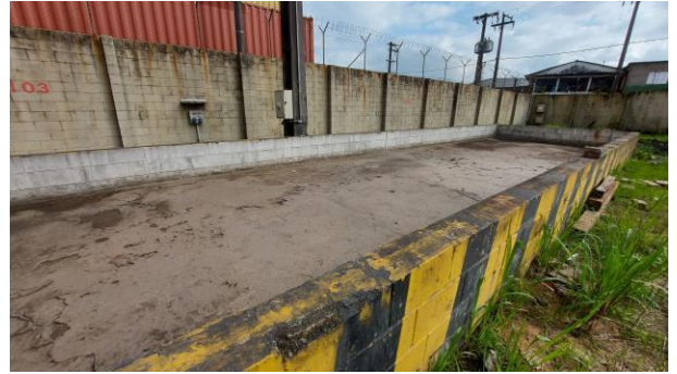
Figura 9-Figura extraída do EIV: Interior do dique de contenção
