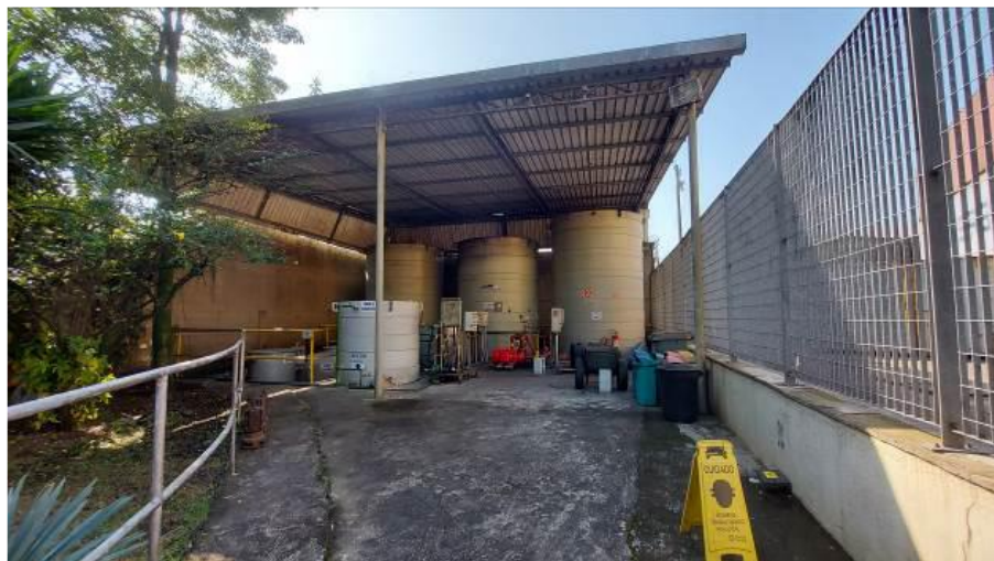
Figura 11- Figura extraída do EIV : Vista da ETE-BIO 01
