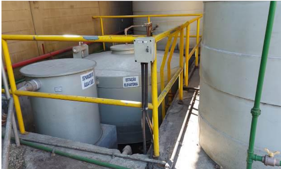
Figura 18- Figura extraída do EIV: Separador Água e Óleo (SAO) - BIO02.
