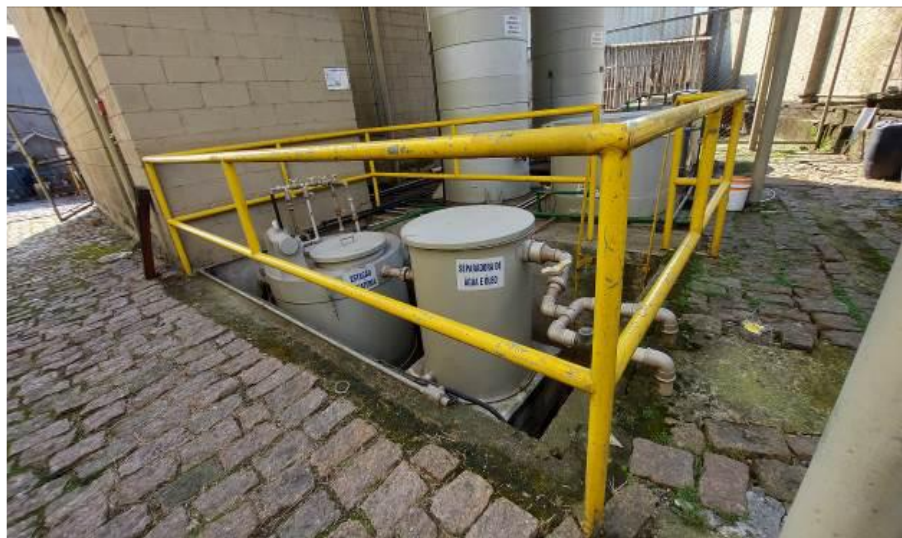
Figura 16: Imagem extraída do EIV: Separador Água e Óleo (SAO)
