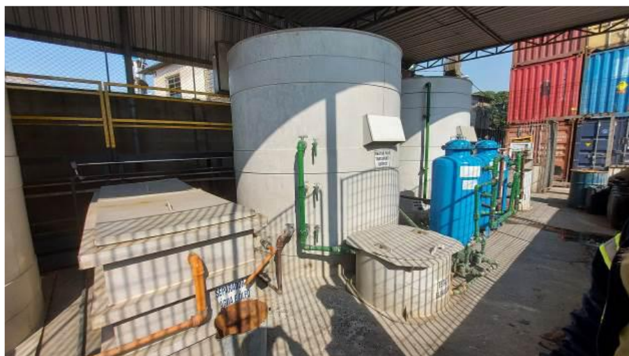
Figura 17 - Figura extraída do EIV: Separador Água e Óleo (SAO) da ETE- ETE-FQ (à esquerda).
