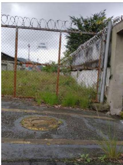
Figura 2.3.3-1. Caixa de inspeção da tubulação de esgotos, cuja rede geral é de responsabilidade da SPA.
