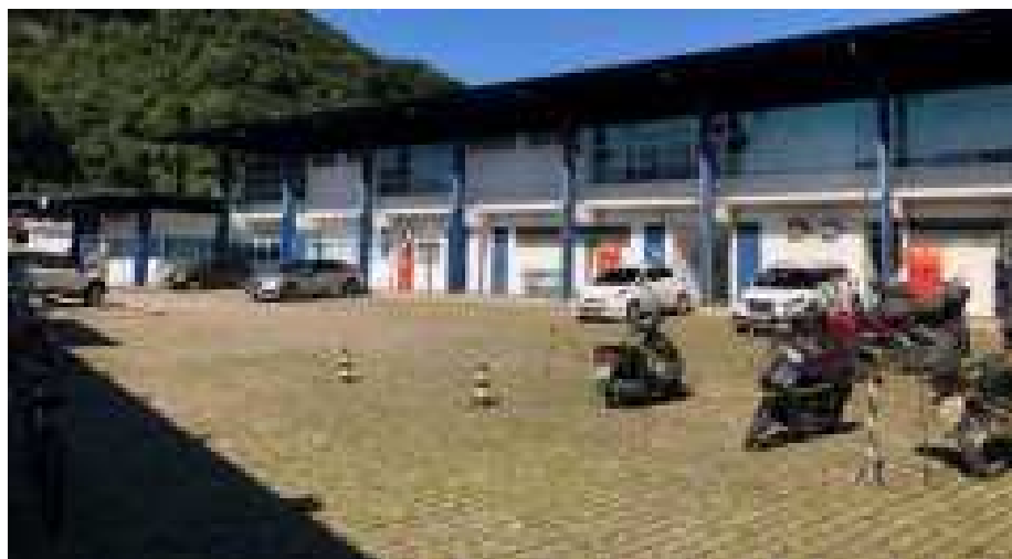
Figura 22. Detalhe do terreno plano e do prédio administrativo existente
