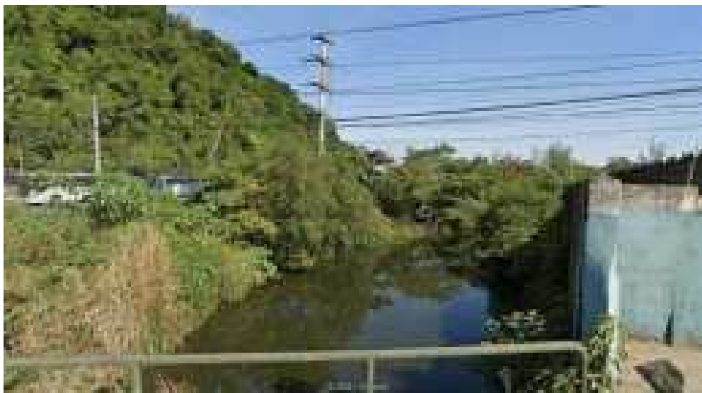
Figura 20. Vista do rio São Jorge e suas margens no sentido sudeste do empreendimento (ponte da Rua Júlia Ferreira de Carvalho (tomada da foto) e Av. Nossa Senhor de Fátima (à esquerda)).
