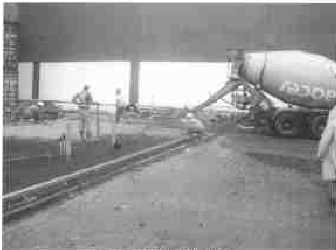
Foto 7. Início da Concretagem
