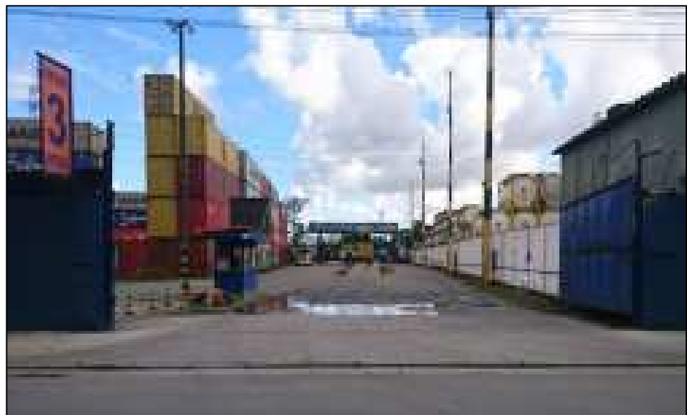
Figura 10 – Portaria de Entrada de Cargas e Serviço nº 3
