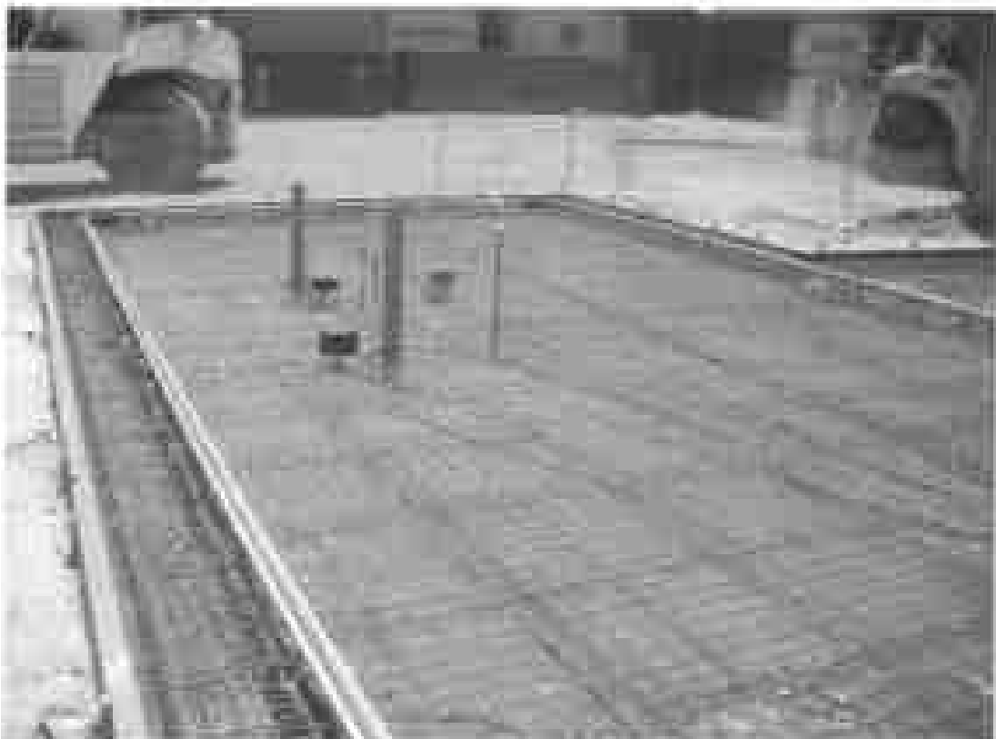
Foto 6: Armagem da tela dupla com treliças, aterramento e tubos de proteção.
