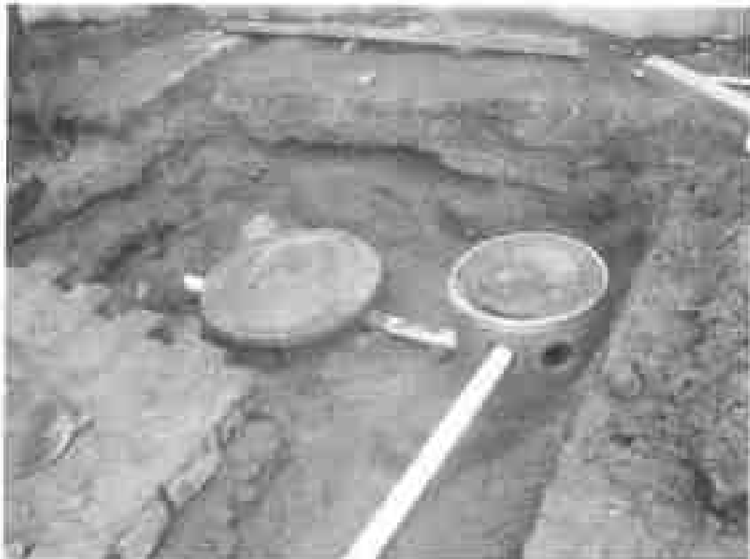
Foto 5: Instalação de caixa separadora água / areia e água / óleo.
