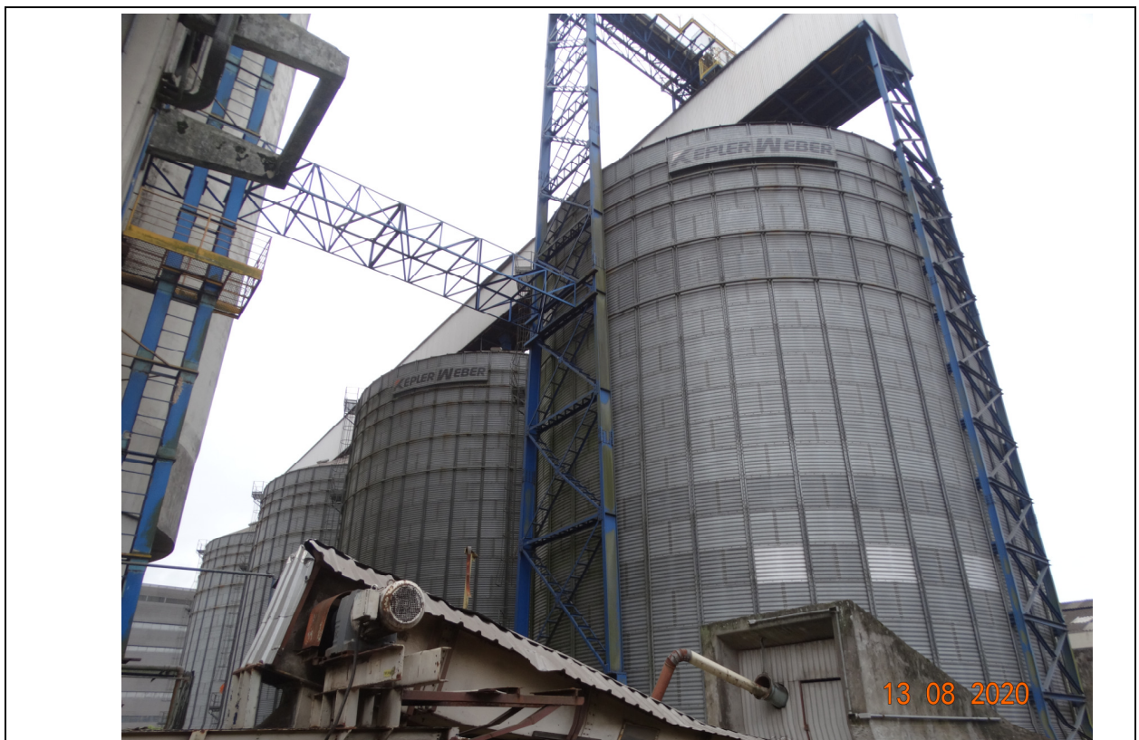
FOTO 04 – VISTA DOS 04 (QUATRO) SILOS METÁLICOS.
