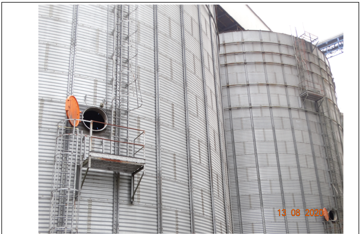
FOTO 36 – VISTA DOS SILOS METÁLICOS.
