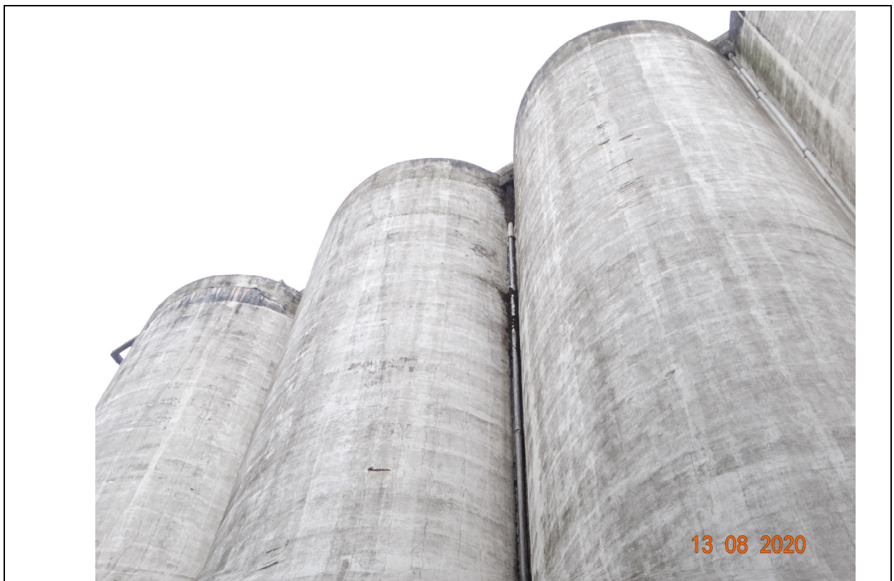
FOTO 28 – OUTRA VISTA DA FACE EXTERNA DOS SILOS DE CONCRETO ARMADO E DUTOS DE CAPTAÇÃO DE ÁGUA PLUVIAL.
