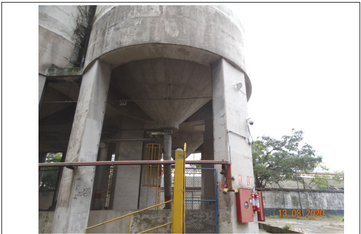
FOTO 30 – OUTRA VISTA DOS PILARES DE SUSTENTAÇÃO DOS SILOS DE CONCRETO ARMADO.
