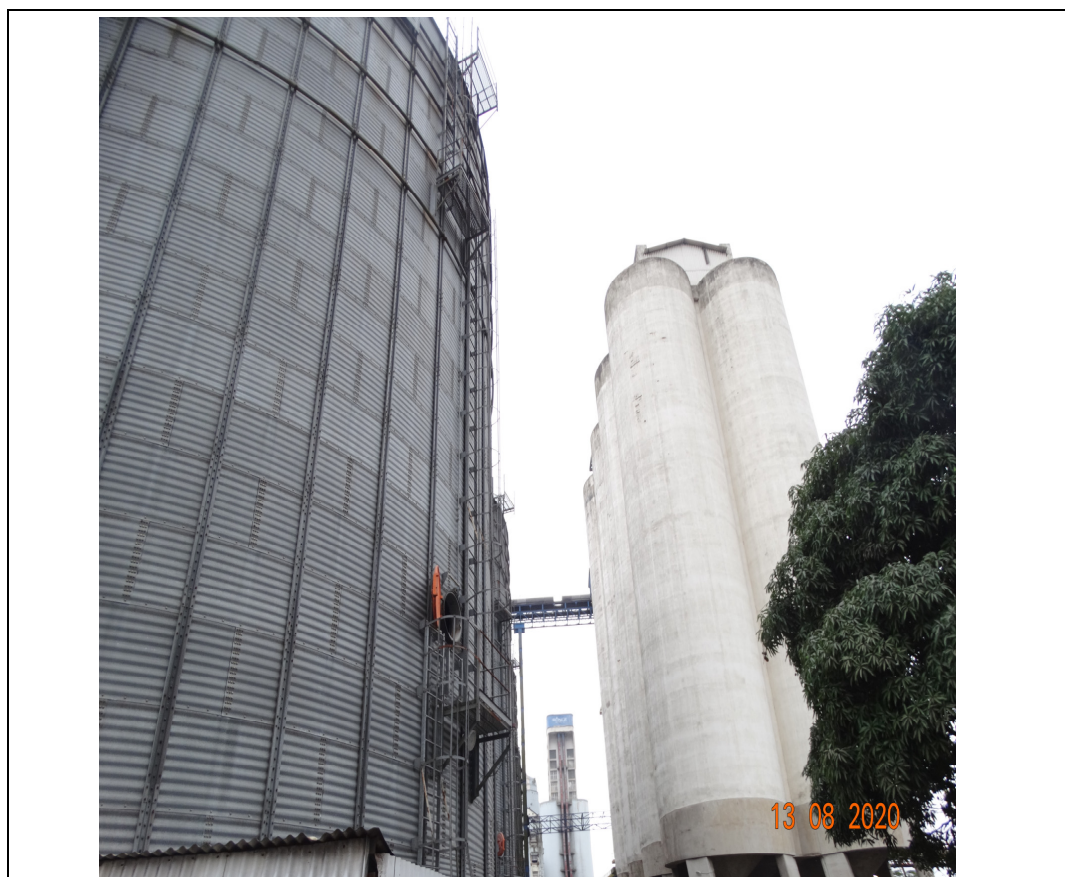
FOTO 38 – OUTRA VISTA ENTRE OS SILOS METÁLICOS E SILOS DE CONCRETO ARMADO.
