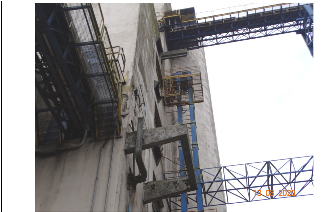
FOTO 07 – ESTRUTURA DE CONCRETO ARMADO EM BALANÇO E ESTRUTURAS METÁLICAS ENGASTADAS (CORREIAS TRANSPORTADORAS).
