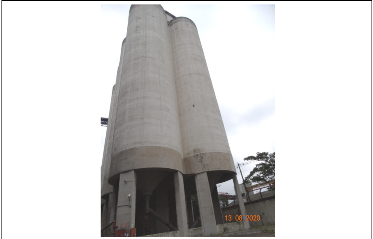
FOTO 33 – OUTRA VISTA EXTERNA DOS SILOS DE CONCRETO ARMADO.
