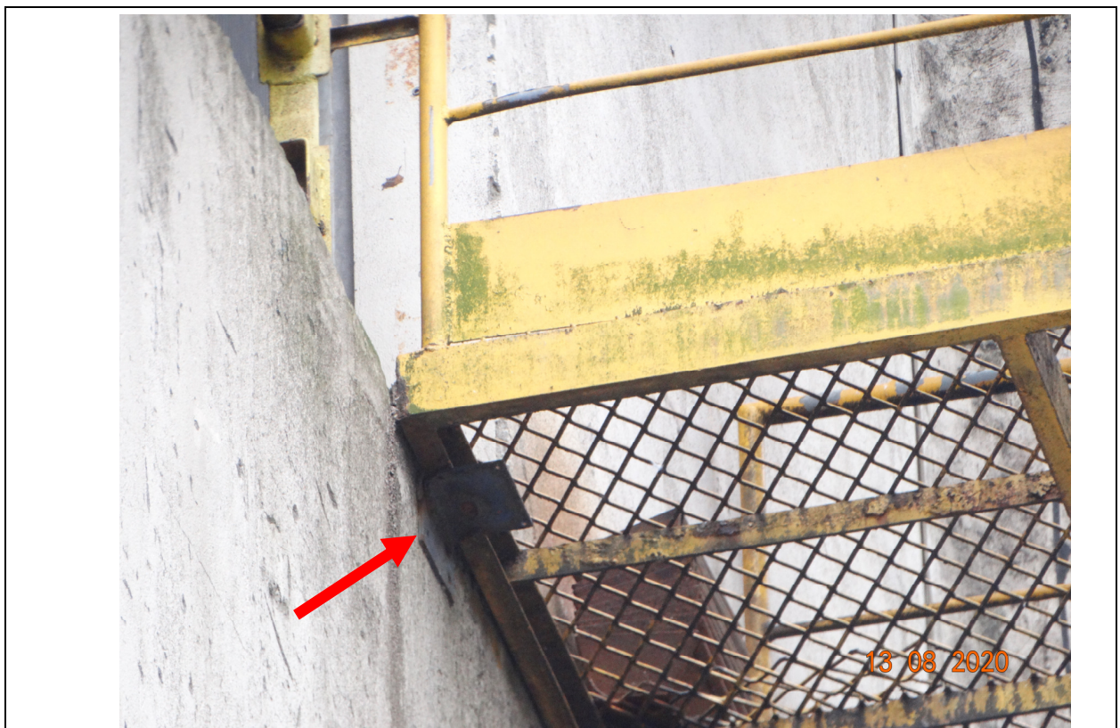
FOTO 10 – VISTA DA CANTONEIRA DE FIXAÇÃO DA ESTRUTURA METÁLICA NA ESTRUTURA DE CONCRETO ARMADO.
