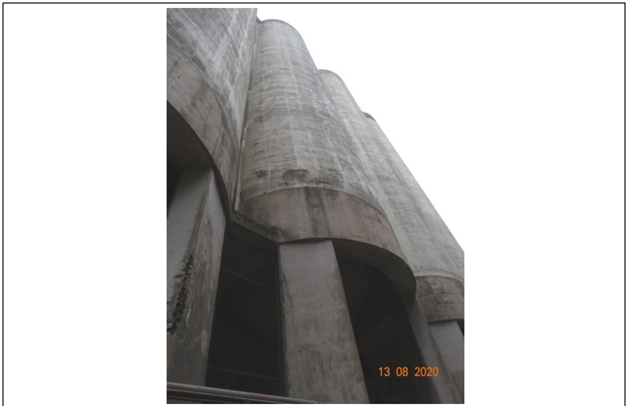
FOTO 20 – VISTA DE UMA DAS FACES EXTERNAS DOS SILOS DE CONCRETO ARMADO.
