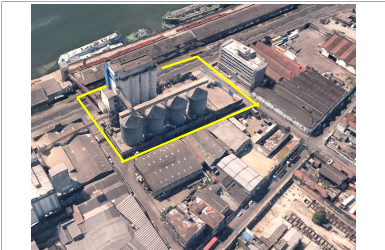
FOTO 01 - VISTA GERAL - ÁREA COM EDIFICAÇÕES DESATIVADAS E INOPERANTES.
