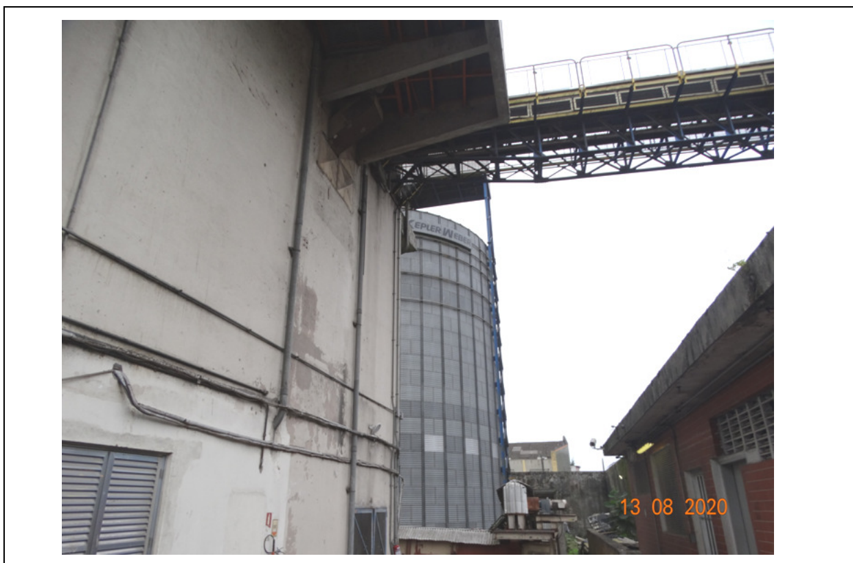
FOTO 02 – VISTA DE ACESSO A ÁREA DA QUADRA B.
