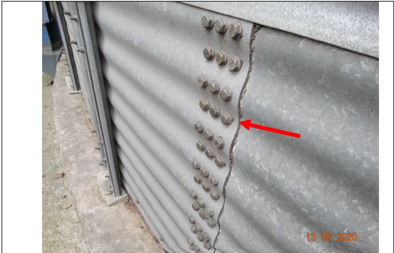
FOTO 13 – OUTRA VISTA DA FIXAÇÃO DAS PEÇAS DOS SILOS METÁLICOS.
