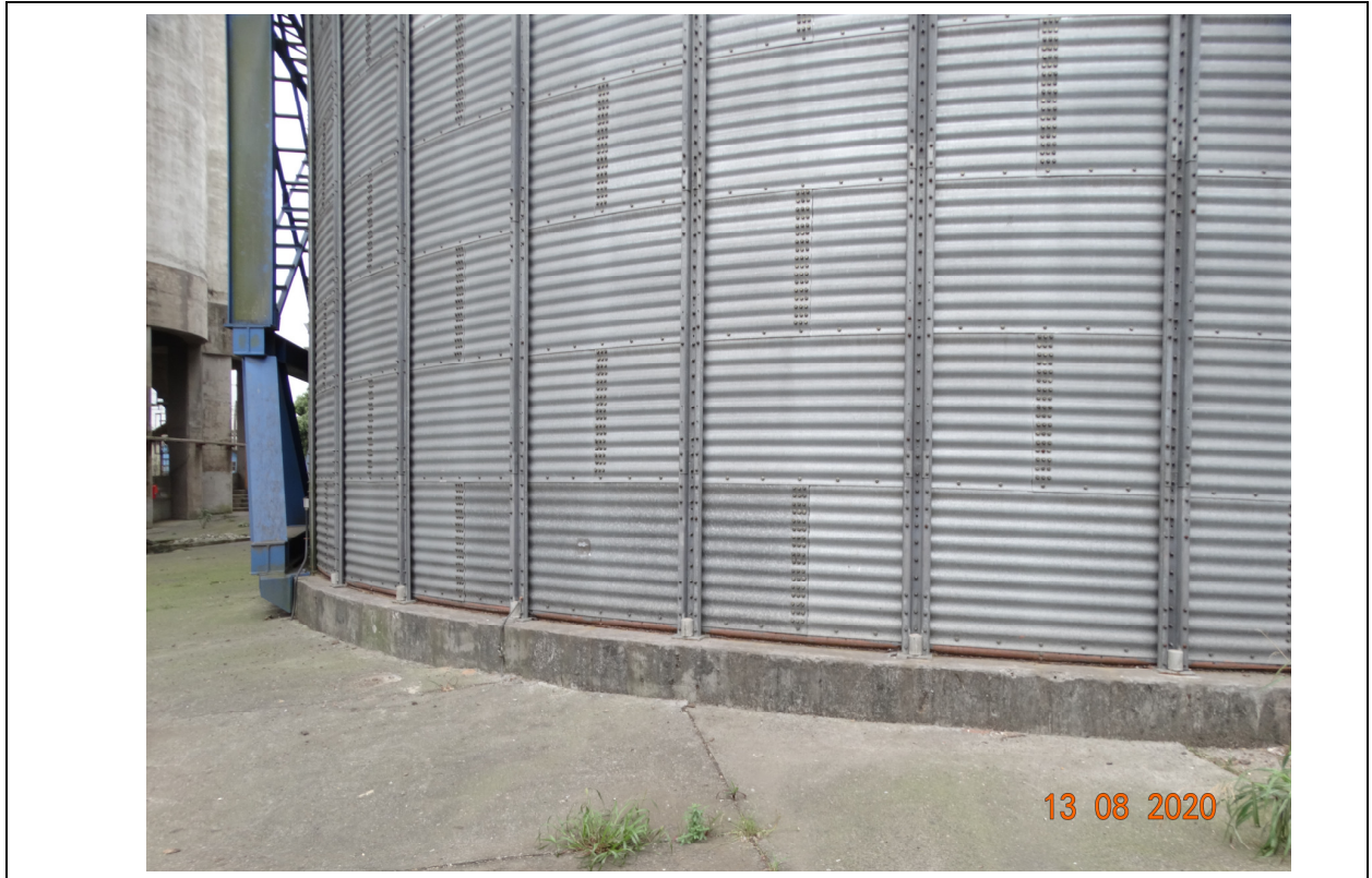
FOTO 11 – VISTA DA BASE E FACE INFERIOR DO SILO METÁLICO.
