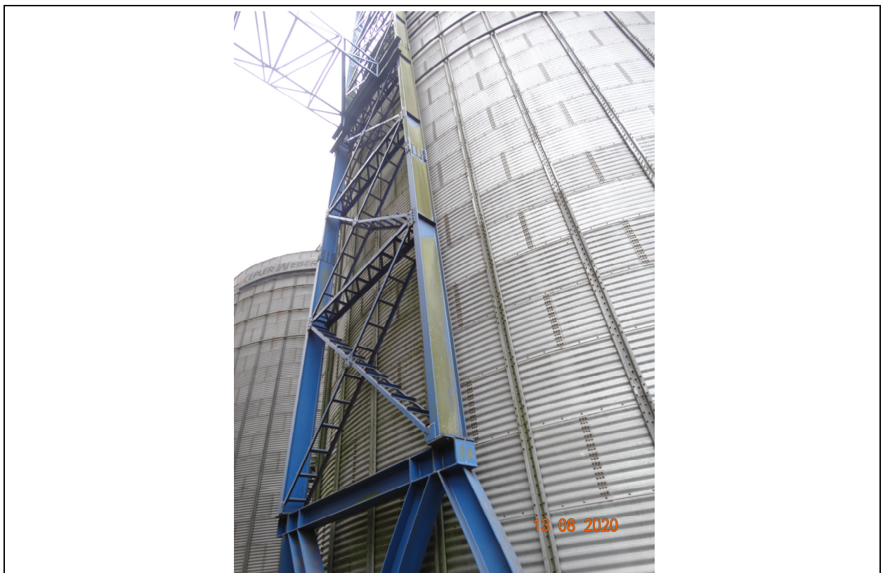
FOTO 14 – VISTA DO SILO E ESTRUTURA METÁLICA DE SUPORTE DA CORREIA TRANSPORTADORA.
