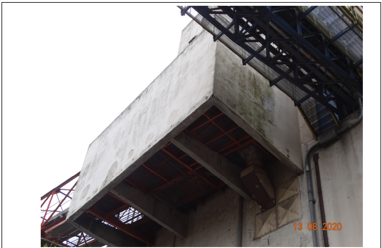
FOTO 06 – OUTRA VISTA DA ESTRUTURA DE CONCRETO ARMADO EM BALANÇO.
