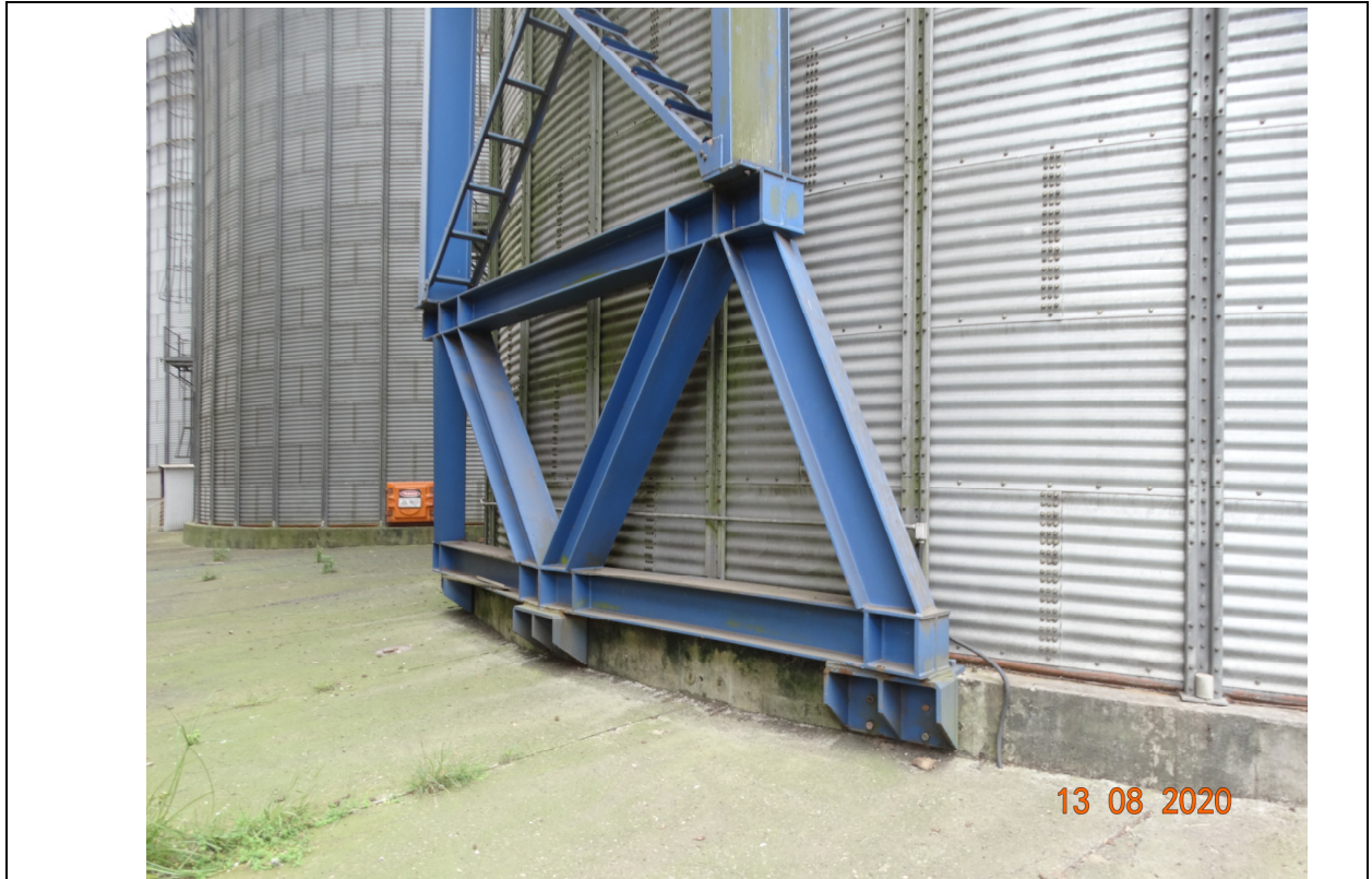
FOTO 15 – BASE DA ESTRUTURA METÁLICA DE SUPORTE DA CORREIA TRANSPORTADORA.
