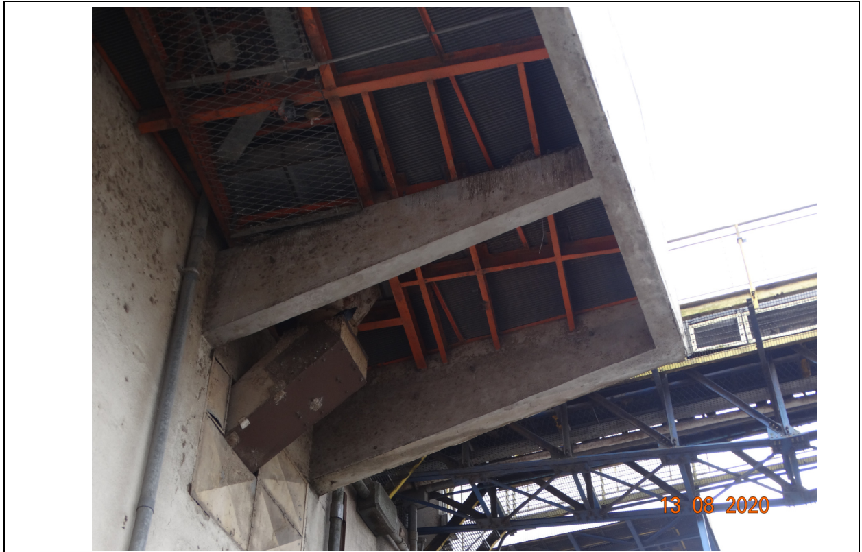
FOTO 03 – VISTA DA FACE INFERIOR DA ESTRUTURA DE CONCRETO ARMADO EM BALANÇO.
