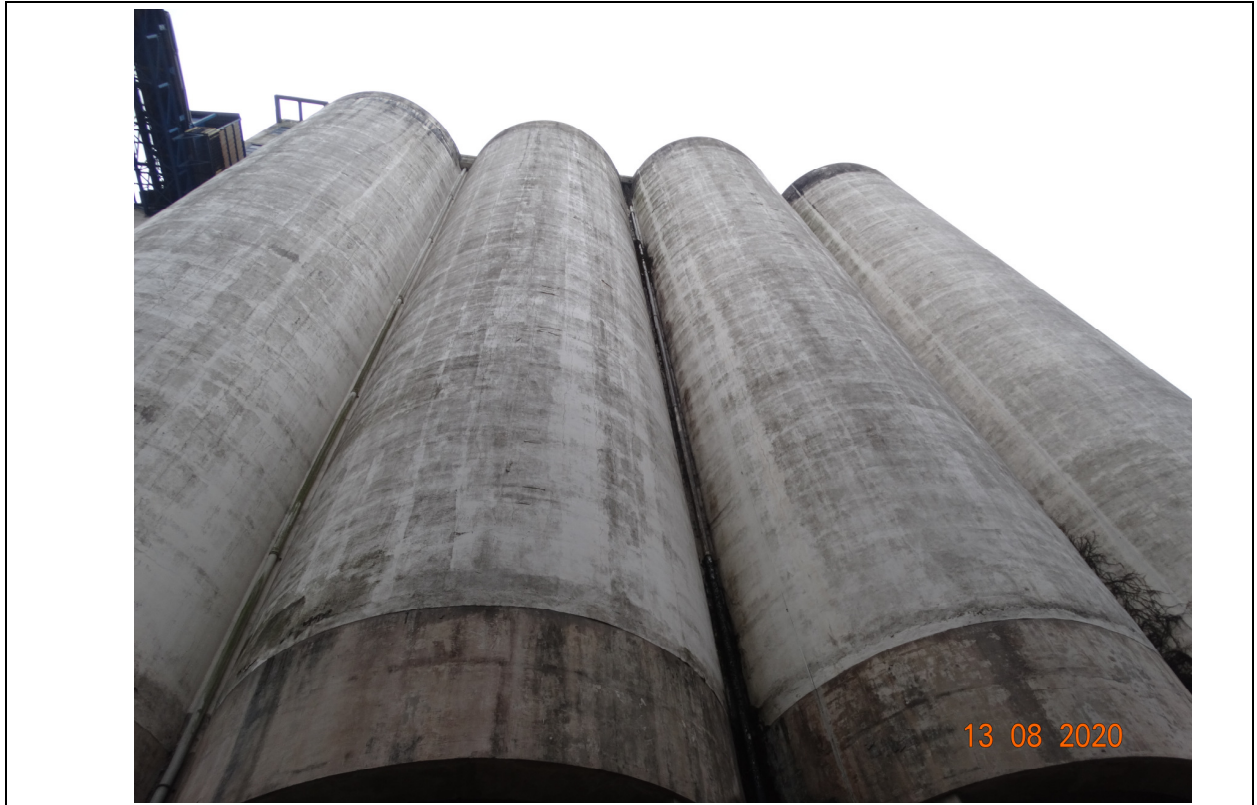
FOTO 23 – VISTA EXTERNA DOS SILOS DE CONCRETO ARMADO.
