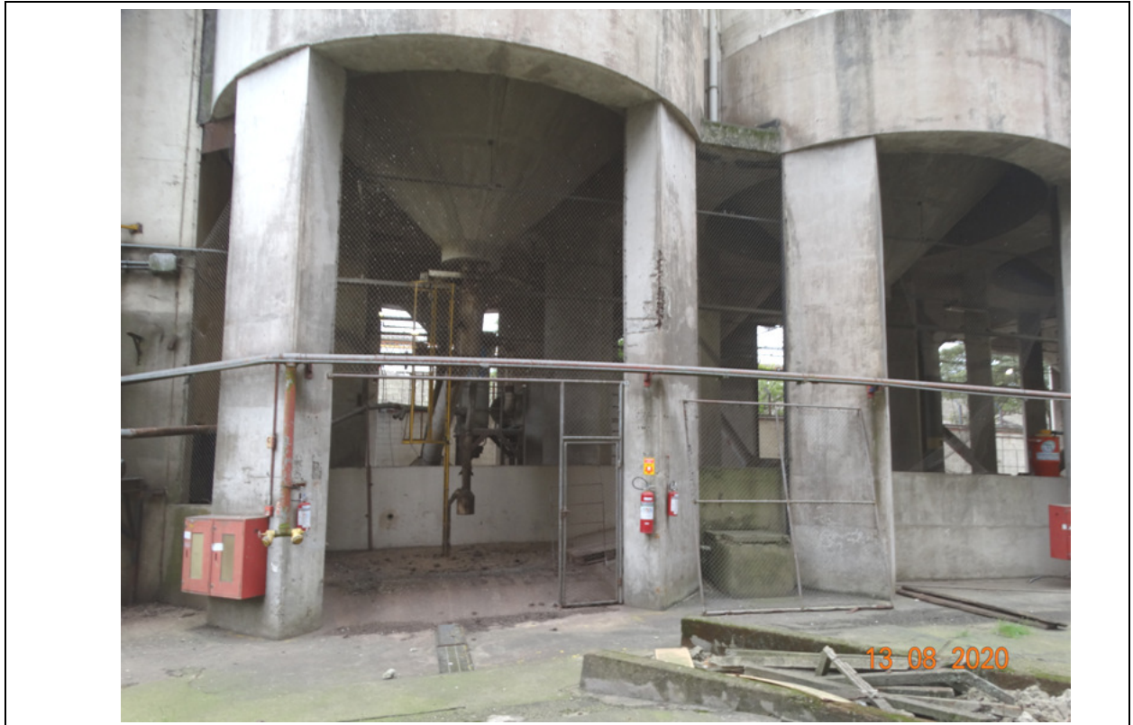
FOTO 17 – VISTA DOS PILARES DE SUSTENTAÇÃO DOS SILOS DE CONCRETO ARMADO.
