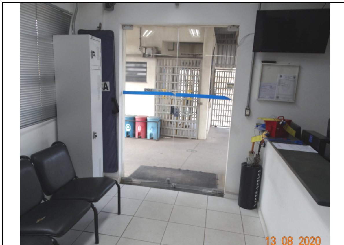
FOTO 80 – RECEPÇÃO DO PRÉDIO ADMINISTRATIVO.
