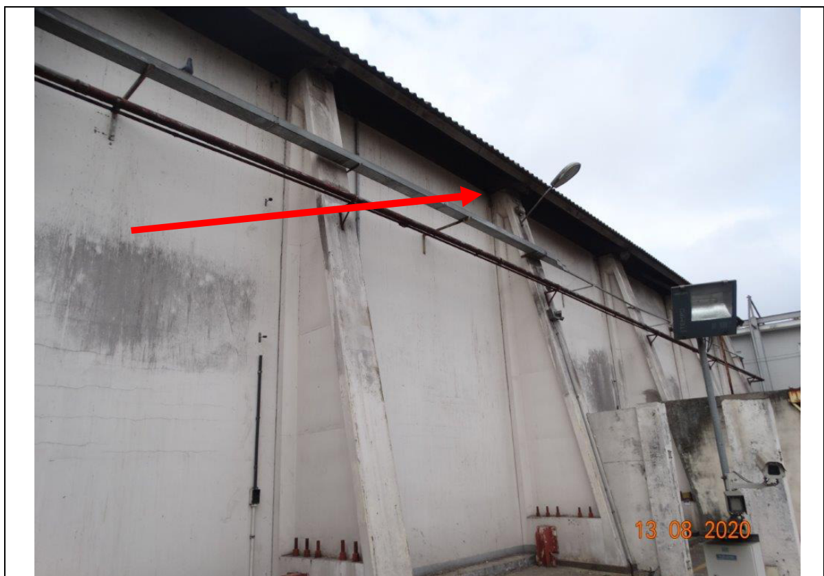
FOTO 49 – SILO 3 - PAREDE EM ESTRUTURA DE CONCRETO ARMADO COM CONTRAFORTES.
