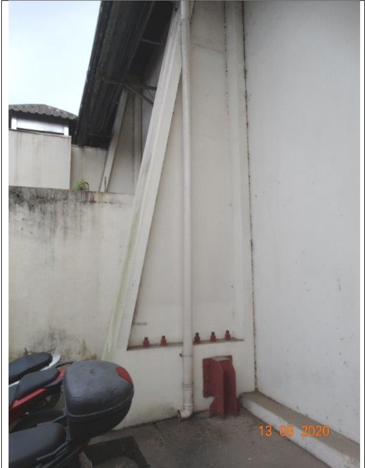
FOTO 52 – SILO 1 - PAREDE EM ESTRUTURA DE CONCRETO ARMADO COM CONTRAFORTES.
