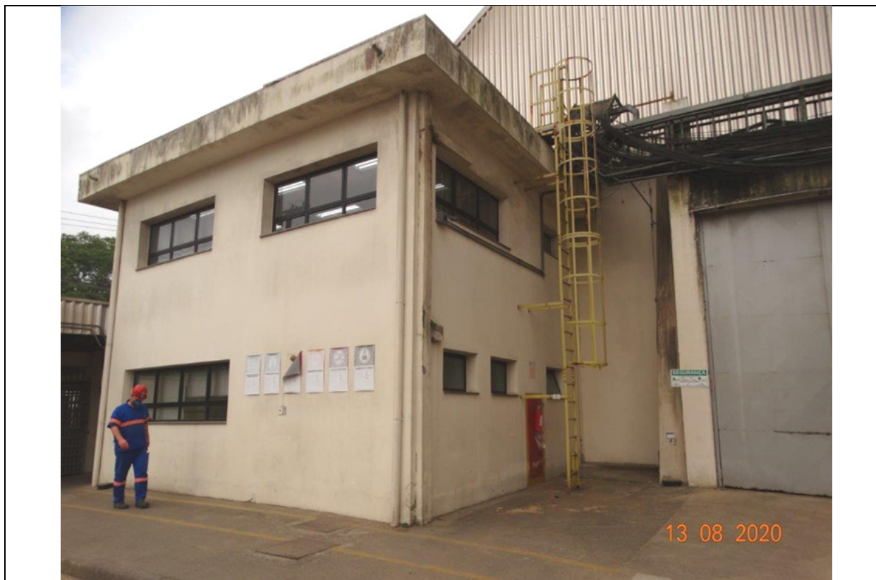
FOTO 06 – VISTA PRÉDIO DA ADM. / SILO 1.
