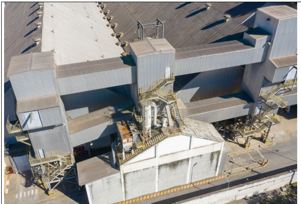
FOTO 86 – VISTA SUPERIOR DAS TORRES METÁLICAS.
