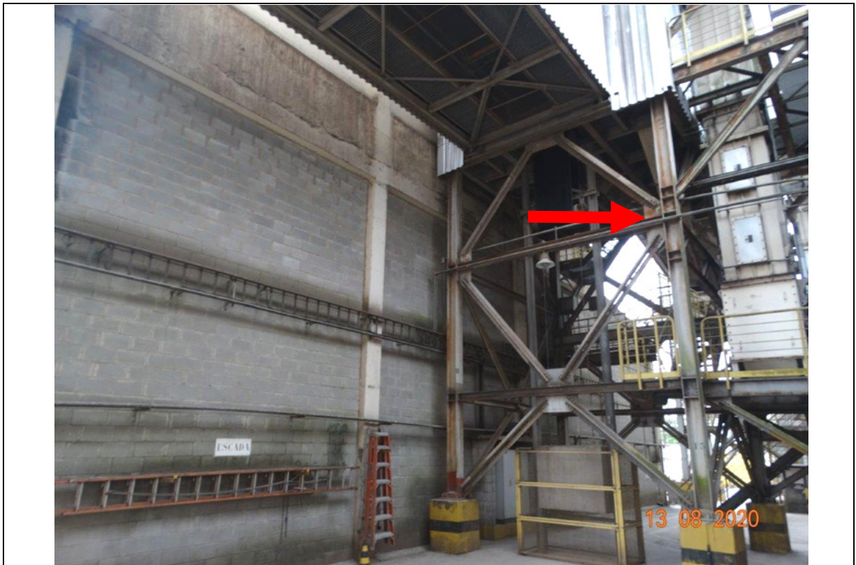
FOTO 21 – PAREDE EXTERNA DA ÁREA DE CARREGAMENTO DE CAMINHÕES, EM FRENTE AOS SILOS 1/2 E PARTE DE ESTRUTURA METÁLICA.
