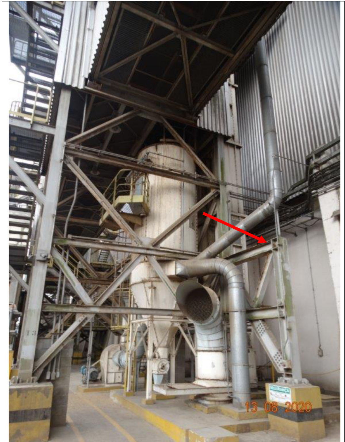
FOTO 28 – ESTRUTURA METÁLICA JUNTO AO SILO 2.
