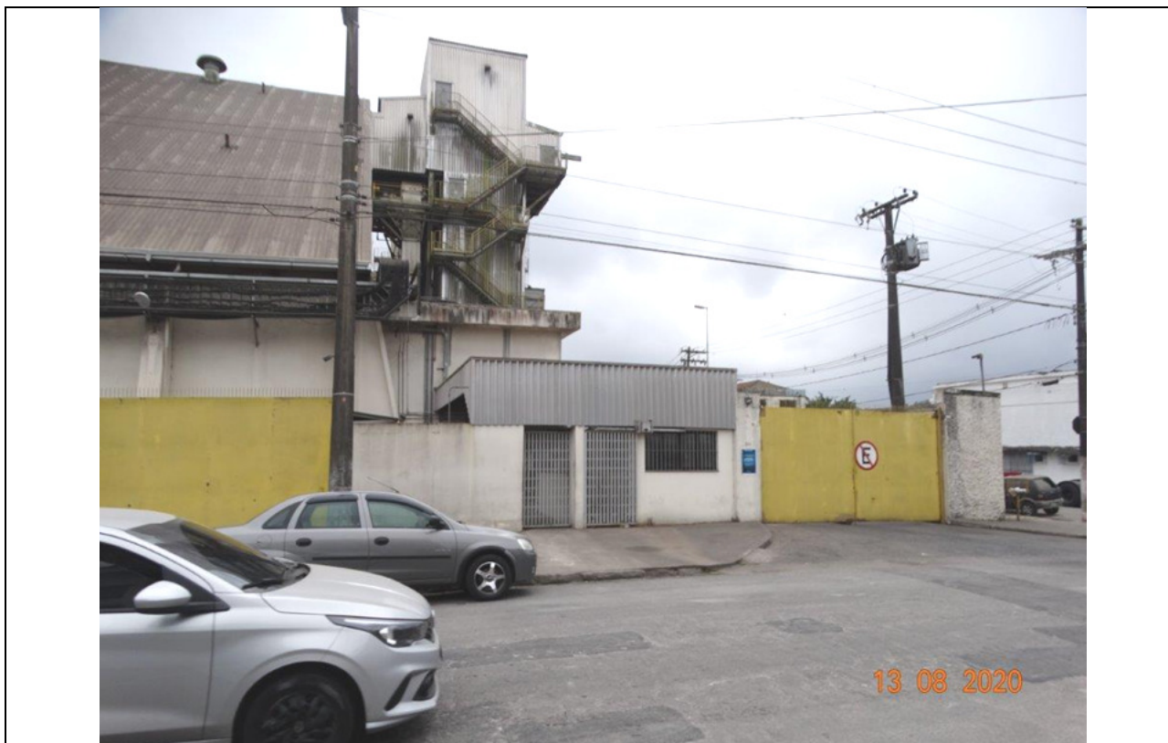
FOTO 02 – VISTA DA ENTRADA PRINCIPAL (RUA JOÃO GUERRA).
