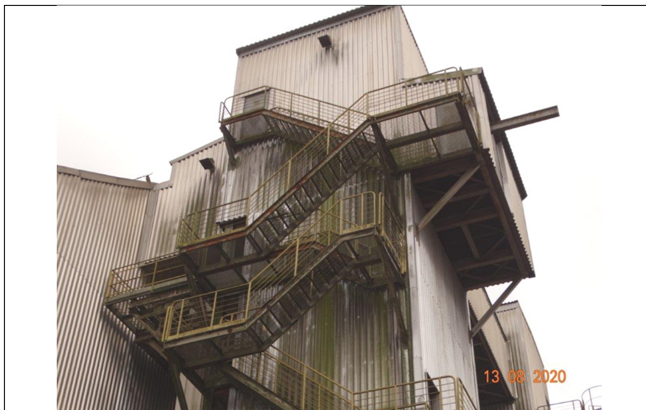
FOTO 04 – ESTRUTURA JUNTO AO SILO 1.
