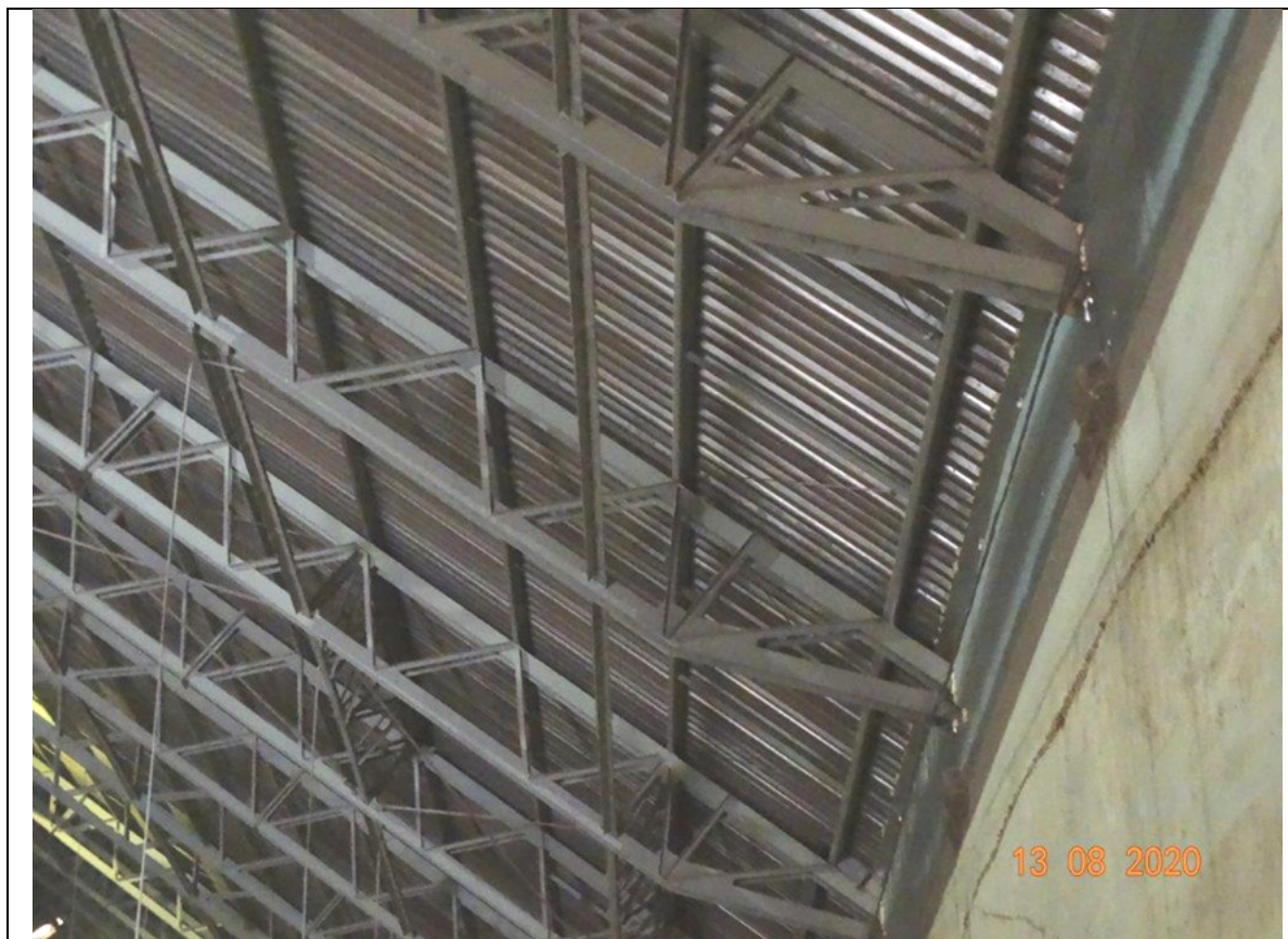
FOTO 74 – SILO 2 - ESTRUTURA DA COBERTURA.
