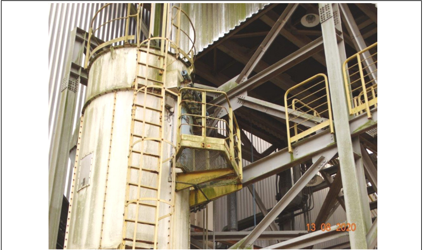
FOTO 08 – ESTRUTURA EM FRENTE AOS SILOS 1/2.
