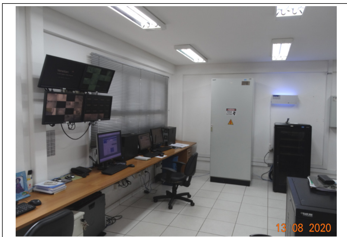
FOTO 81 – 1º ANDAR - PRÉDIO ADMINISTRATIVO.
