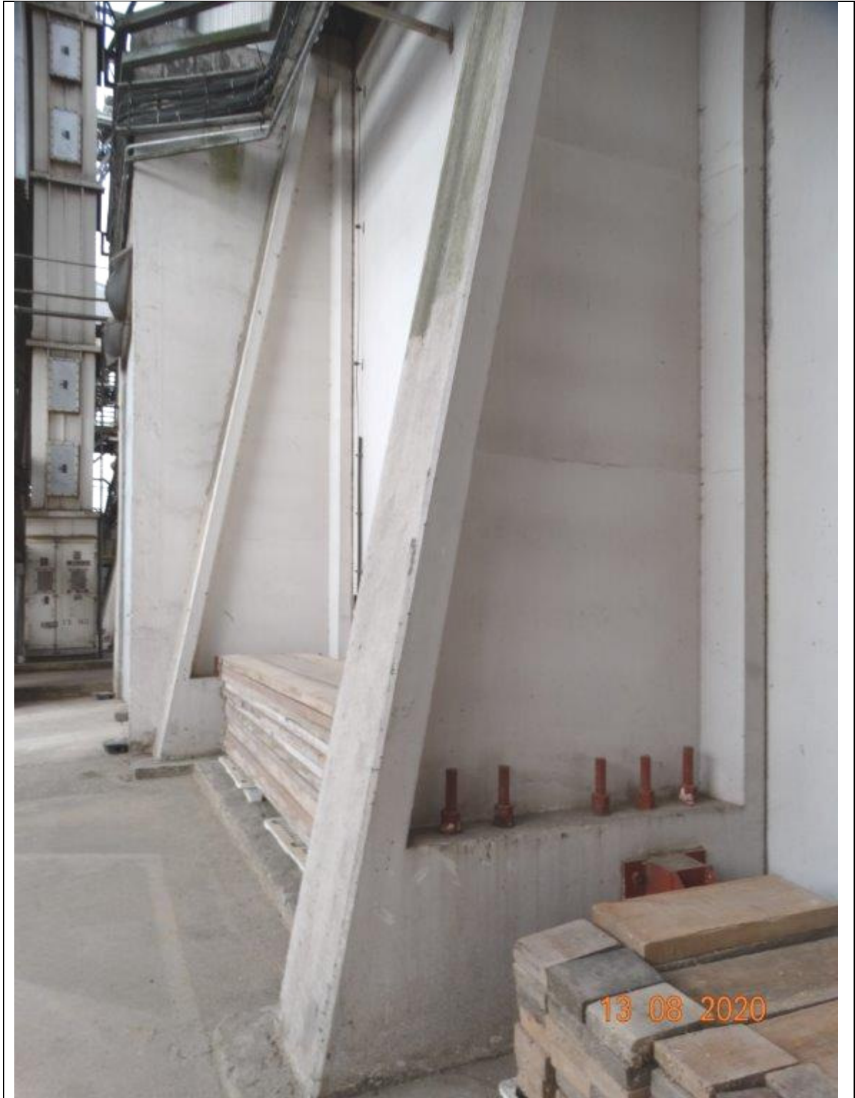
FOTO 27 – SILO 2 - PAREDE EM ESTRUTURA DE CONCRETO ARMADO COM CONTRAFORTES.
