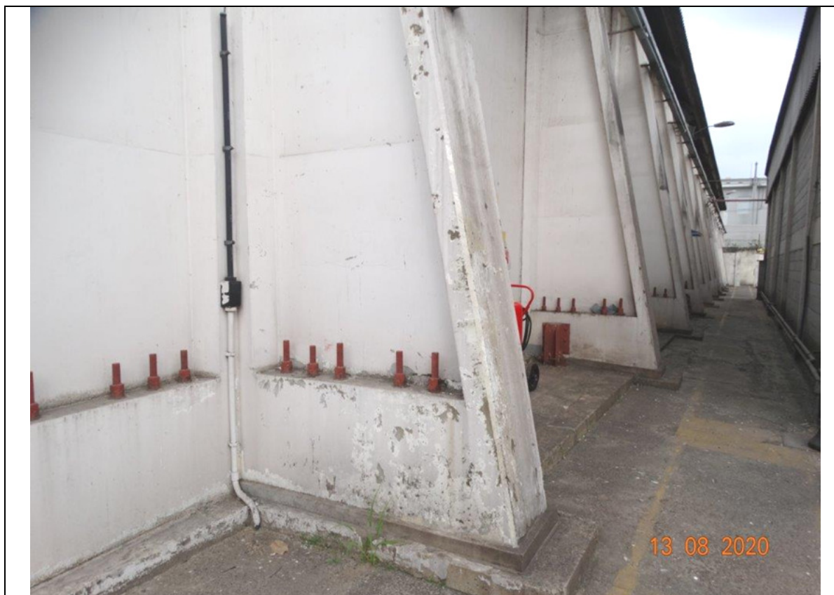
FOTO 44 - SILO 3 - PAREDE EM ESTRUTURA DE CONCRETO ARMADO COM CONTRAFORTES.
