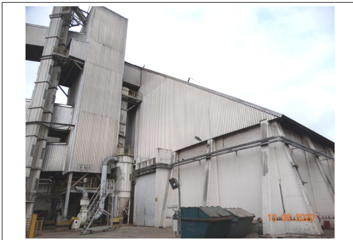
FOTO 41 – ESTRUTURA METÁLICA JUNTO AO SILO 3.
