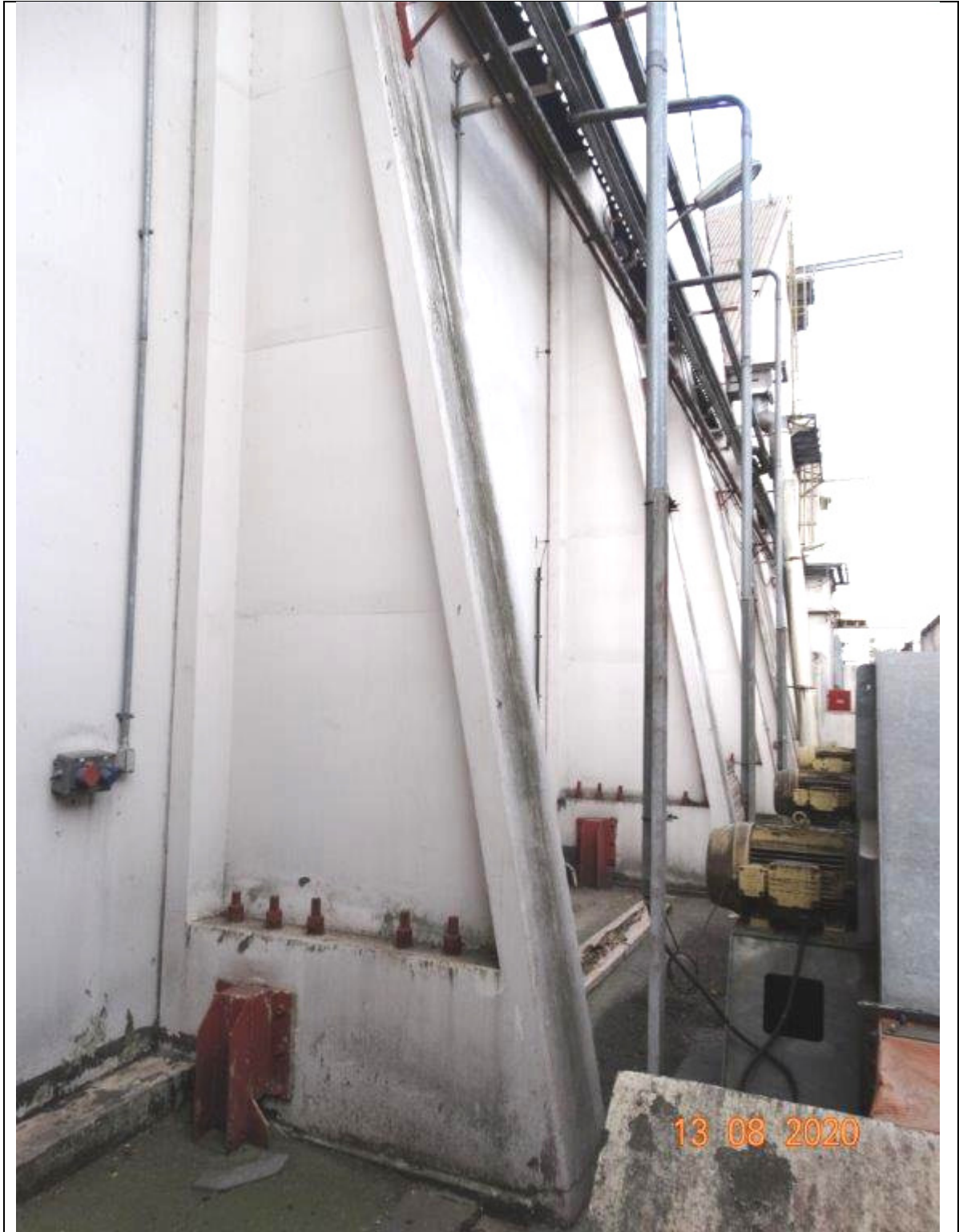
FOTO 70 – SILO 3 - PAREDE EM ESTRUTURA DE CONCRETO ARMADO COM CONTRAFORTES.
