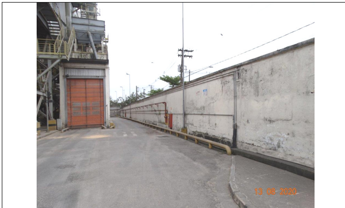
FOTO 07 – MURO LATERAL (RUA PADRE ANCHIETA).
