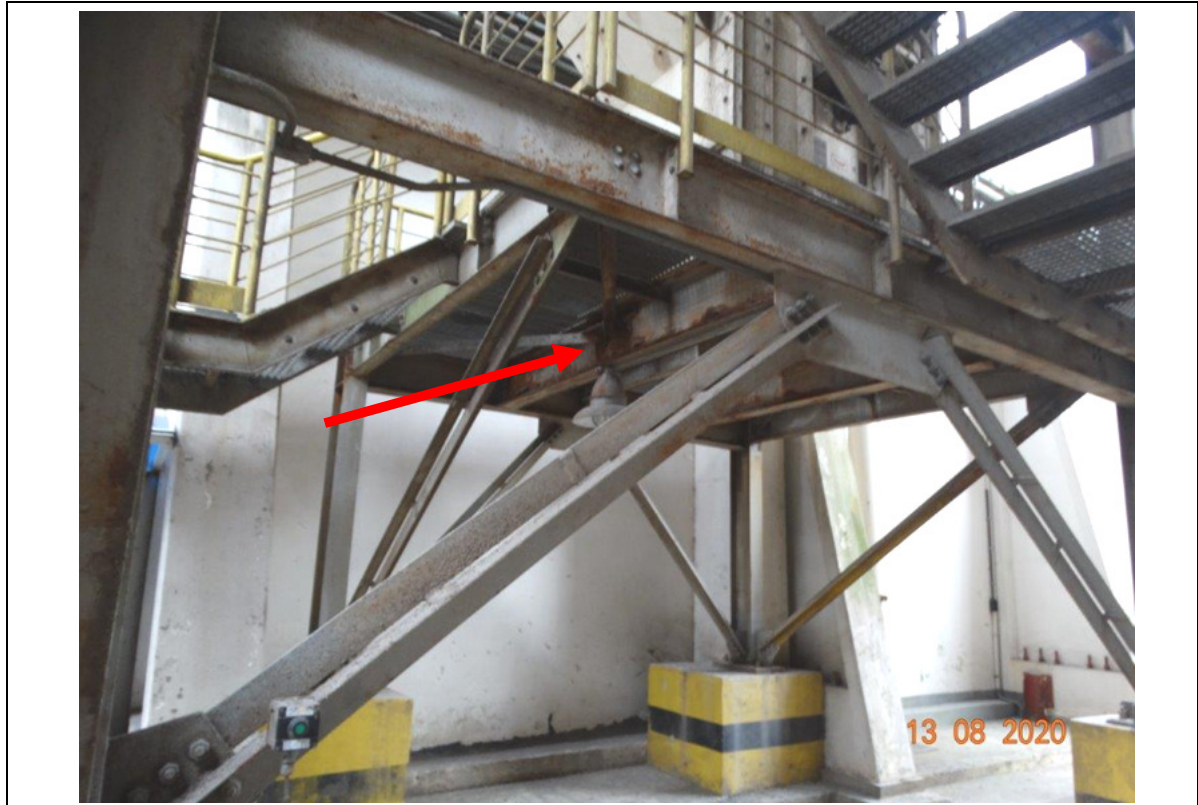
FOTO 18 – ESTRUTURA METÁLICA EM FRENTE AO SILO 1.
