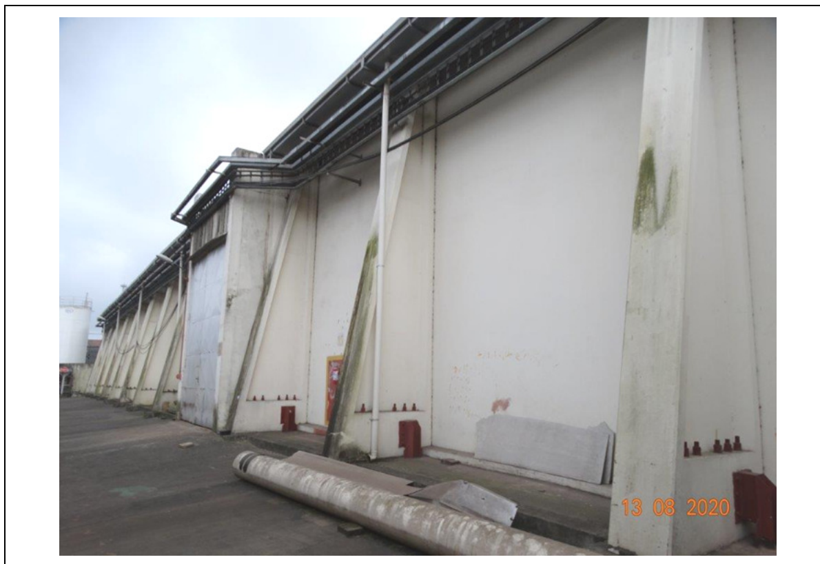
FOTO 53 – SILO 1 - PAREDE EM ESTRUTURA DE CONCRETO ARMADO COM CONTRAFORTES.
