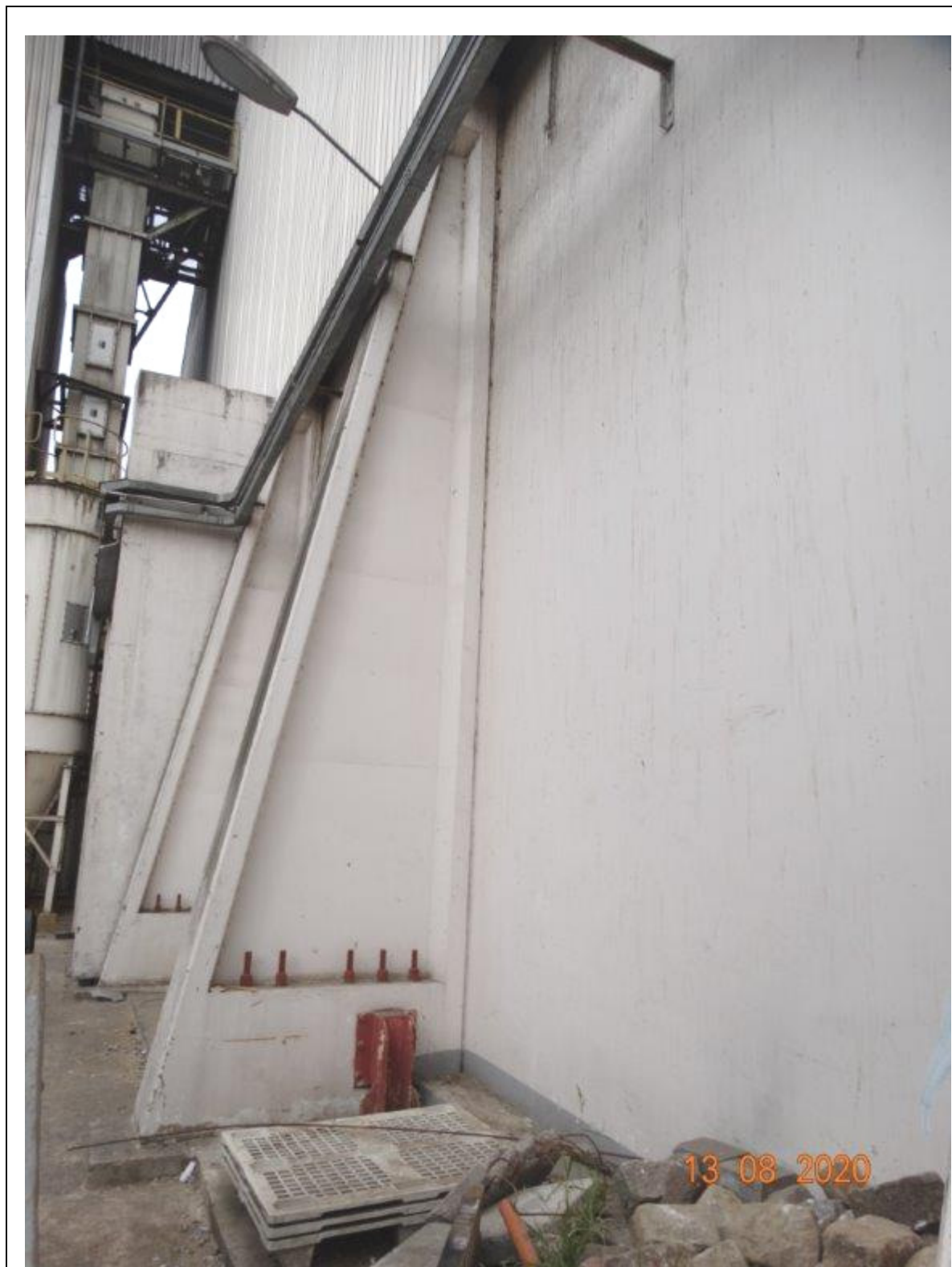
FOTO 45 – SILO 3 - PAREDE EM ESTRUTURA DE CONCRETO ARMADO COM CONTRAFORTES.
