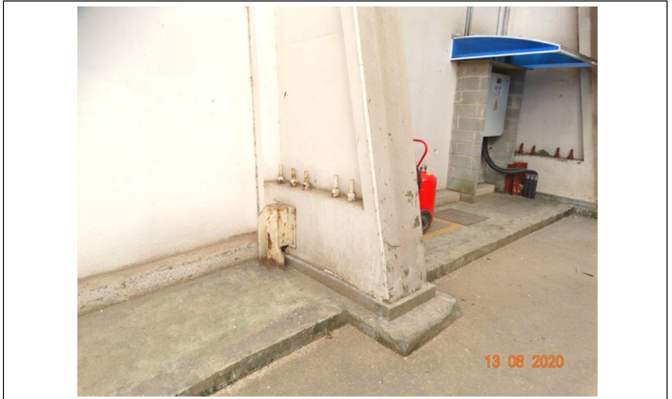
FOTO 16 – VISTA DA BASE DA ESTRUTURA DO SILO 1.
