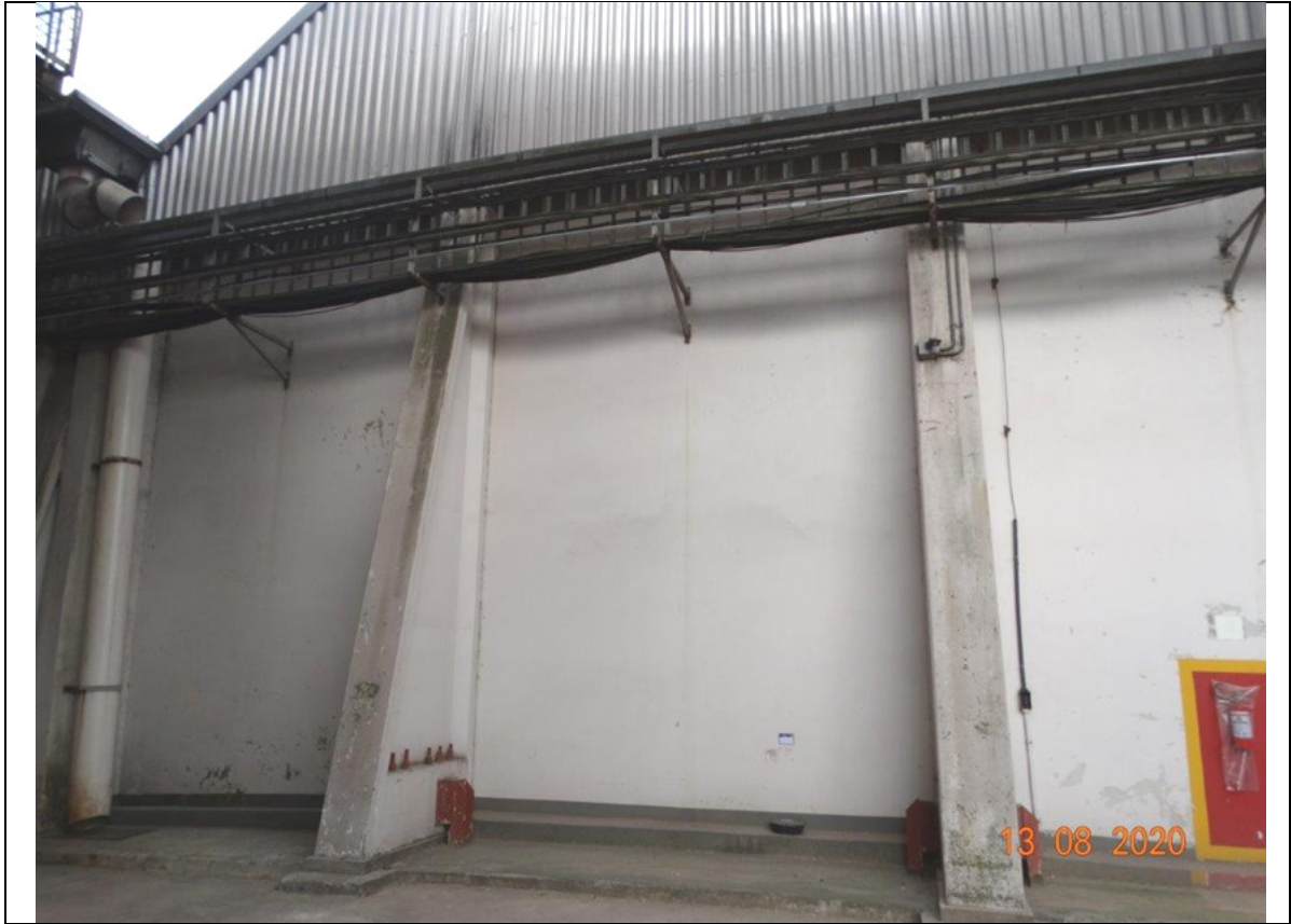
FOTO 26 – SILO 2 - PAREDE EM ESTRUTURA DE CONCRETO ARMADO COM CONTRAFORTES.
