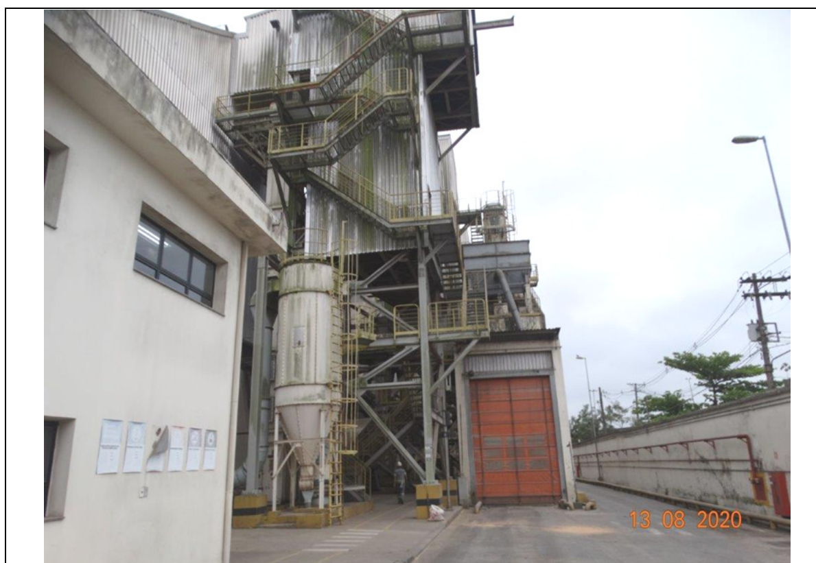
FOTO 05 – PARTE DO PRÉDIO DA ADM. E ESTRUTURA JUNTO AO SILO 1.
