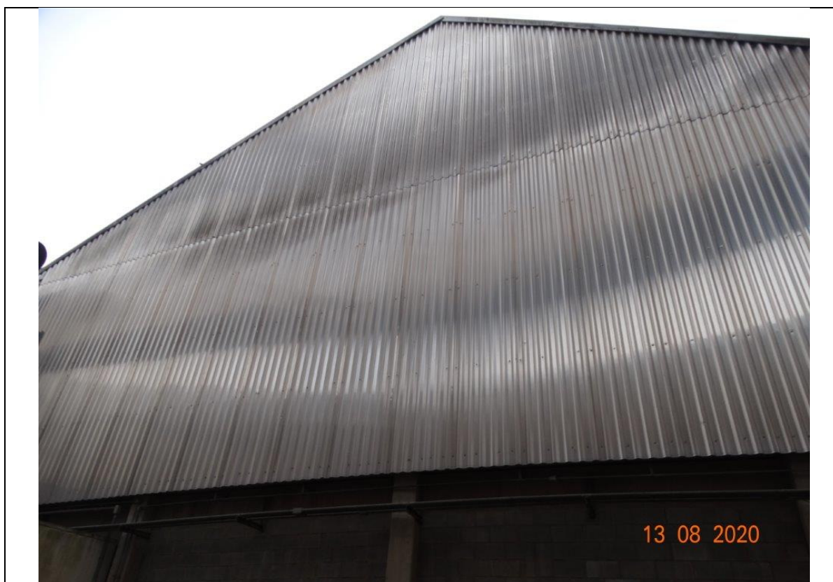
FOTO 32 - LATERAL DO SILO 2.
