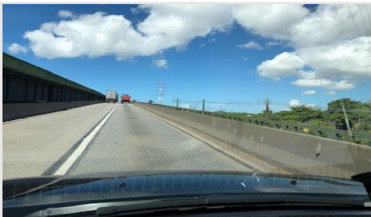
Foto 33: Rodovia Cônego Domênico Rangoni sentido Guarujá, ponte sobre braço de mar em Monte Cabrão a direita a linha de transmissão.
