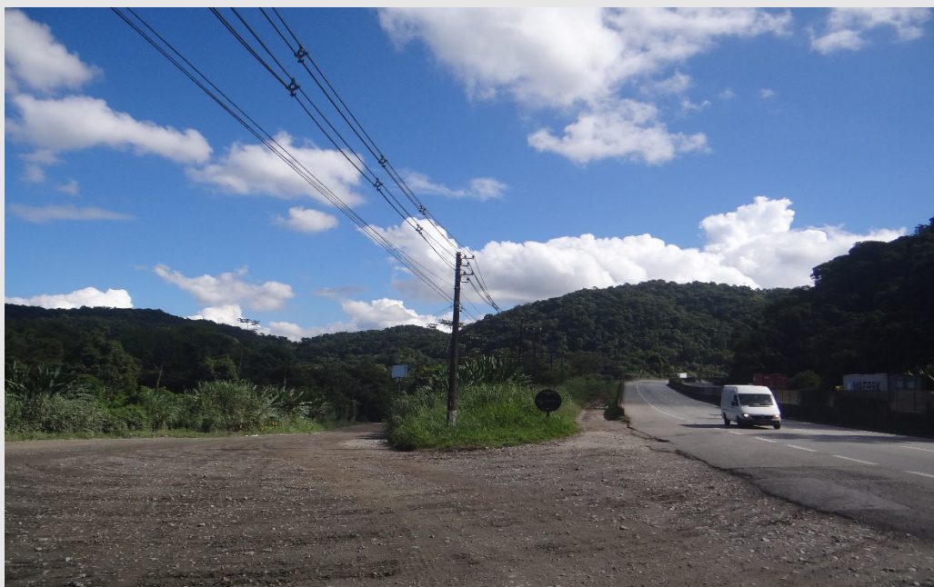
Foto 26: Acesso ao Aterro Sítio das Neves e futura URE sob linha de transmissão existente a direita da Rodovia Cônego Domênico Rangoni, sentido São Paulo-Guarujá.
