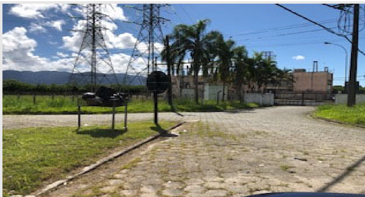
Foto 34: Entrada subestação Vicente de Carvalho, lado direito rodovia Cônego Domênico Rangoni, sentido Guarujá-São Paulo.
