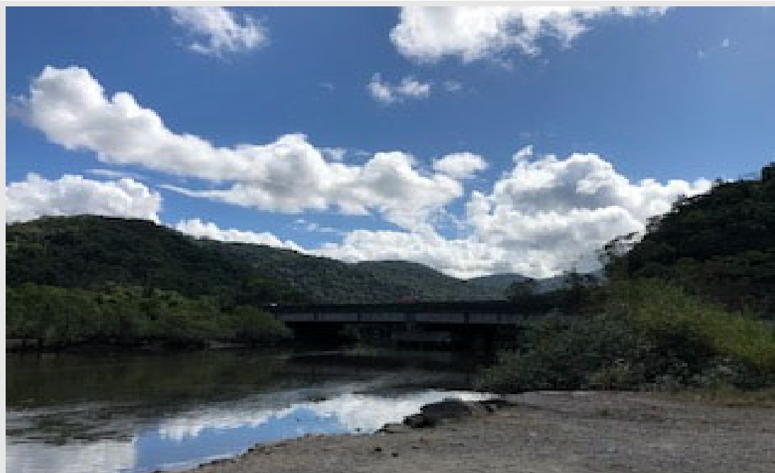
Foto 30: Ponte sobre o Rio Jurubatiba por onde passa a linha de transmissão.
