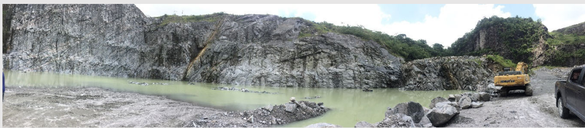
Foto 23: Vista geral da Pedreira Engebrita localizada na área de influência
