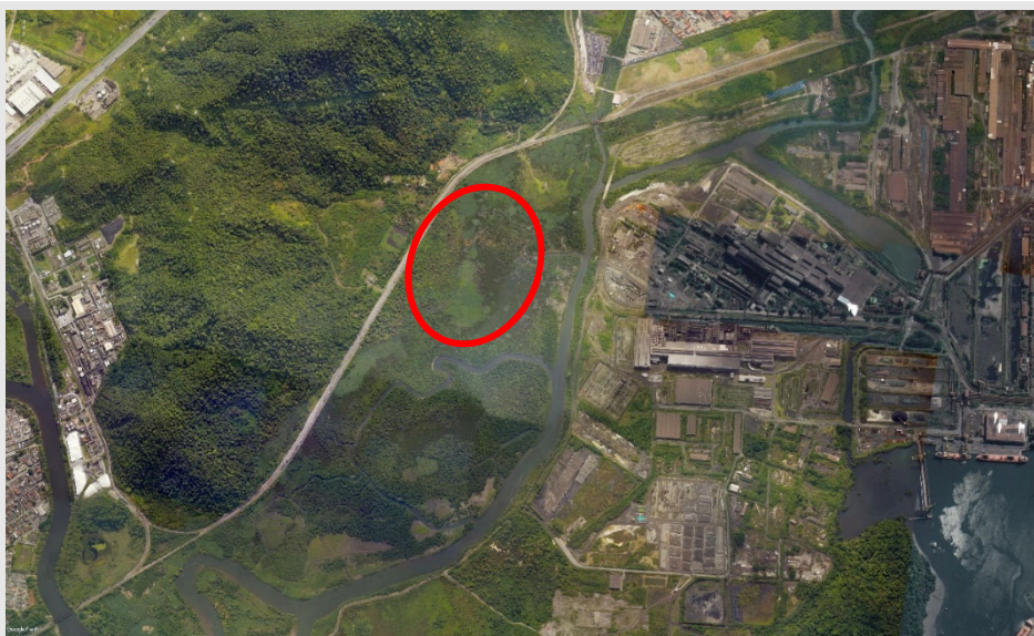
Foto 11: Localização aproximada da Área 01 para fins ilustrativos.
