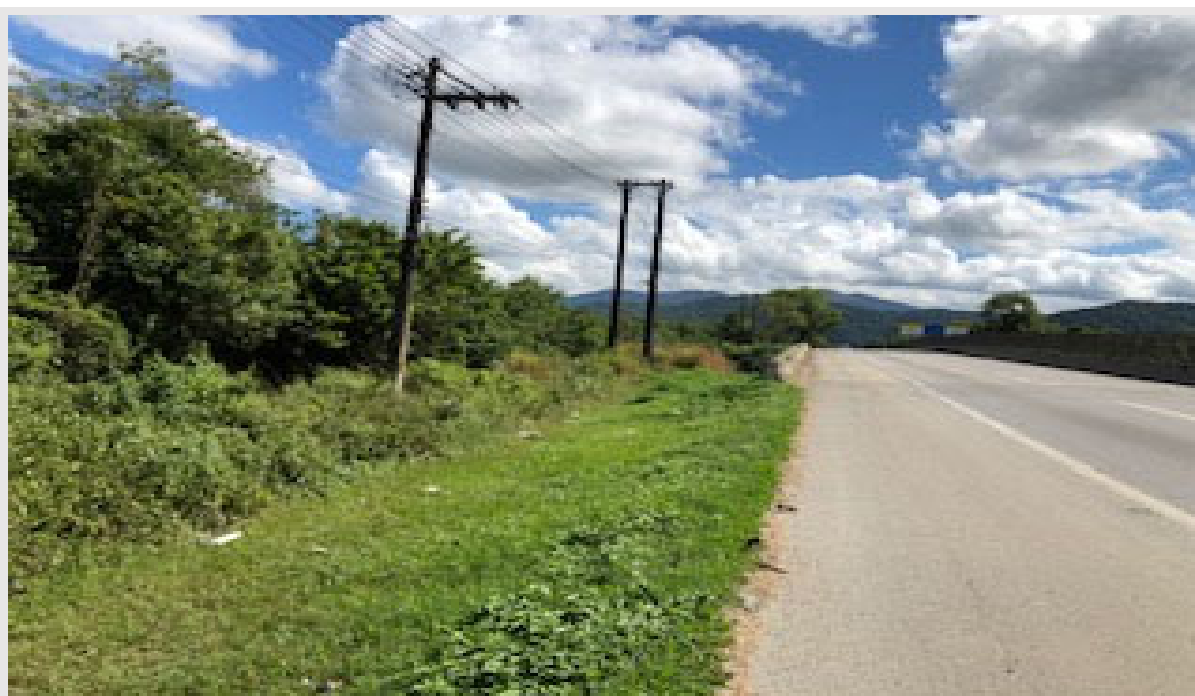
Foto 32: Rodovia Cônego Domênico Rangoni , linha de transmissão sobre Rio Diana.
