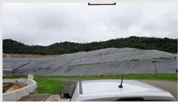
Foto 24: Células de disposição de resíduos do CGR Terrestre, ao fundo.
