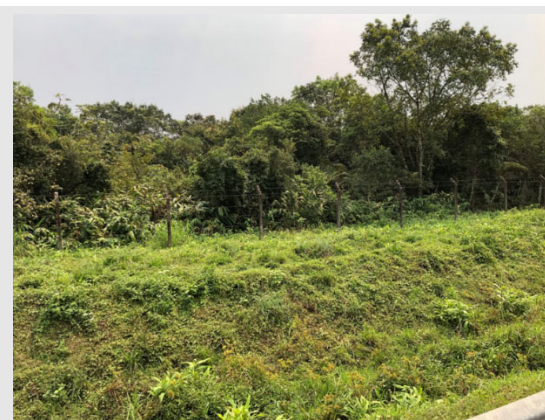
Foto 20: Vista parcial da Área 4.
