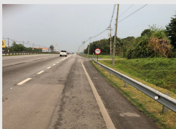
Foto 19: Vista parcial de acesso à Área 4.
