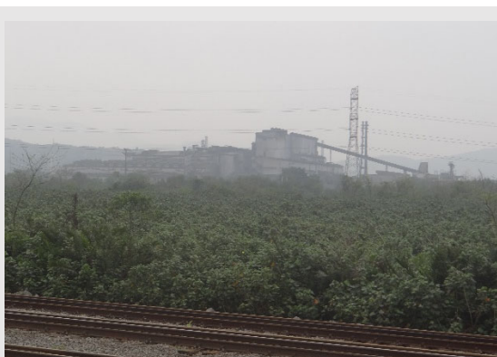
Foto 12: Vista parcial da Área 01.
