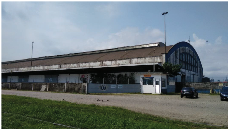
Figura 29 – Visão do armazém 32 a ser demolido.
