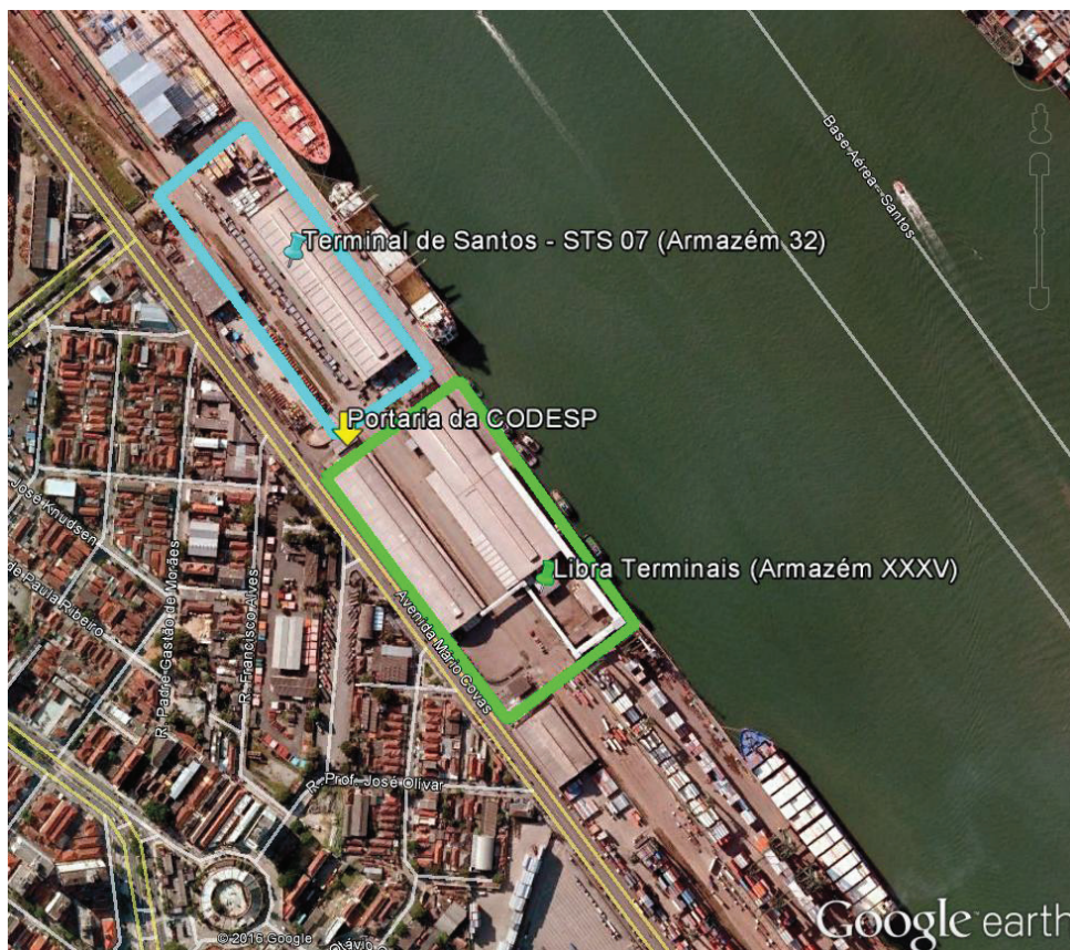
Figura 3 – Acessos de veículos e pedestres ao local da demolição Fonte: Adaptado Google Earth (2016).
