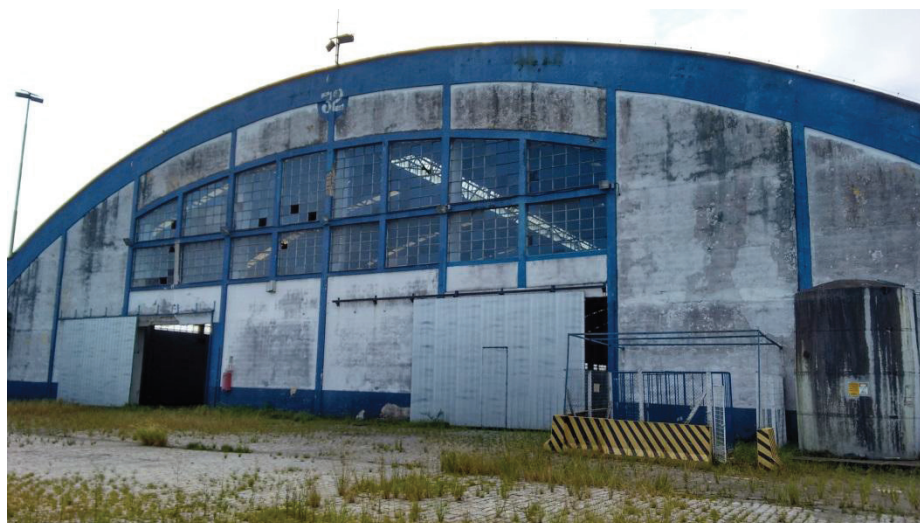
Figura 5 – Fachada do armazém 32. Fonte: Pöyry Tecnologia (2016).
