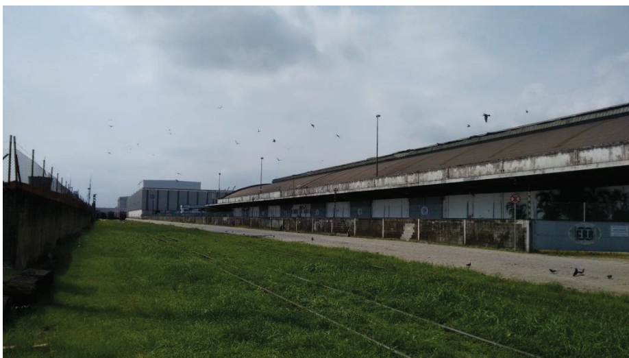
Figura 10 – Visão da linha férrea. Fonte: Pöyry Tecnologia (2016).
