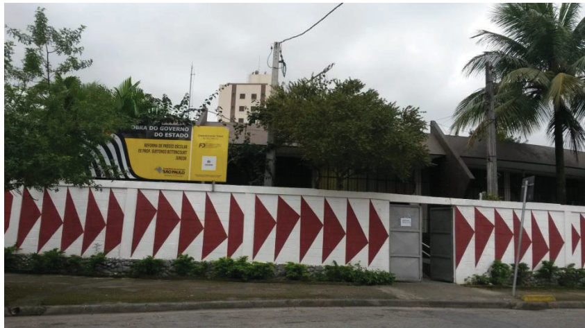
Figura 25 – Escola Estadual Suetonio Bittencourt Junior, localizada próxima à área de influência. Fonte: Pöyry Tecnologia (2016).
