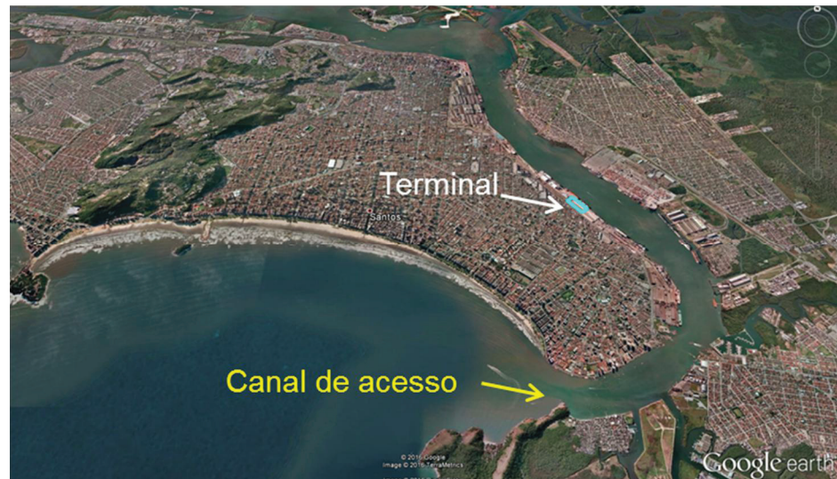
Figura 67 – Visão geral da localização do empreendimento no Porto de Santos.
