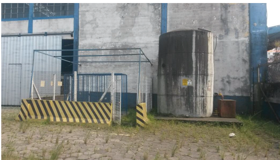
Figura 11 – Abrigo de GLP e caixa d'água. Fonte: Pöyry Tecnologia (2016).
