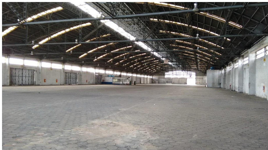
Figura 6 – Área interna do armazém 32. Fonte: Pöyry Tecnologia (2016).
