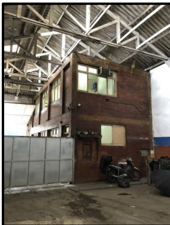
Prédio Administrativo – Vista interna
