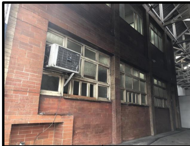
Prédio Administrativo no interior do empreendimento
