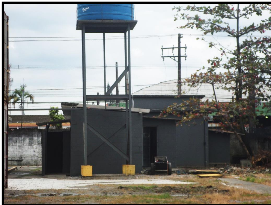
Foto 24 - Vestiários. Fonte: Engea, 2019
