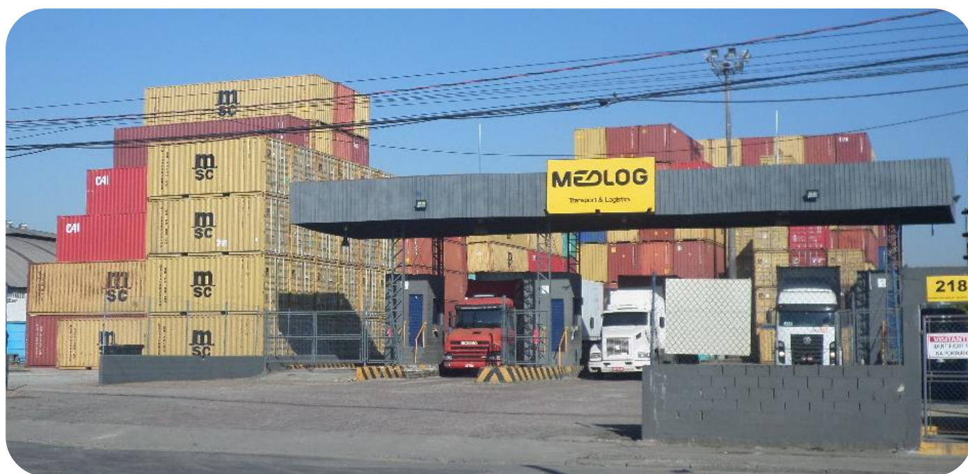
Foto 2 - Portaria de saída de veículos diversos e pessoas. Fonte: Engea, 2019.
