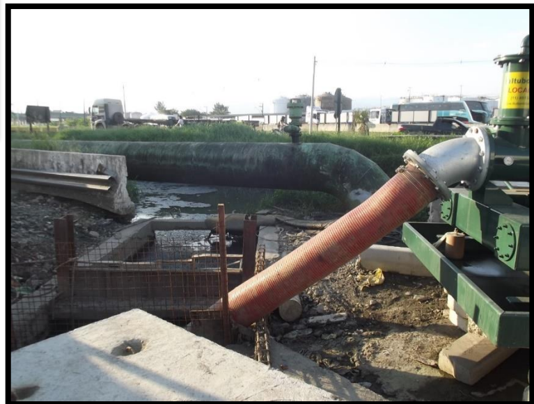
Foto 34 - Obras de Drenagem, Rio São Jorge. Fonte: Engea, 2019.
