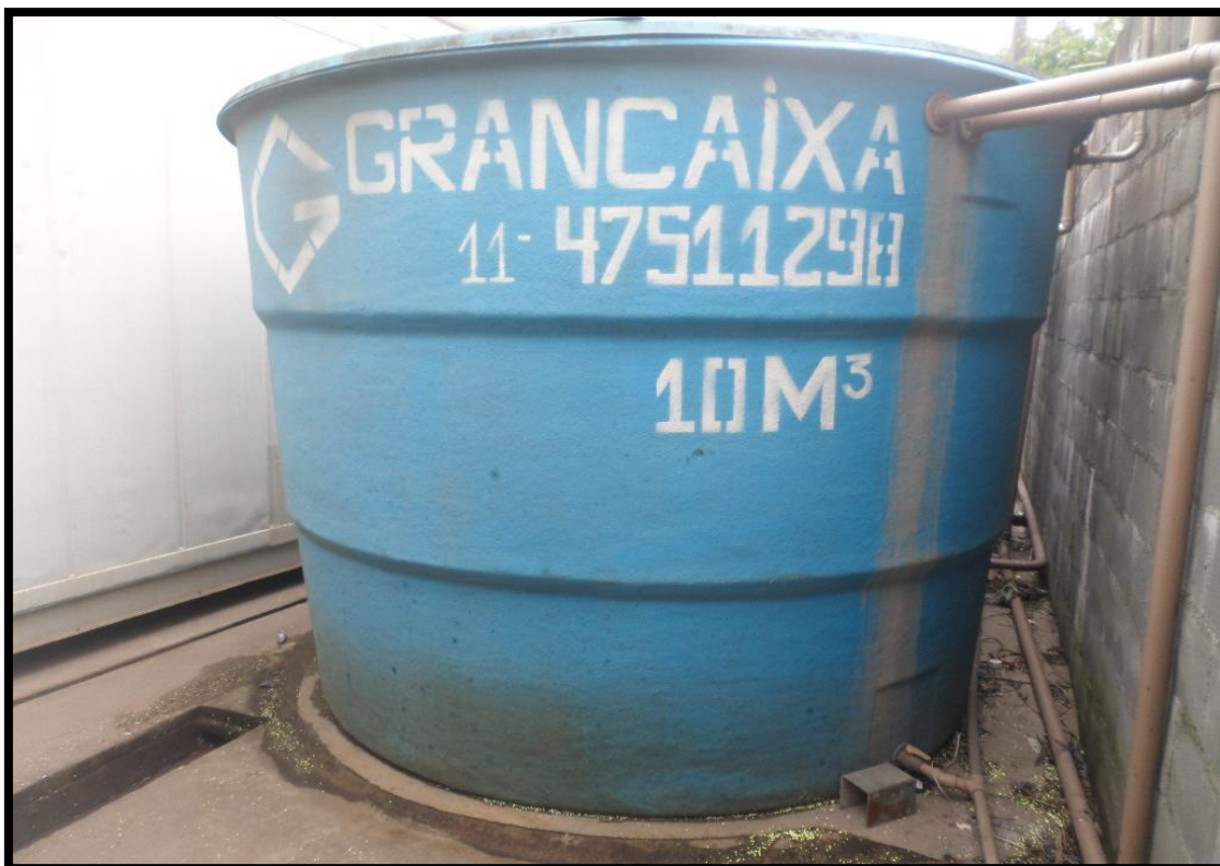
Foto 19 - Caixa para armazenar a água que vem do tratamento da CSAO.
