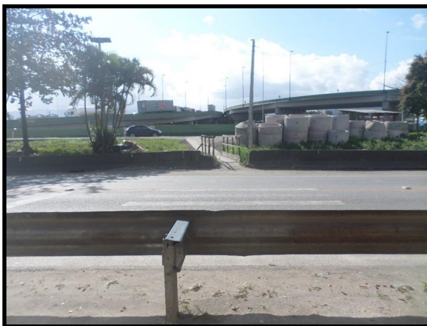
Foto 40 - Passagem de pedestres entre Vila Alemea e Via Anchieta. Fonte: Engea, 2019.
