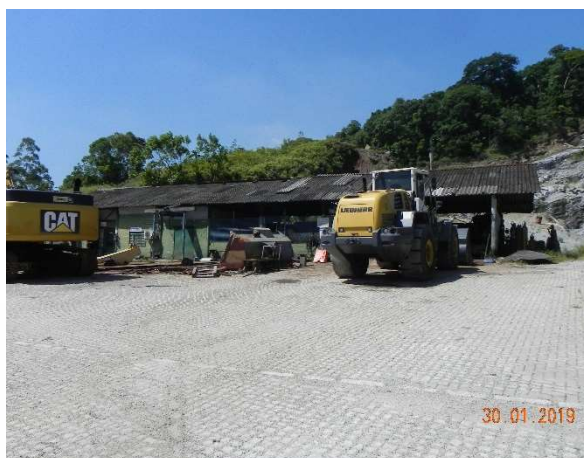
Foto 11: Oficina de manutenção.
