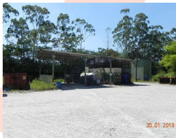
Foto 12: Tanque de abastecimento de veículos.
