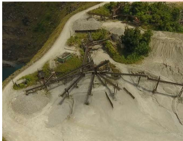
Foto 17: Vista superior dos equipamentos de beneficiamento, contendo os britadores, esteiras e estruturas.
