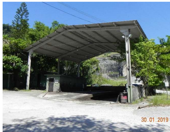
Foto 10: Área de manutenção de veículos.
