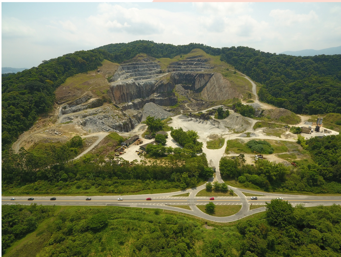
Foto 1: Aspecto geral da MAXBRITA, por foto aérea, no Município de Santos-SP.
