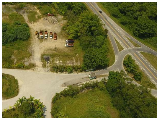
Foto 21: Guarita de acesso à MAXBRITA.
