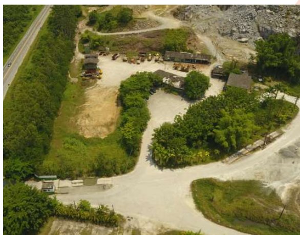
Foto 7: Aspecto da área onde estão localizadas as edificações do empreendimento, contendo os setores de administração e manutenção.
