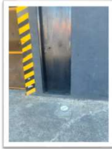
Foto 10– Ponto de ligação do esgoto –Arquivo Pessoal
