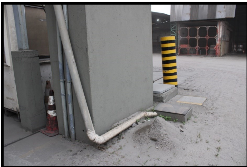
Imagem 38 - Sistema de direcionamento da água da chuva.
