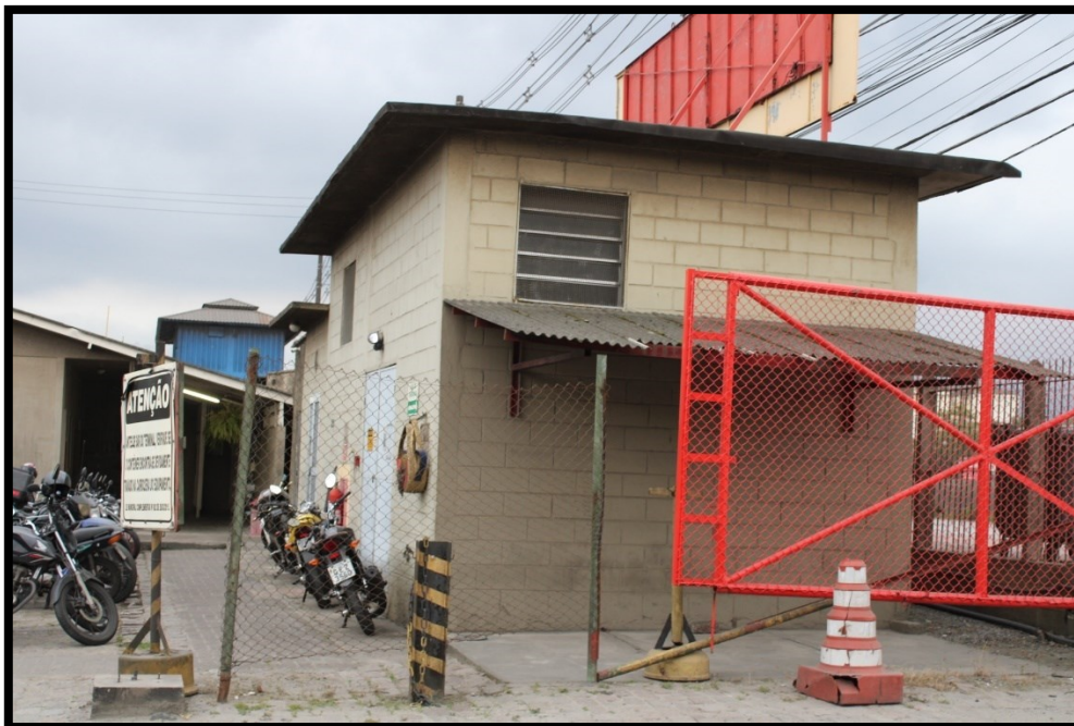
Imagem 15 - Casa de Máquinas - Cabine Primária. Área sinalizada, conforme AVCB em anexo.
