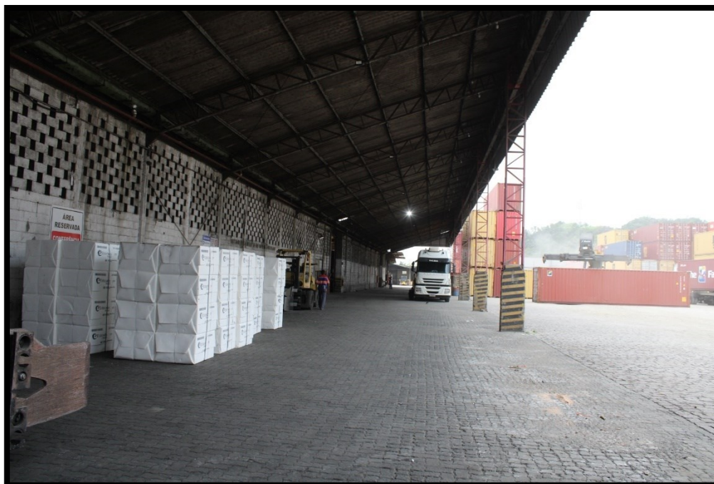
Imagem 19 – Armazém Geral - área externa. Possui piso de paralelepípedo e é coberta, conta com sistema de atendimento a emergências, com extintores e hidrantes.
