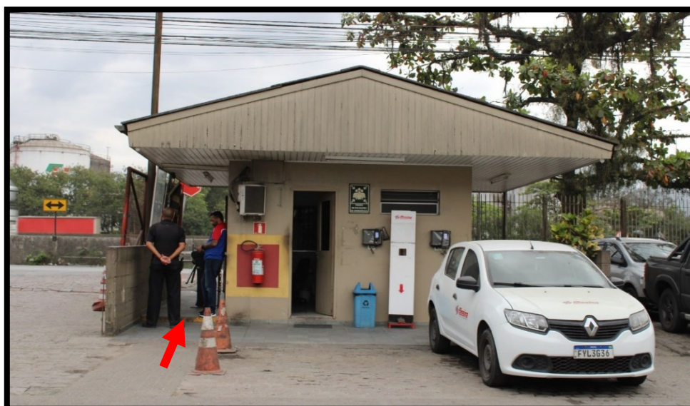
Imagem 3 – Portaria, realiza o controle de entrada e saída de veículos de pequeno porte. Detalhe para acesso de pedestres.
