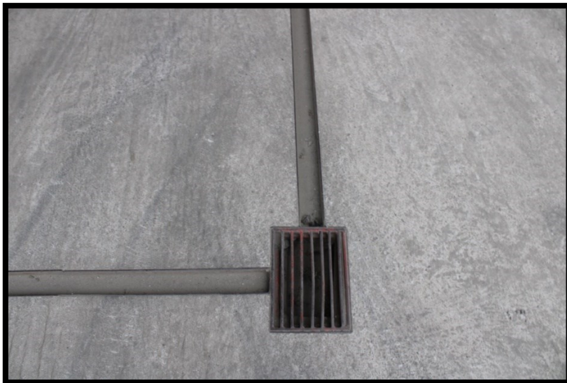
Imagem 37 - Calhas para retenção de líquidos.
