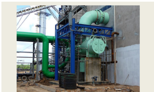
Foto 23: Exemplo de Condensador a Vácuo.
