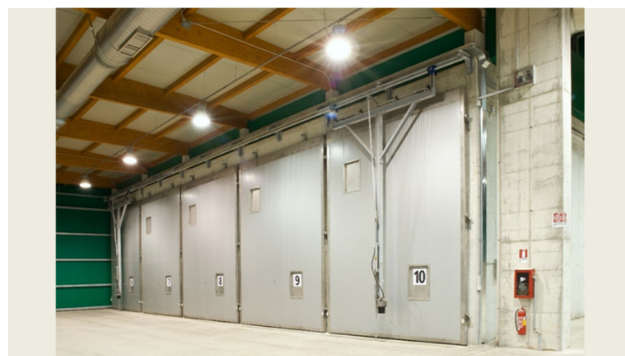
Foto 10: Pátio de Manobras e portas dos bioestabilizadores.
