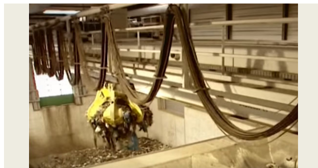
Foto 06: Exemplo de Ponte Rolante com Garra Hidráulica.
