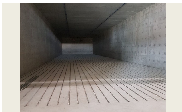
Foto 07: Detalhe do piso acabado do Bioestabilizador.
