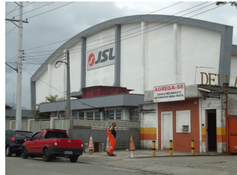
Figura 34 – JSL (lado oeste)
