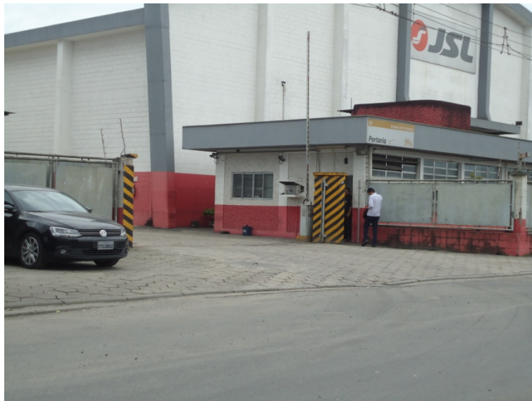
Figura 35 – JSL (lado oeste)
