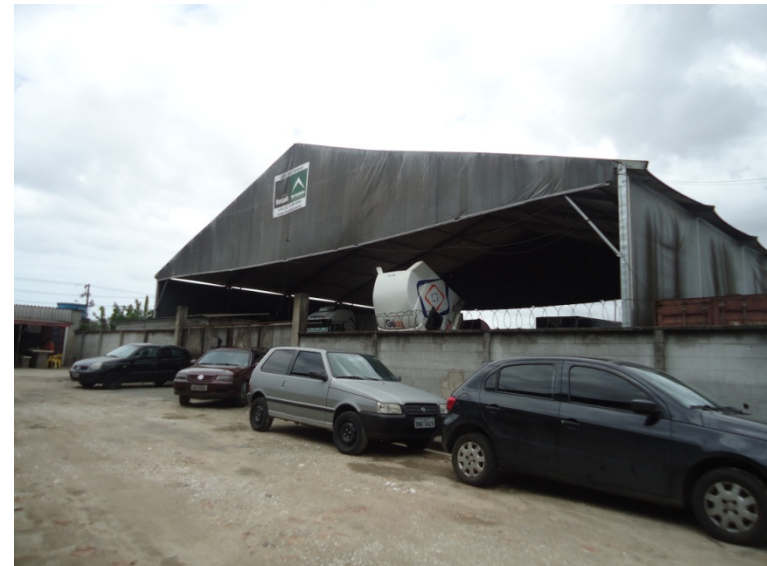
Figura 6 – Pátio de caminhões - Galpão
