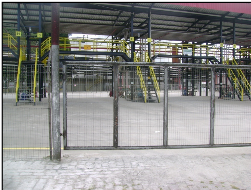
Figura 2.1 – Plataforma de carregamento rodoviário
