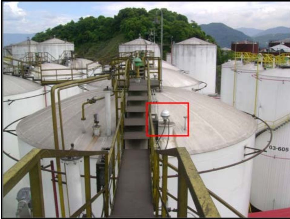
Figura 2.1 – Taque de armazenamento equipado com radar Fonte: ITSEMAP-INERCO.
