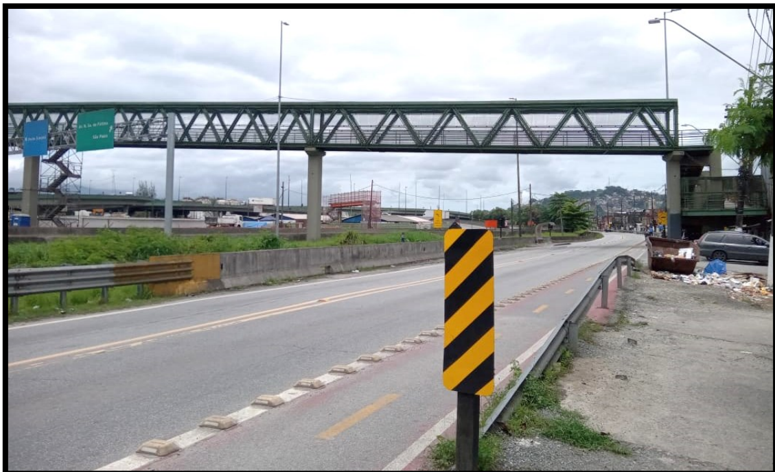
Imagem 15 - Passarela de pedestres.
