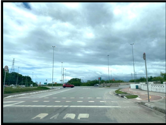
Imagem 4 – Acesso pelo Viaduto Paulo
