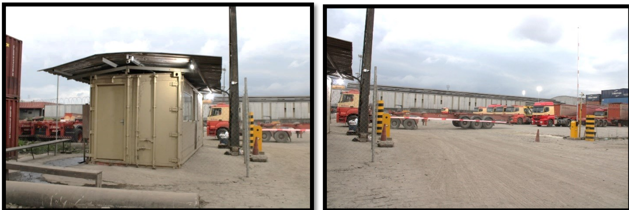
Imagem 11 - Cabine de passagem para acesso ao estacionamento rotativo.
