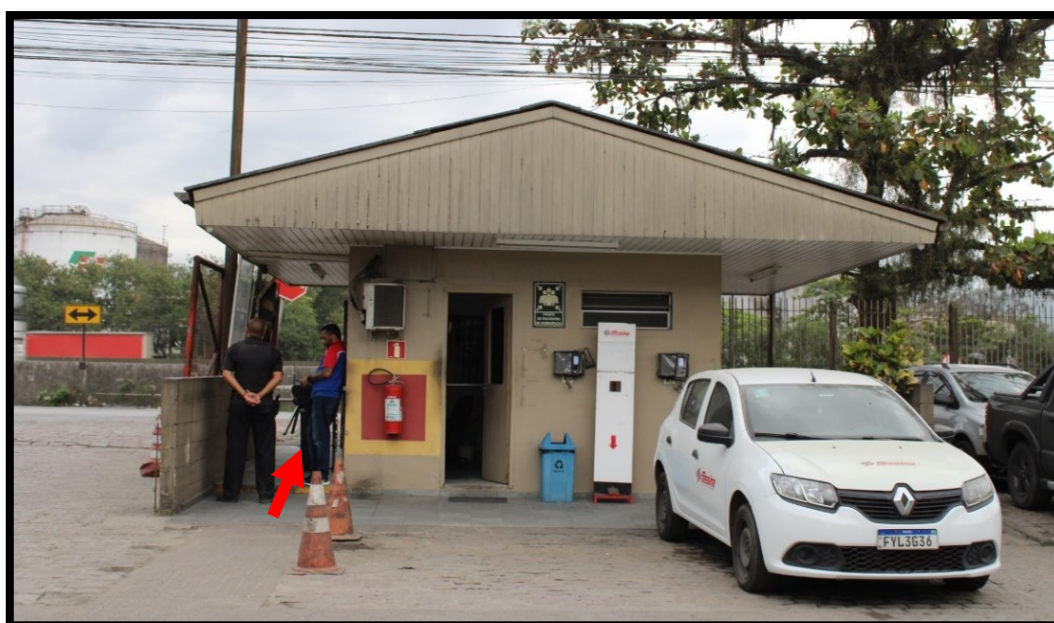
Imagem 7 – Portaria, realiza o controle de entrada e saída de veículos de pequeno porte.
