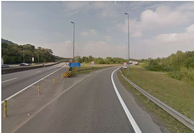
Foto 4: Dispositivo de acesso à BR-101 | SP-055 no km 248 Leste da Rodovia SP-248.
