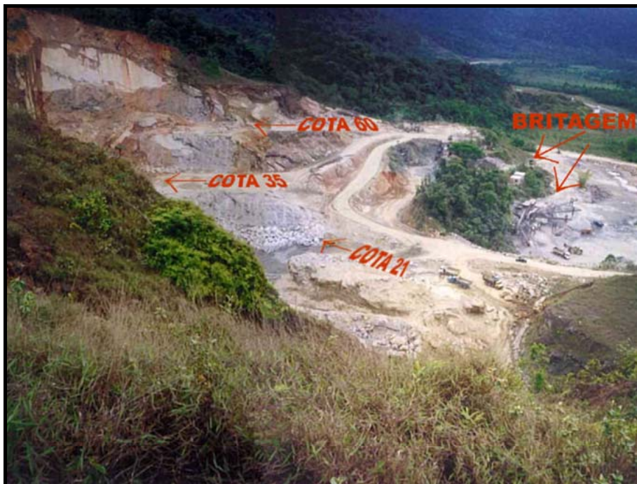
FOTO 3.1.1 - Vista geral do setor sudoeste-sul-sudeste, área de britagem, ao centro rebaixo em desenvolvimento, ao fundo setor NE-E, banco cota 60/65 e cota 30/35.
