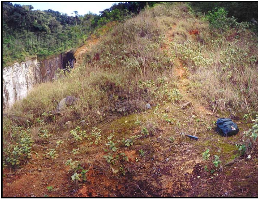
FOTO 3.2.3 - Vista porção superior, setor nordeste crista de talude já decapeado em solo, antiga rampa de acesso ao nível superior acima da cota 100, fundo norte/nordeste da cava.
