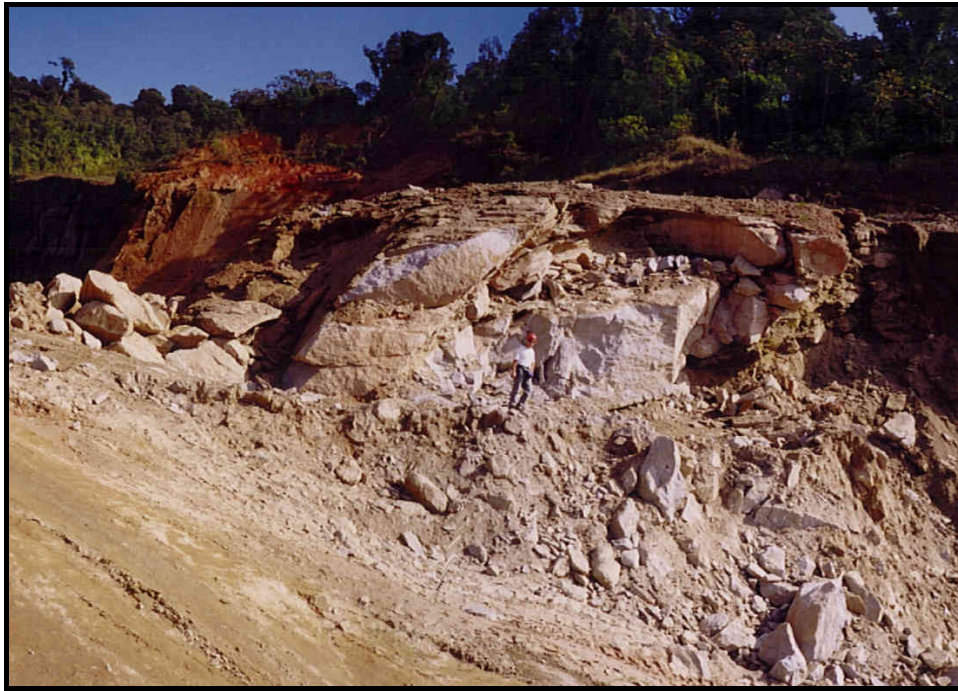
FOTO 2.1.3.2 - Tomada de frente de lavra-banco cota 60/65 setor NE-E faixa com rocha parcialmente alterada.
