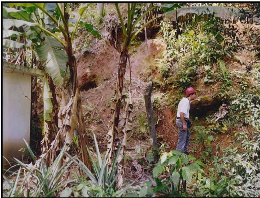
FOTO 2.1.3.1 - Vista de corte junto aos paióis em lado oposto a elevação do setor NE-E, próximo à nascente d'água observa-se depósito de talus com blocos rolados segundo meia-encosta.
