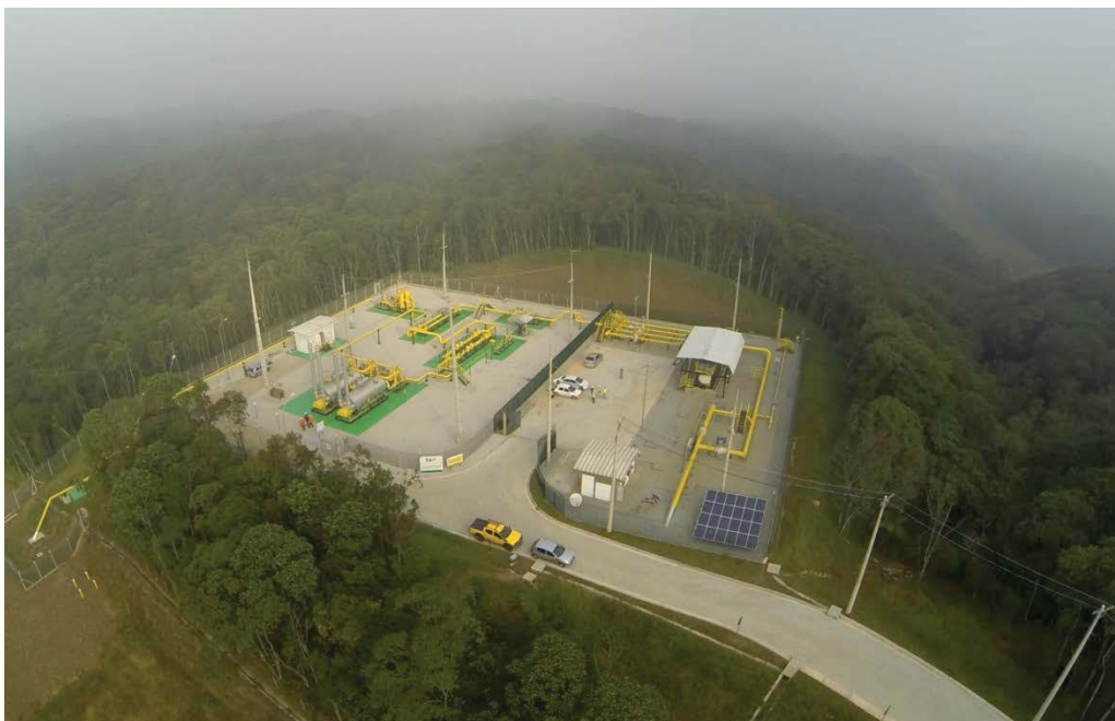
Figura 2.15 – Instalação Típica de City Gate da Comgás (presenta no alto da serra)
