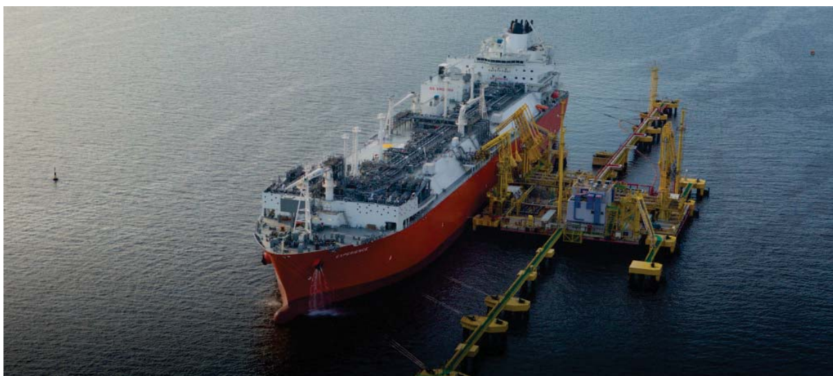
Figura 2.6 – FSRU em Operação, Atracada em Terminal de GNL com Píer Tipo Ilha.
