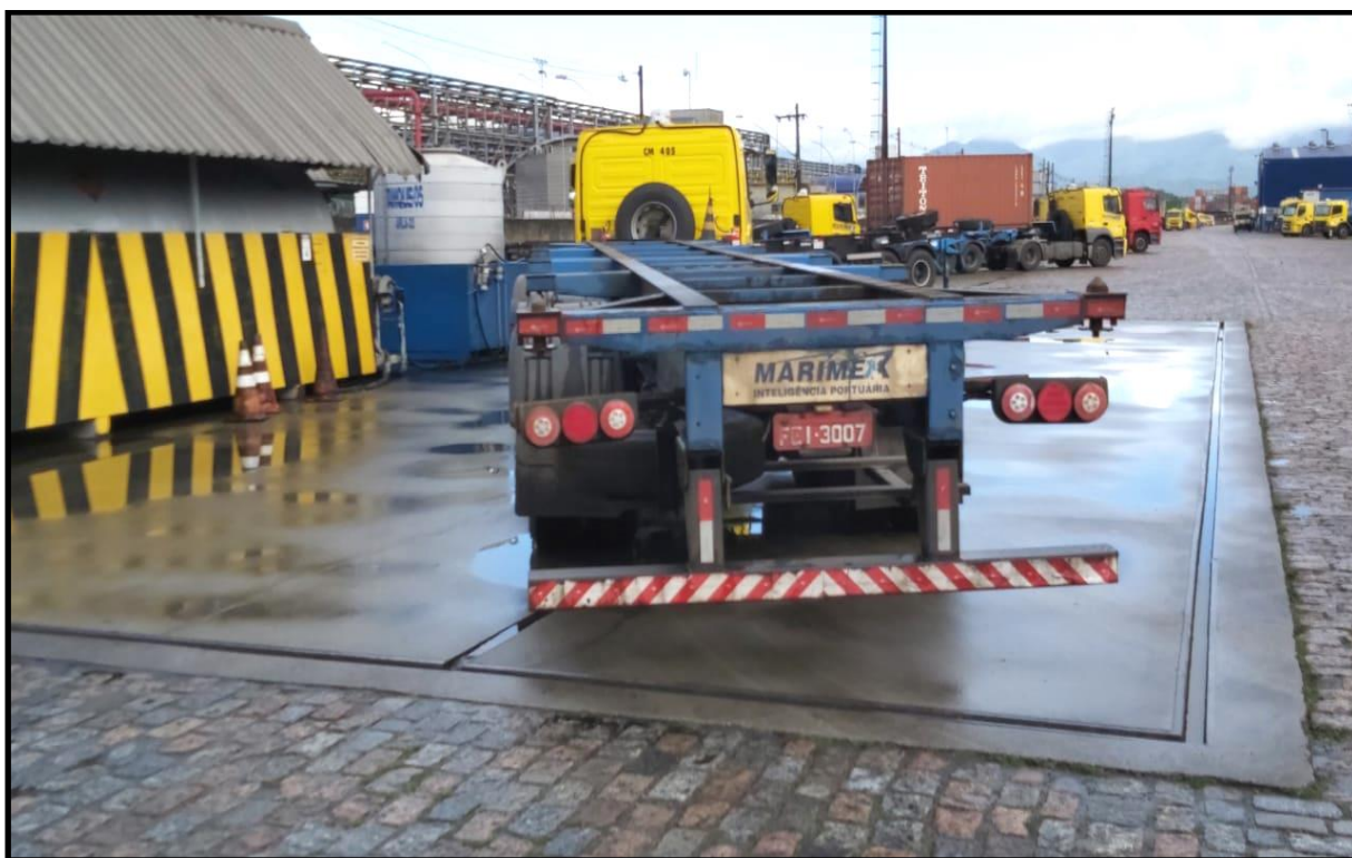
Figura 5 – Área de abastecimento de caminhões e máquinas, com canaletas no seu perímetro.
