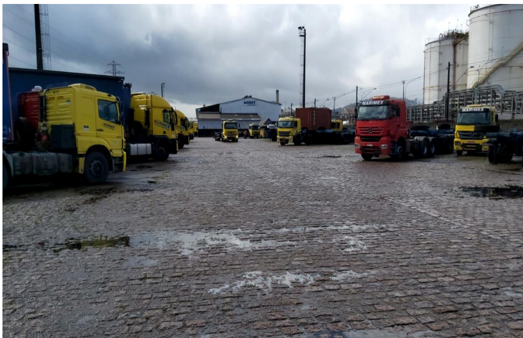
Figura 28 – Pátio de estacionamento de veículos com o prédio da oficina eletromecânica e almoxarifado ao fundo.
