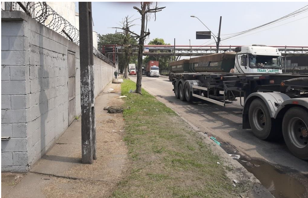
Figura 31 – Término da R. Dr. Albert Schweitzer na R. Augusto Scaraboto, com detritos a retirar e poste na área de circulação de pedestres.
