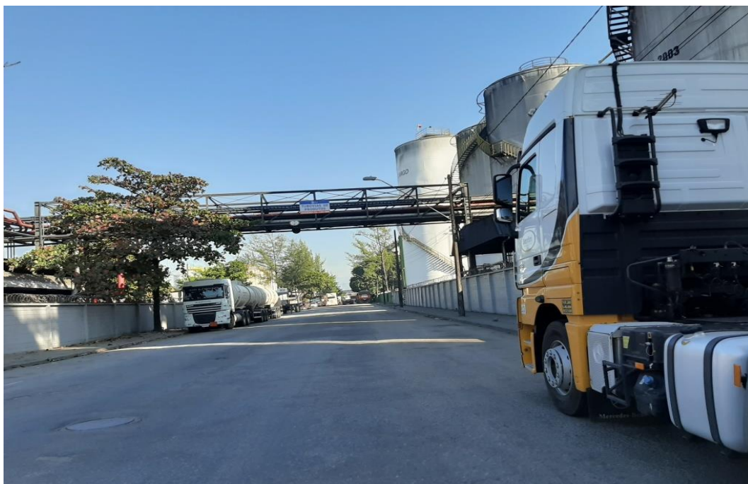
Figura 8 – Dutovia em rua da região causando limitação de altura das cargas transportadas.
