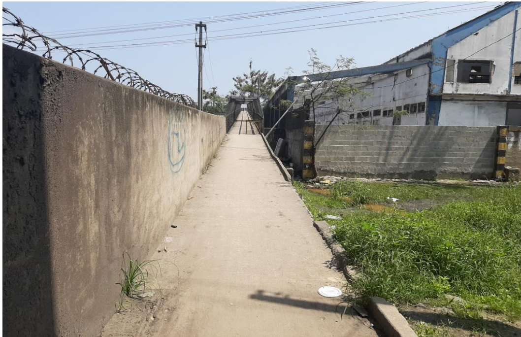
Figura 53 - Vista da passarela de pedestres junto ao terminal Usisal (atual UltraCargo).
