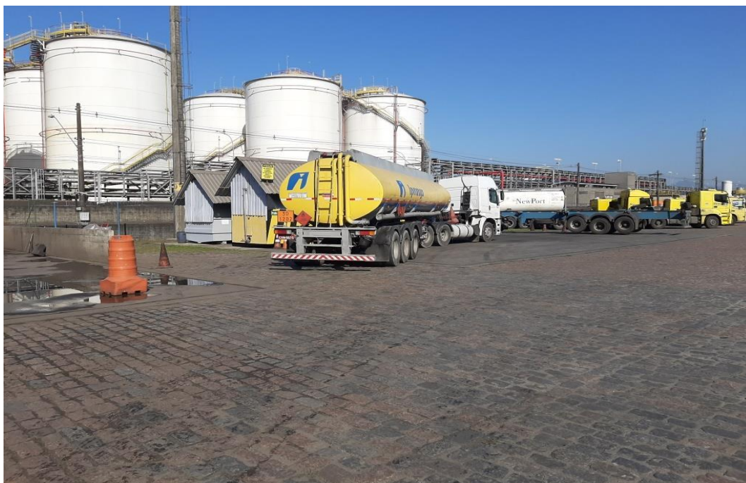
Figura 19 – Vista parcial da estação de abastecimento da frota.
