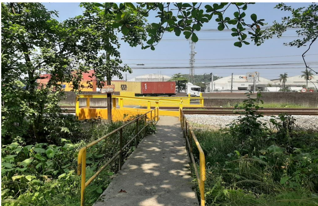
Figura 58 – Presença de mato no canal de drenagem defronte à R. Eustáquio Alves de Souza.
