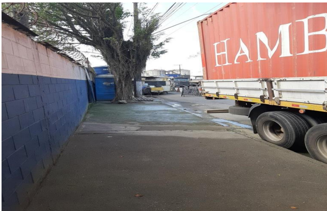
Figura 67 – Calçada com descarga irregular de água e película escorregadia com efetivo risco de quedas de transeuntes.
