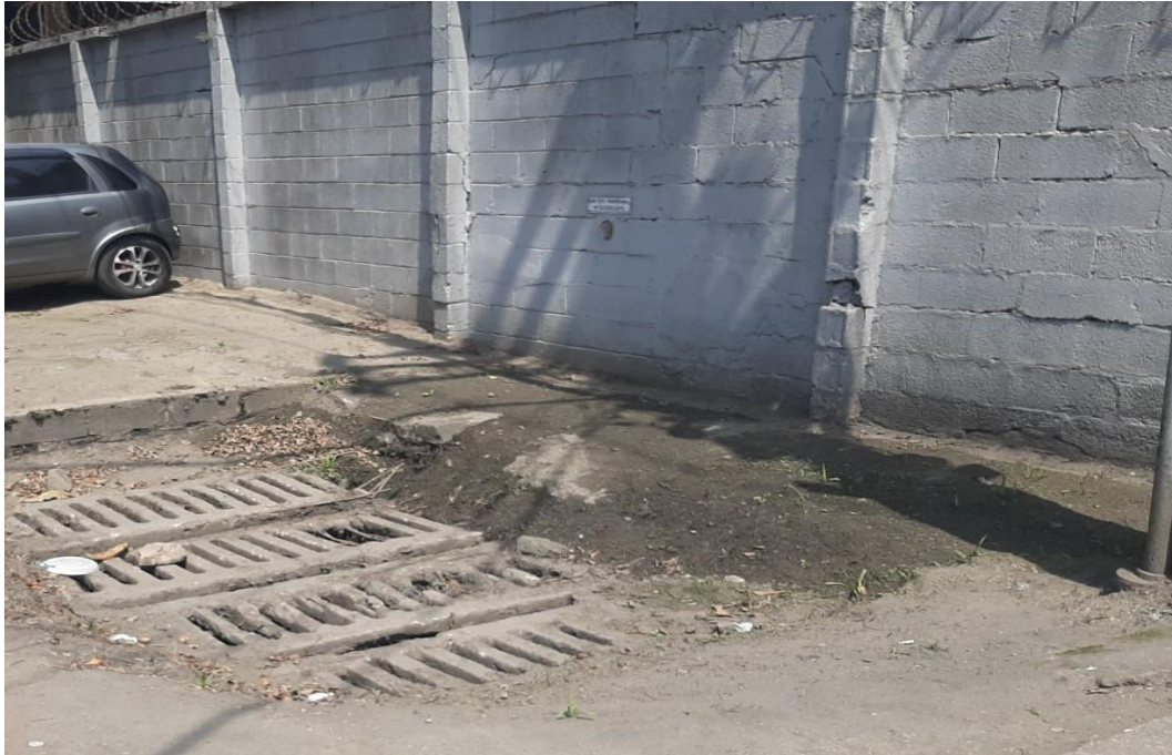
Figura 34 - Vista parcial de grelhas de drenagem em depressão na calçada da R. Augusto Scaraboto.
