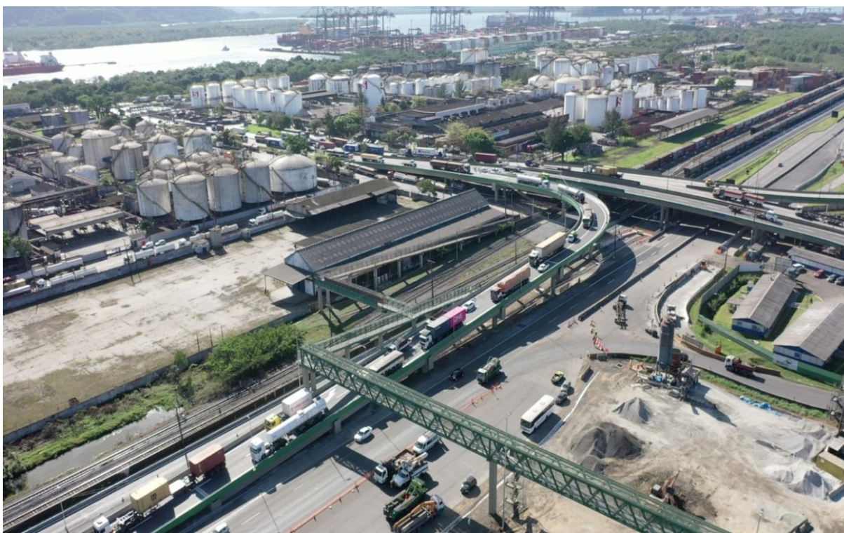
Figura 4 – Viaduto Dr. Paulo Bonavides de acesso e saída à Alemoa e ao viário do Porto ( https://estradas.com.br/segundo-viaduto-no-complexo-alemoa-em-santos-sp-e-liberado-ao-trafego/ ).
