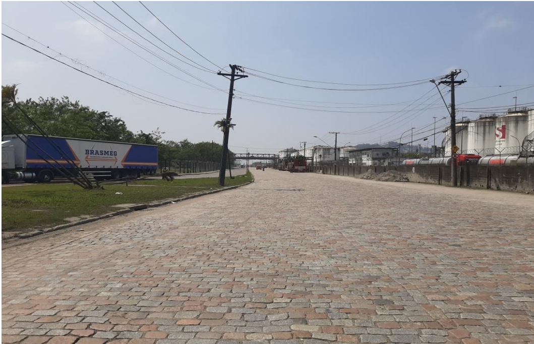
Figura 49 - Vista da Av. Engenheiro Augusto Barata na rotatória de interligação da Alemoa.
