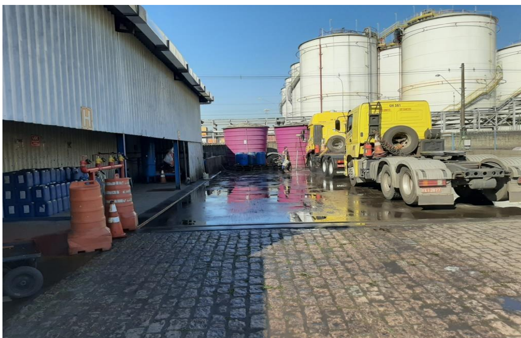
Figura 21 – Área de lavagem da frota cercada por canaletas de coleta.
