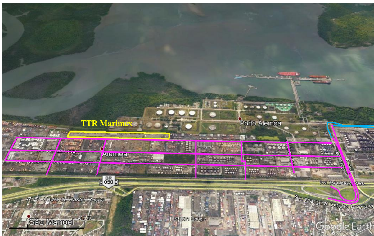
Figura 15 – Arruamento da AID e entorno com o TTR Marimex (perímetro em amarelo), o viário do Distrito Industrial da Alemoa (em rosa) e o viário portuário (em azul).
