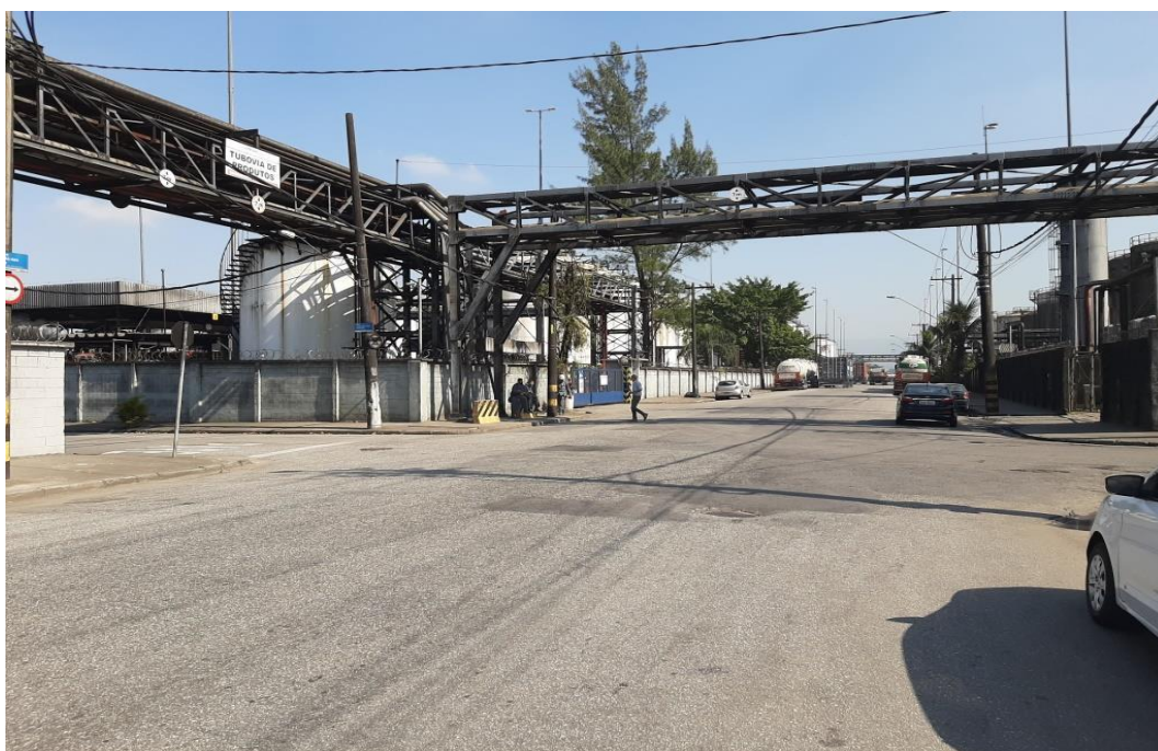
Figura 9 – Outra dutovia em esquina da região limitando acesso a cargas com maiores alturas.
