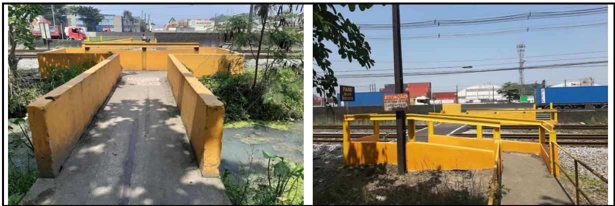
Figura 60 – Vista de pontos de travessia sobre as linhas férreas.
