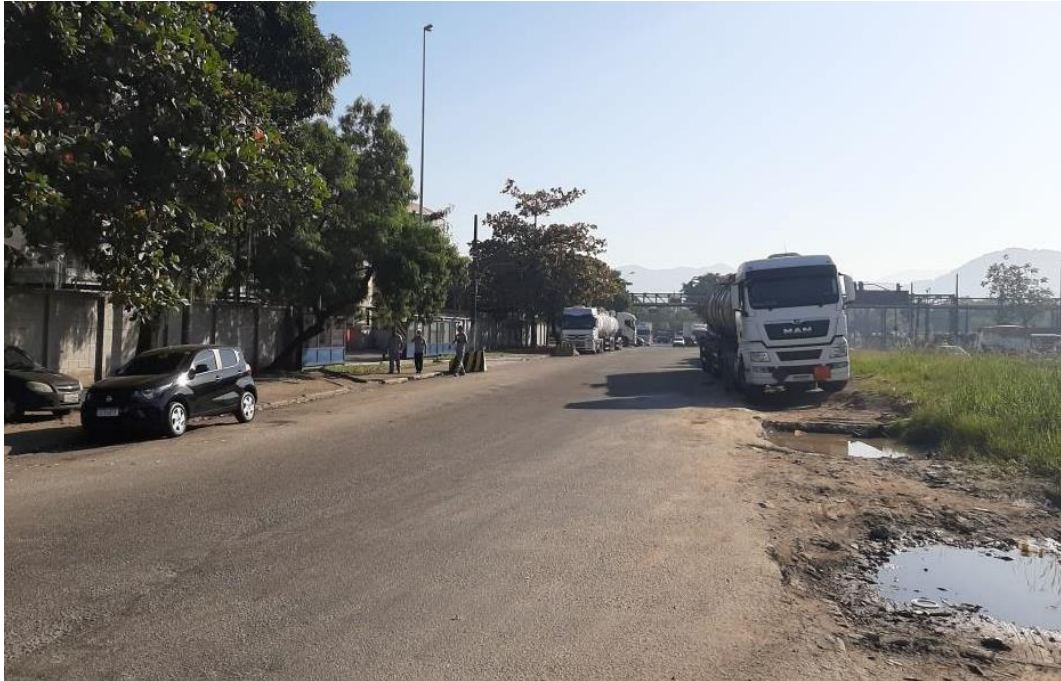
Figura 30 – Trecho da R. Augusto Scaraboto, exibindo deficiências junto ao canteiro central.
