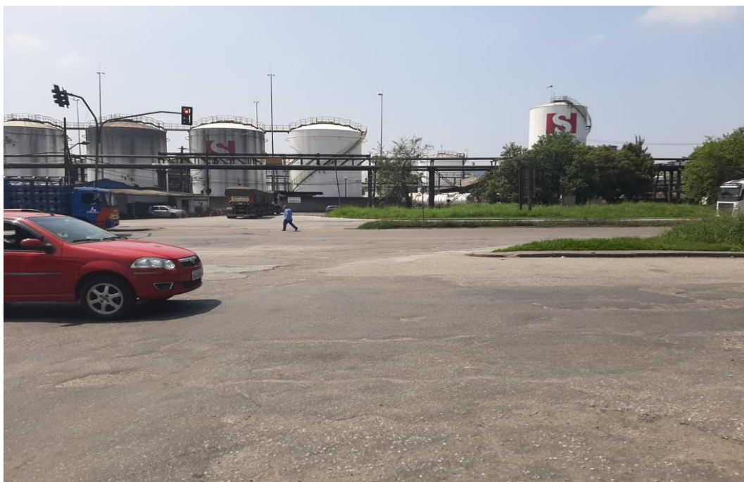
Figura 32 – Cruzamento com semáforo na saída da R. Dr. Albert Schweitzer, onde há desnível com risco aos veículos de carga que derivam à direita para acessar ao viaduto.
