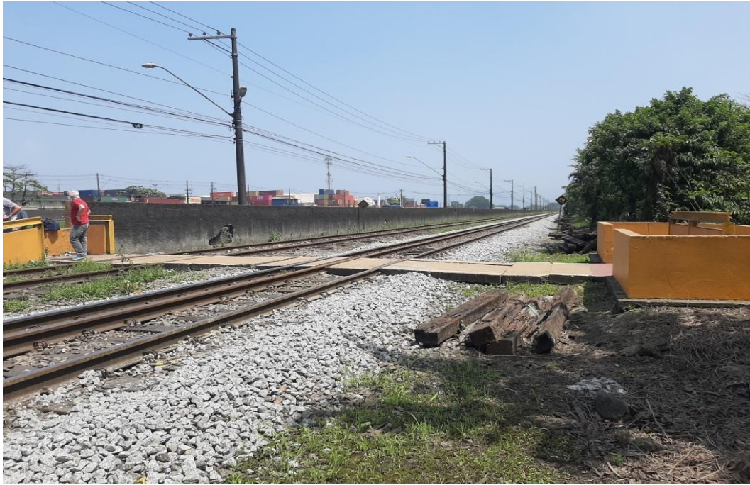
Figura 57 – Vista lateral de passagem em nível para a Av. Bandeirantes.
