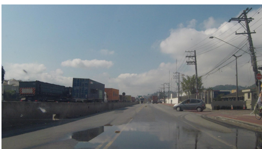
Foto 2.5. | Avenida Marginal direita, após o dispositivo da foto anterior. Neste trecho, onde encontra-se o acesso ao terminal CLIA, a avenida desenvolve-se em pista simples, com uma faixa de rolamento por sentido. O trecho ainda possui uma faixa à direita destinada a estacionamento e faixa cicloviária junto ao passeio.
