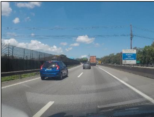
Foto 2.1: SP-150 - Via Anchieta, sentido Santos. A via desenvolve-se em pista dupla, com duas vias de tráfego por sentido. A velocidade máxima regulamentada para o trecho onde está localizada a saída para a região das docas é de 60 km/h.
