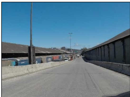
Foto 2.9: Trecho final do viaduto de acesso. Ao fundo nota-se o início da pista sul da Avenida Eduardo Pereira Guinle.
