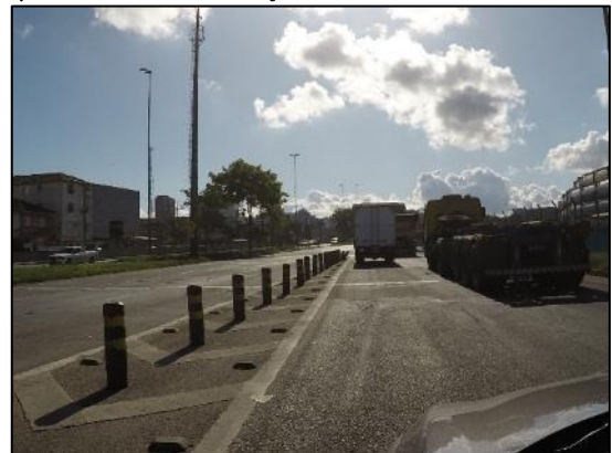
Foto 2.16: Fim do viaduto de saída da área do terminal. Neste ponto, o tráfego com origem nos terminais alinha-se com o tráfego da pista norte da Avenida Cidade de Santos.
