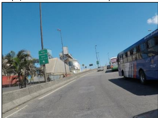
Foto 2.7: Trecho inicial do viaduto de acesso à área STS11. O viaduto tem sentido único de direção e, ainda que sem sinalização horizontal, possui largura para três faixas de rolamento.
