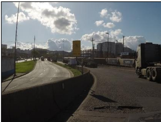
Foto 2.15: Trecho final do viaduto de saída da área do terminal. À esquerda da imagem nota-se a pista norte da Avenida Cidade de Santos.
