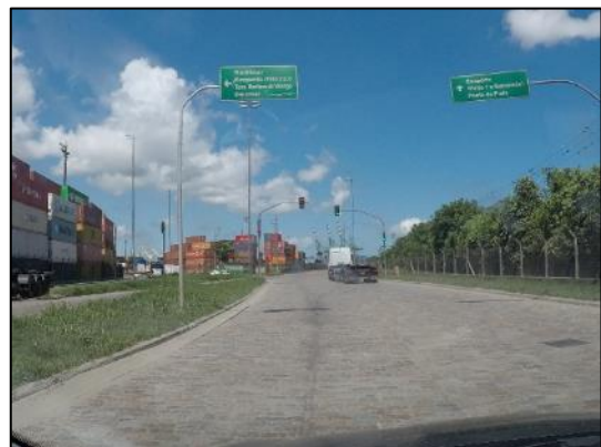
Foto 2.4: Avenida Engenheiro Augusto Barata. A via possui, em alguns trechos, pavimentação em paralelepípedo. Ao longo de todo o seu trajeto se verifica, más condições de conservação do pavimento e das sinalizações.
