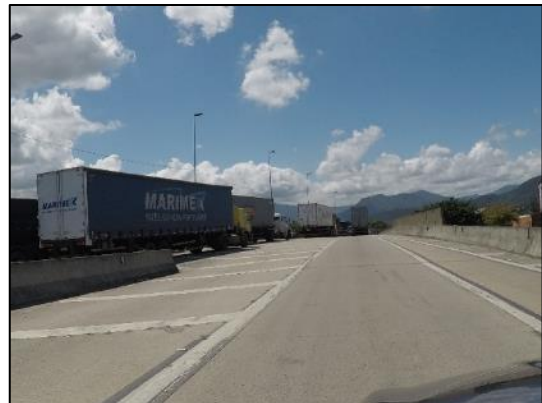
Foto 2.2: Viaduto Dr. Paulo Bonavides. A partir deste viaduto realiza-se o acesso à Avenida Engenheiro Augusto Barata.
