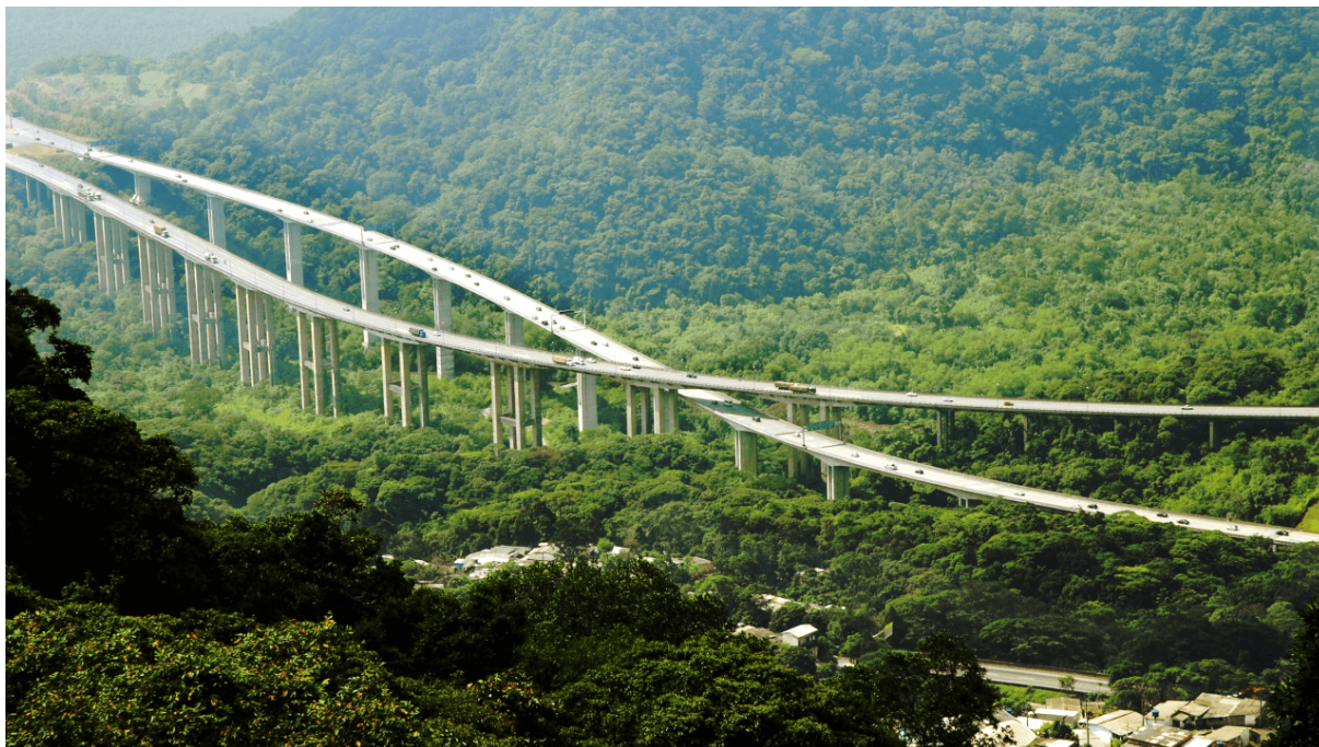
Figura 9.3.4.1-1: Rodovia dos Imigrantes - Trecho de Serra. Fonte: Ecovias, 2018.
