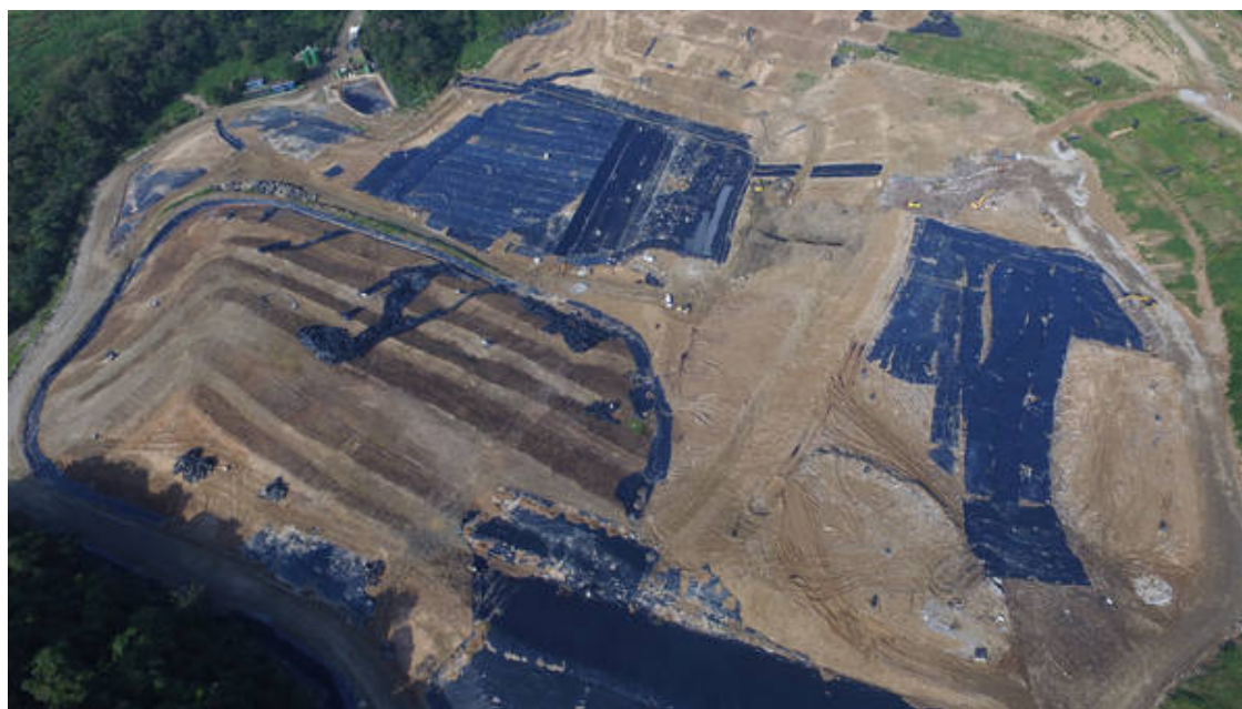
Figura 9.3.6.3-1: Aterro Sanitário do Sítio das Neves, na Área Continental de Santos. Fonte: www.diariodolitoral.com.br
