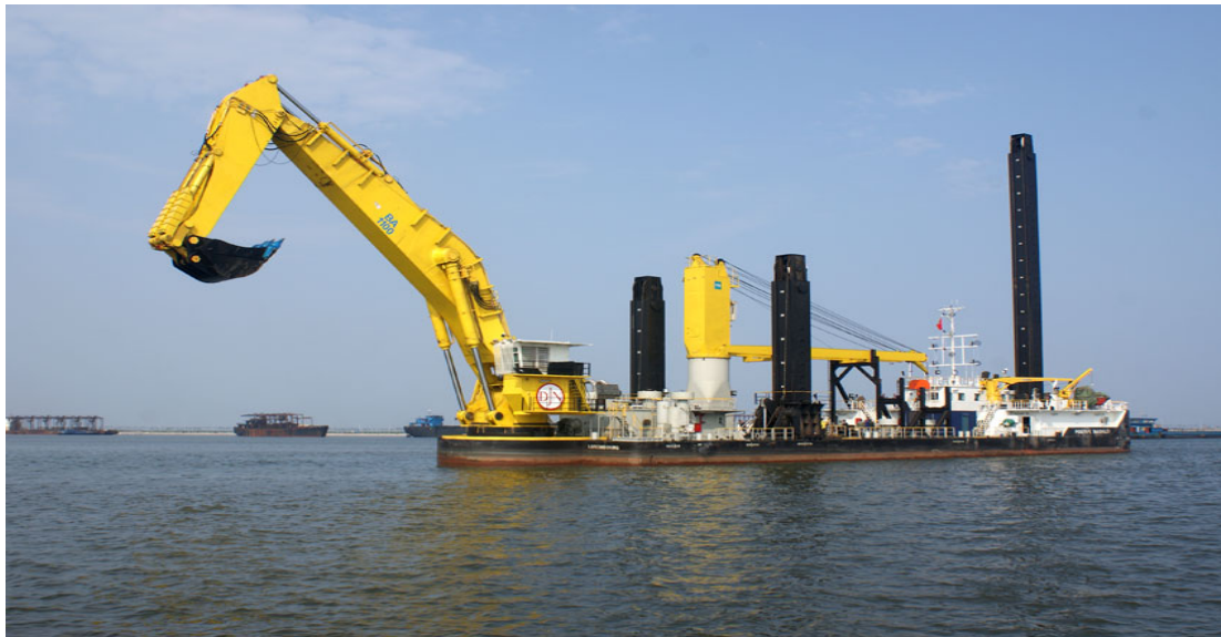
Figura 9.1.11.2.3-1: Draga do tipo escavadeira ( backhoe ) sobre balsa. Fonte: Jan de Nul.
