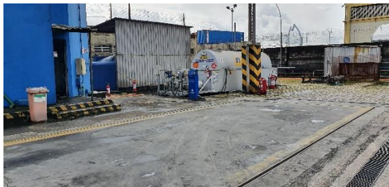
Figura 13: Vista geral do posto de abastecimento (Diesel)
