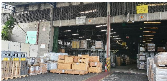
Figura 7: Vista geral do armazém de cargas gerais
