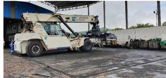
Figura 12: Detalhe do piso e canaletas da oficina
