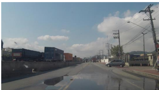
Foto 2.5. | Avenida Marginal direita, após o dispositivo da foto anterior. Neste trecho, onde encontra-se o acesso ao terminal CLIA, a avenida desenvolve-se em pista simples, com uma faixa de rolamento por sentido. O trecho ainda possui uma faixa à direita destinada a estacionamento e faixa cicloviária junto ao passeio.
