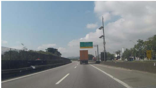
Foto 2.1 | SP-150 - Via Anchieta, sentido Santos. A frente encontra-se a saída 61, que dá acesso à Avenida Marginal Direita.
