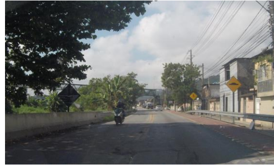
Foto 2.8. | Após o acesso ao CLIA, a avenida marginal mantém as mesmas características geométricas em pista simples, exceto pela ausência de faixa para estacionamento. a imagem acima mostra más condições de manutenção do pavimento e das sinalizações horizontais em alguns pontos da via.
