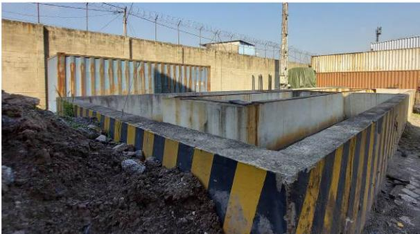
Figura 35: Dique de contenção para contêineres com avarias
