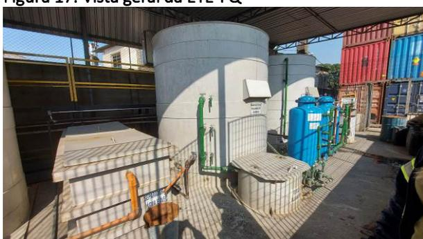
**Figura 19: Separador Água e óleo (SAO) e reator da ETE-FQ**
