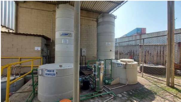
Figura 23: Tanques de Desinfecção e Reator biológico da ETE-BIO01
