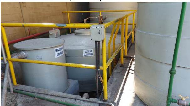
Figura 27: Separador Água e Óleo (SAO) e Estação Elevatória de Efluente (EEE) - ETE-BIO 01
