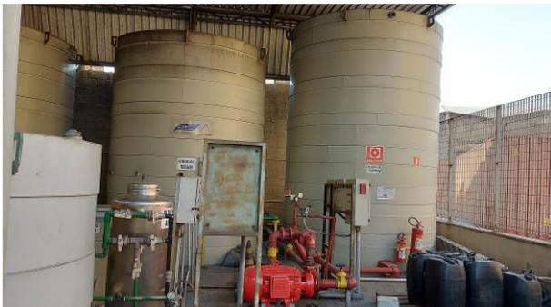
Figura 25: Reator de tratamento biológico e Tanque de reserva de incêndio (à direita)
