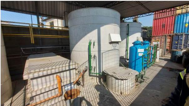
Figura 37: Separador Água e Óleo (SAO) da ETE-FQ (à esquerda)
