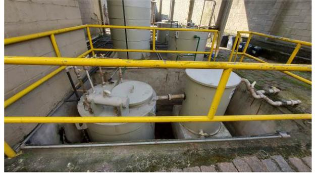
Figura 22: Separador Água e Óleo (SAO) e Estação Elevatória de Efluente da ETE-BIO 02
