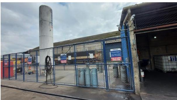
Figura 25: Tanque de GLP para abastecimento de empilhadeiras. Área com controle de acesso.
