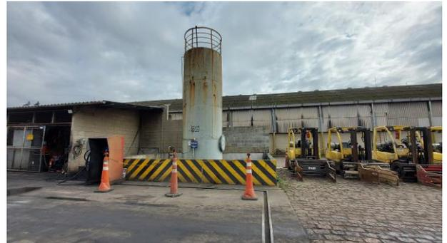
Figura 22: Tanque de diesel para abastecimento (>15m<sup>3</sup>)
