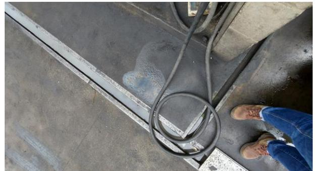
Figura 24: Canaletas de drenagem de água
