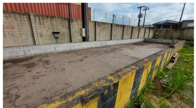
Figura 29: Interior do dique de contenção
