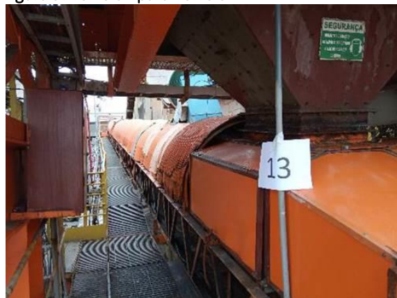
Figura 9: Torre 01 para Torre 02
