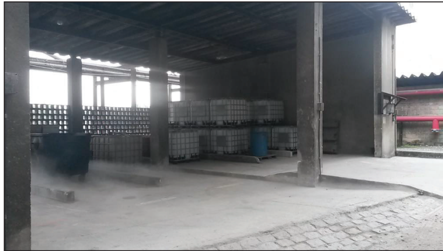
Figura 8 - Área de Segregação Temporária de Tambores - ASTT
