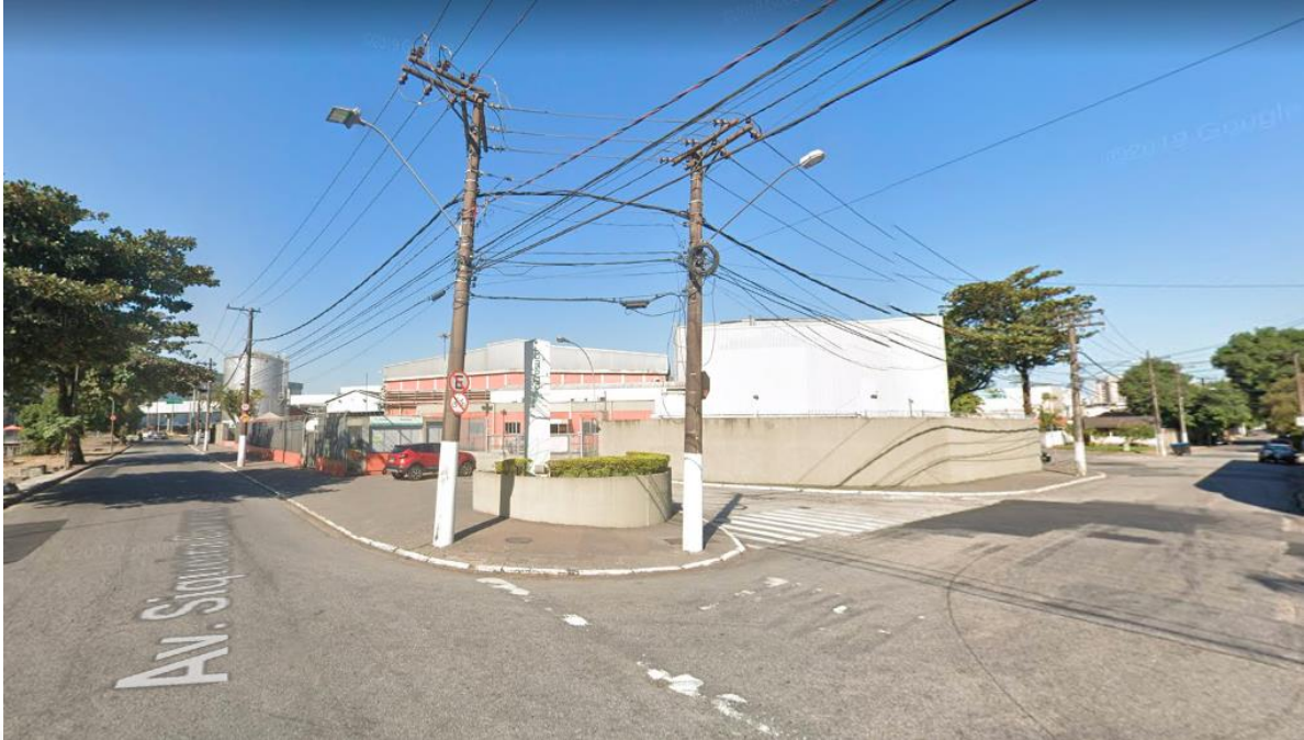
Figura 39: Condições do pavimento das calçadas entorno do empreendimento
