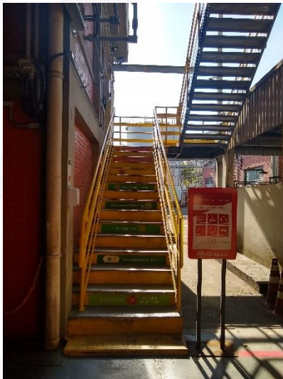
Figura 23: Acesso pedestres Armazém 29 (foto 2) (sucoduto)
