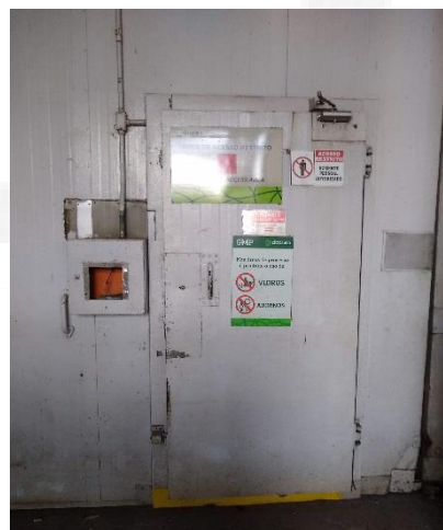
Figura 26: Controle de acesso Armazém 29 (foto 2)
