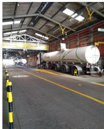
Figura 20: Área de descarga
