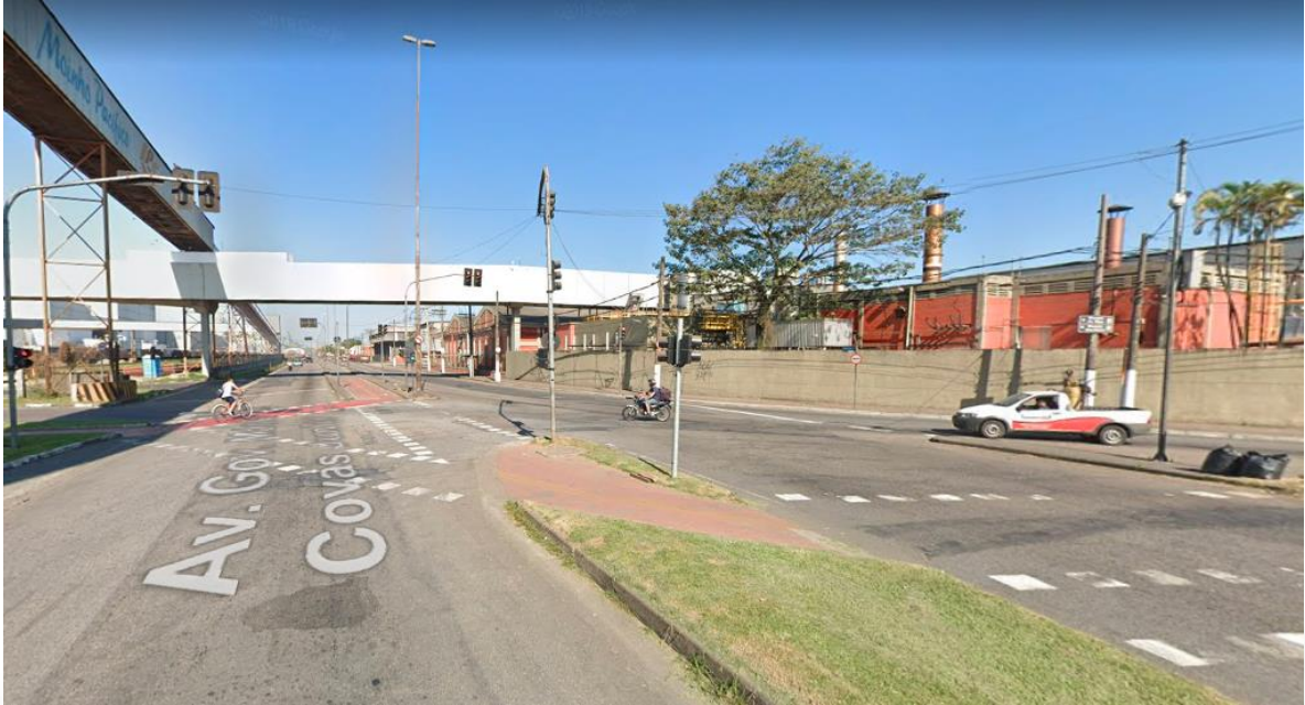
Figura 42: Semáforo Av. Cidade de Santos
