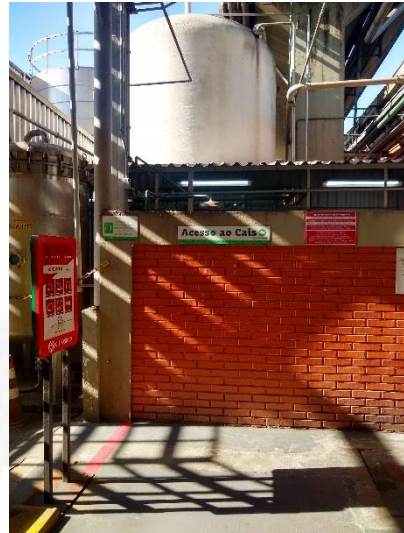
Figura 22: Acesso pedestres Armazém 29 (foto 1) (sucoduto)
