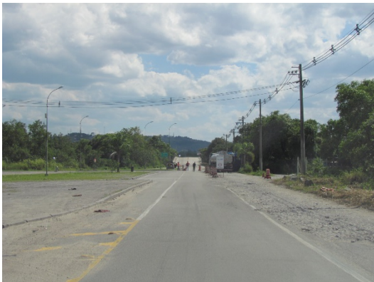
Foto 2.7. | Após aproximadamente 1.700 metros a partir da SP-055 encontra-se o pré gate, apontado na figura 2.2.1. Neste ponto, coincidente com o acesso à Embraport, é realizada a primeira triagem dos veículos destinados ao terminal da Adonai, impedindo aqueles que não possuem o devido agendamento de adentrarem no complexo portuário, evitando que vários caminhões cheguem ao mesmo tempo no terminal.
