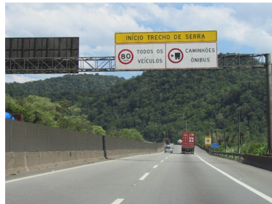
Foto 2.15. | SP-055, sentido Guarujá. A aproximadamente 5,5 quilômetros do acesso à Estrada Particular da CODESP inicia-se o trecho de serra da rodovia. Neste trecho a rodovia desenvolve-se com duas faixas de rolamento por sentido e sua velocidade máxima é regulamentada em 80km/h para todos os tipos de veículos.
