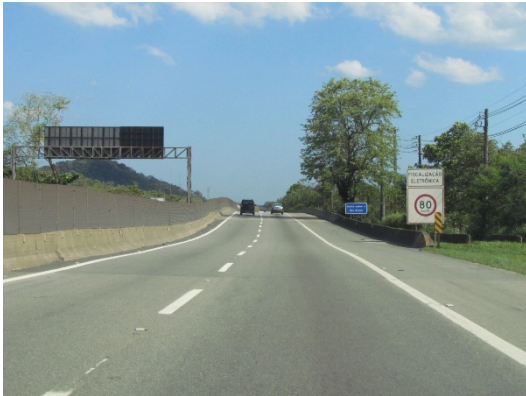
Foto 2.16. | SP-055, sentido Guarujá, após o acesso à Ilha Barnabé. Após o acesso, a via possui regulamentação de velocidade máxima em 80 km/h.
