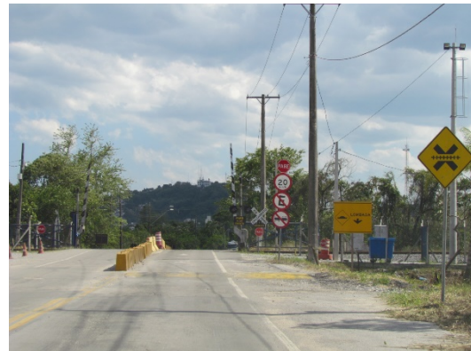
Foto 2.9. | Após aproximadamente 1.100 metros do pré gate, encontra-se a passagem em nível sobre a ferrovia. A partir da imagem acima pode-se verificar que a PN se encontra devidamente sinalizada, utilizando-se de cancelas automáticas e sinaleiras para o fechamento do tráfego rodoviário durante a passagem de composições ferroviárias.
