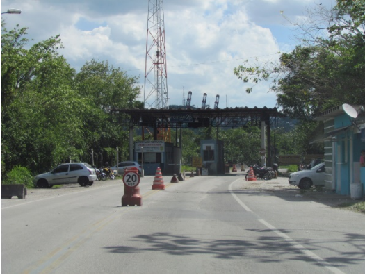
Foto 2.10. | A portaria de acesso ao terminal da Adonai encontra-se após aproximados 3.300 metros de percurso a partir da SP-055. Neste ponto o controle de acesso é fiscalizado pela Autoridade Portuária, responsável pela jurisdição da Estrada Particular da CODESP.
