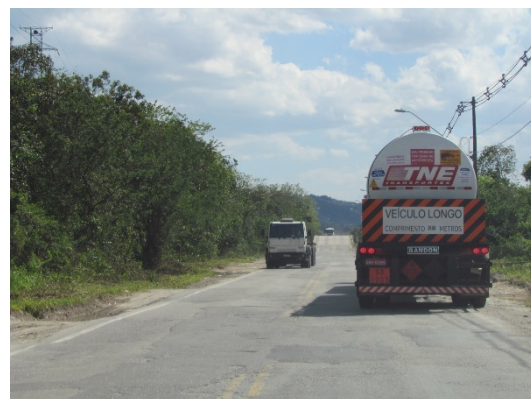
Foto 2.4. | Estrada Particular da CODESP, sentido Ilha Barnabé. A partir da SP-055, a via desenvolve-se em pista simples, com uma faixa de rolamento por sentido. Nota-se a partir da imagem acima, as condições inadequadas de conservação do pavimento e das sinalizações horizontais, acostamentos sem pavimentação e em condições inadequadas de conservação.
