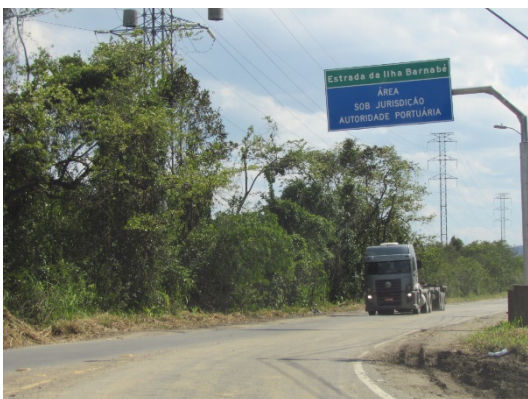
Foto 2.3. | Estrada Particular da CODESP. A imagem ilustra ainda o trecho inicial da via de acesso. A placa indica a jurisdição do trecho, delegada à autoridade portuária.
