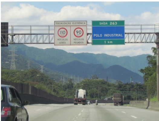
Foto 2.14. | SP-055 – Rodovia Cônego Domênico Rangoni, sentido Guarujá, após o acesso à área urbana de Cubatão. Neste trecho a via desenvolve-se em pista dupla, com três faixas de rolamento por sentido. A via encontra-se em bom estado de conservação, com sinalizações horizontal e vertical adequadas. Sua velocidade máxima está regulamentada em 110Km/h para veículos leves e 90km/h para veículos pesados.
