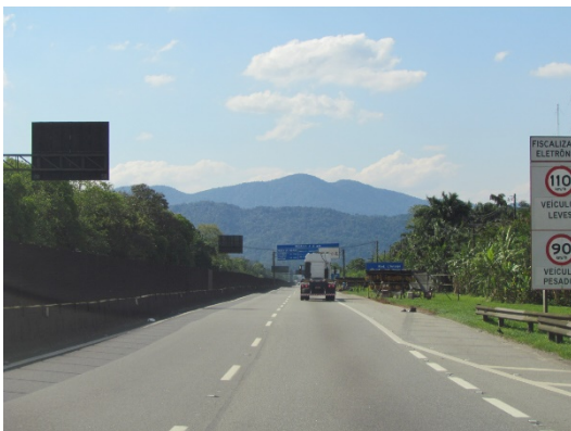
Foto 2.16. | Rodovia Cônego Domênico Rangoni, sentido Cubatão. A pista sentido Cubatão da SP-055 possui as mesmas características da pista sentido Guarujá.
