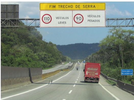
Foto 2.14. | SP-055 – Rodovia Cônego Domênico Rangoni, sentido Guarujá. Após o trecho de serra, que termina há aproximadamente 2,5 km do acesso à Estrada Particular da CODESP, as regulamentações de velocidade voltam às condições anteriores. Entretanto, a via mantém seu desenvolvimento com duas faixas de
