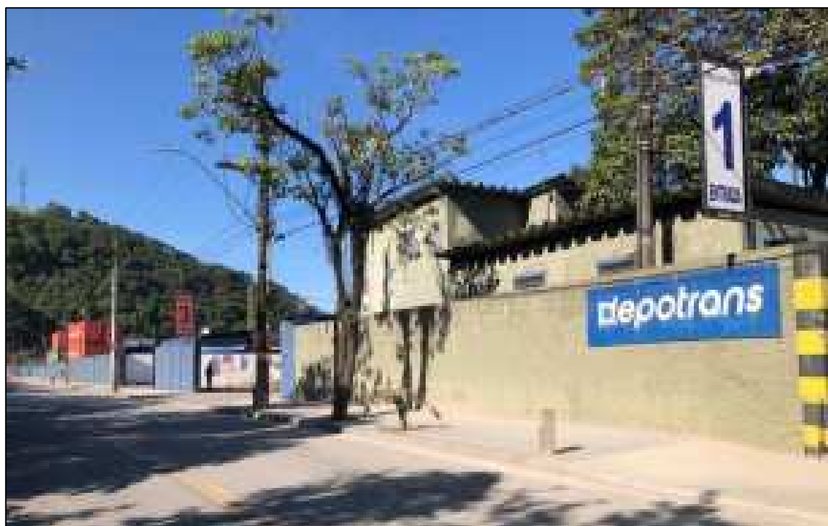
Figura 22 - Vista dos fundos das instalações
