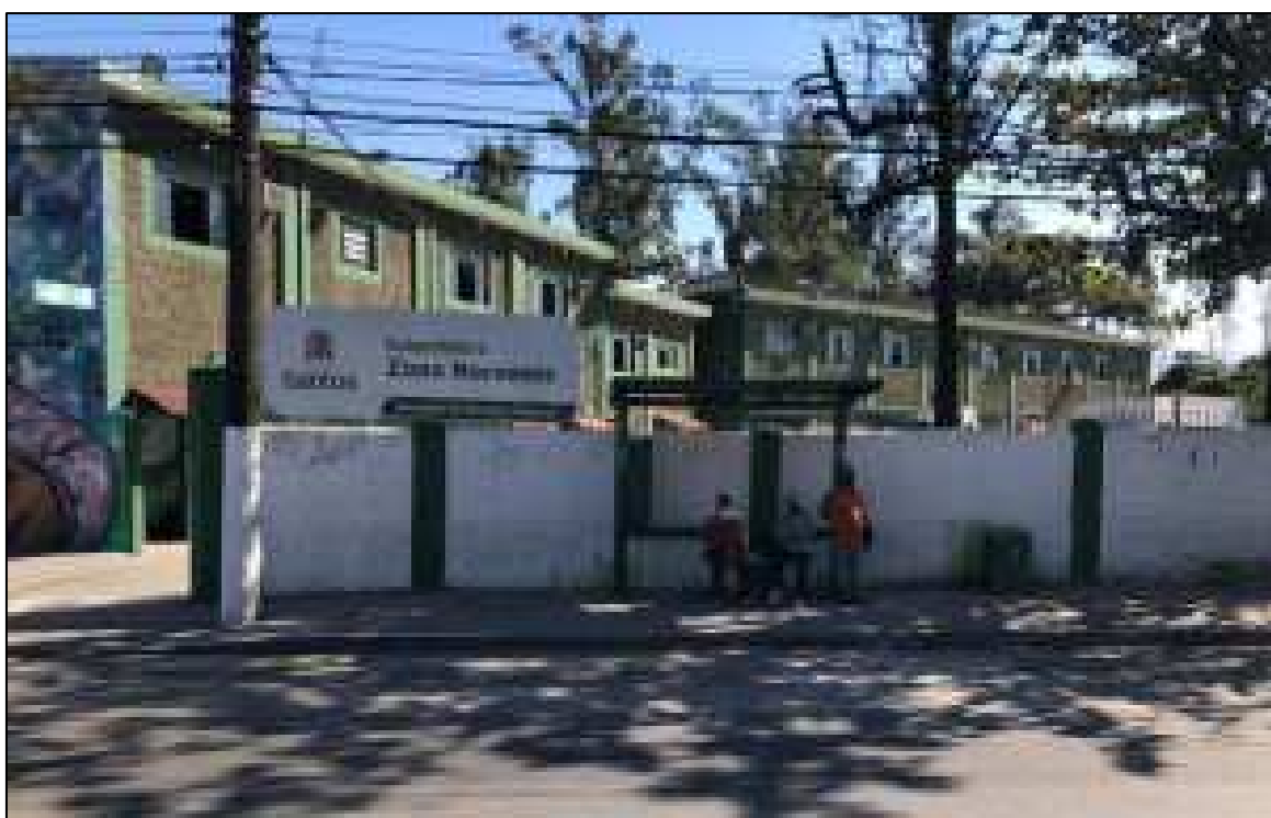
Figura 23 - Vista da esquina esquerda
