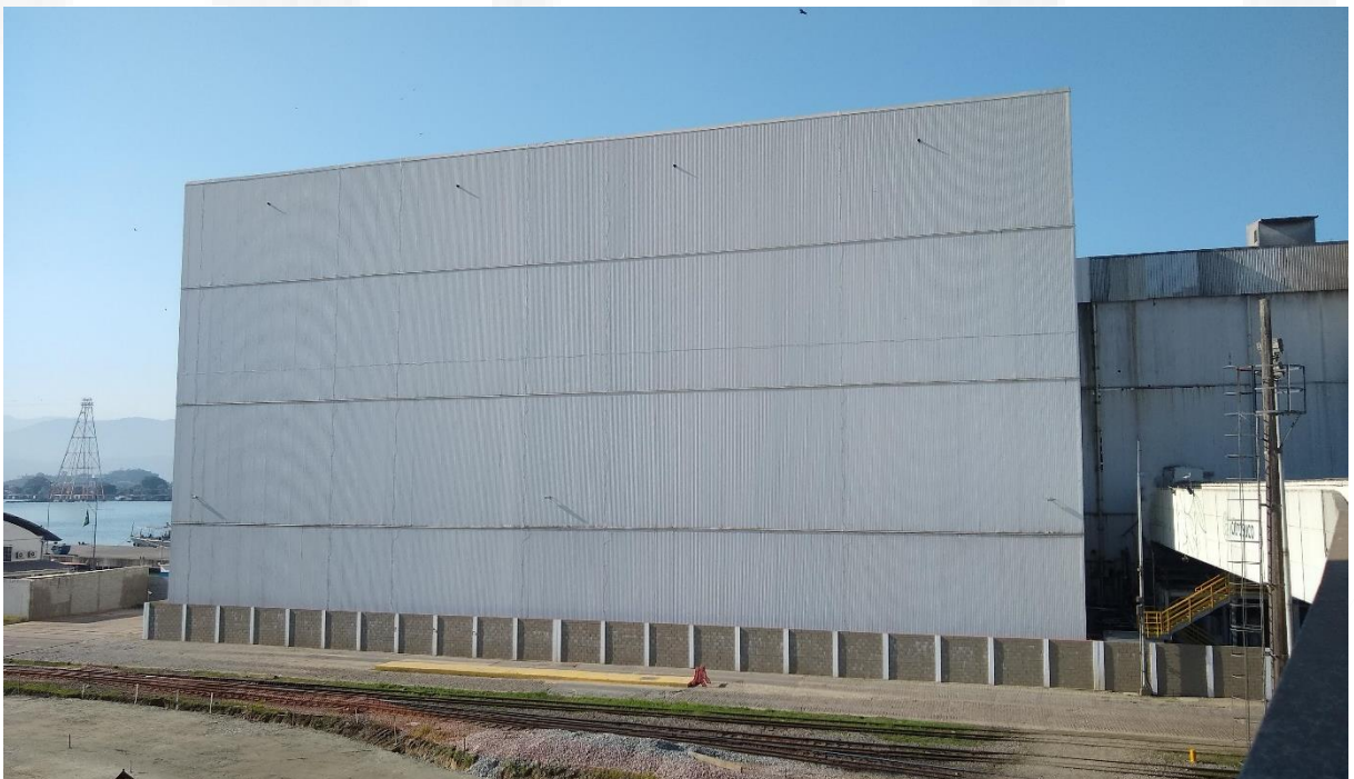
Figura 14: Implantação/execução da infraestrutura (b)
