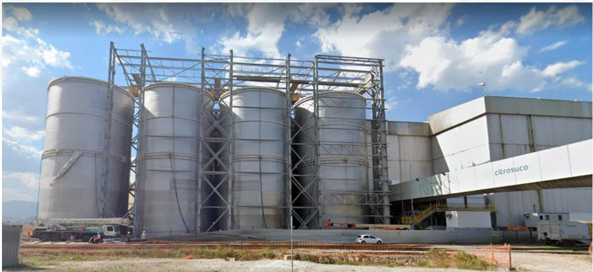
Figura 12: Implantação/execução dos tanques
