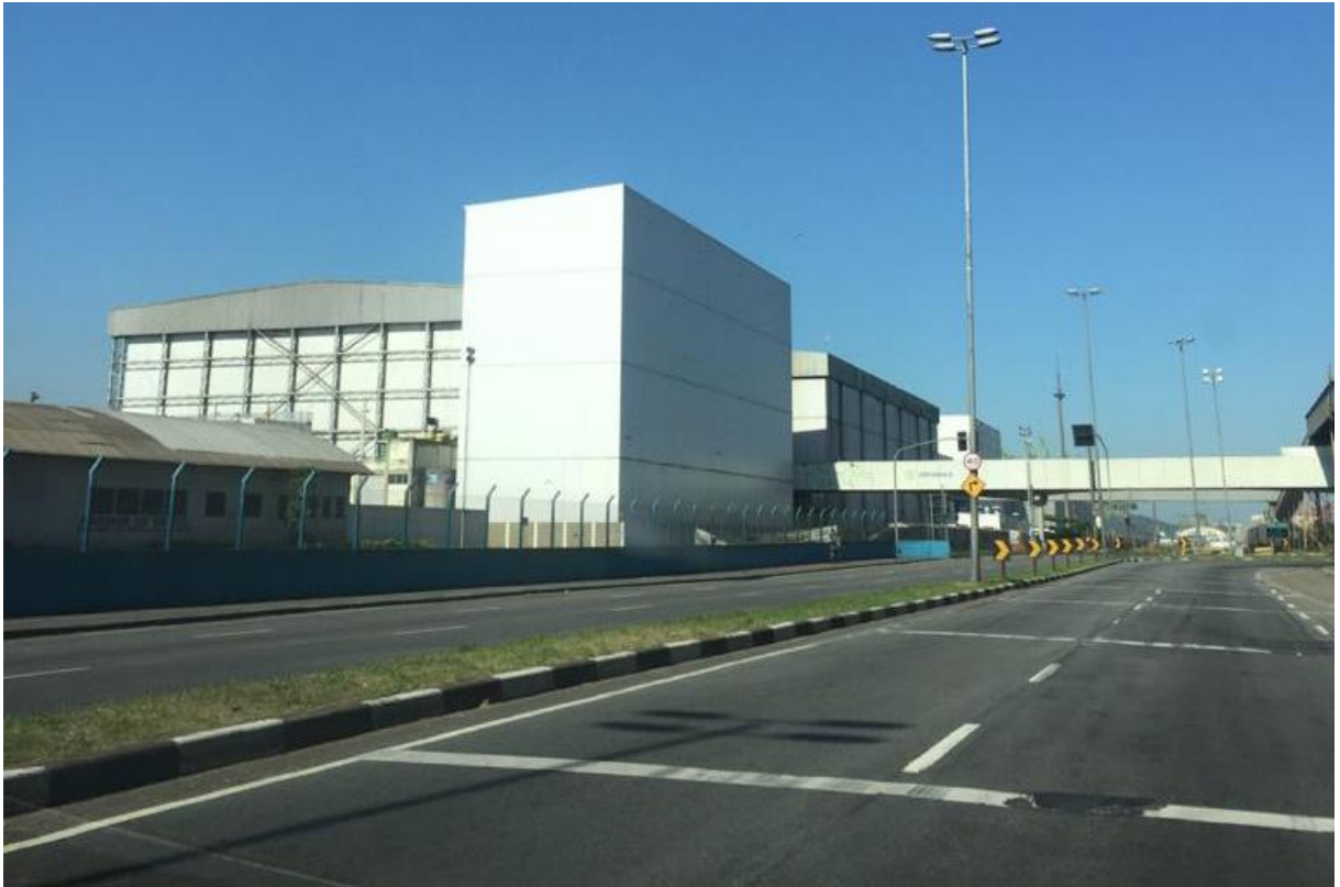
Figura 13: Implantação/execução da infraestrutura (a)
