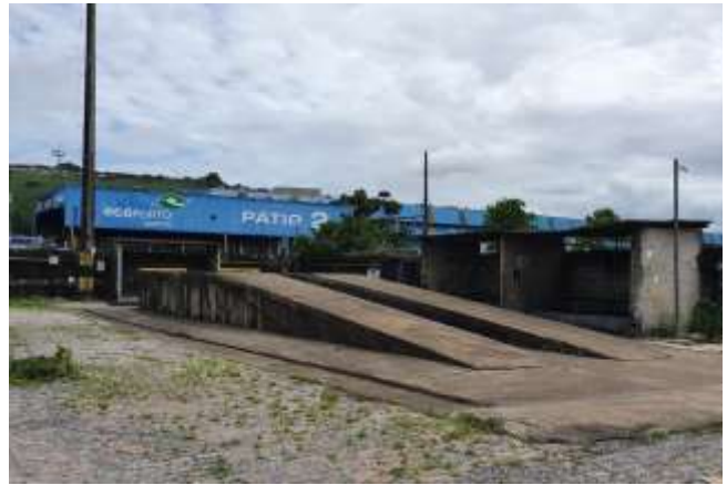
FOTO 02 – Rampa de manutenção
