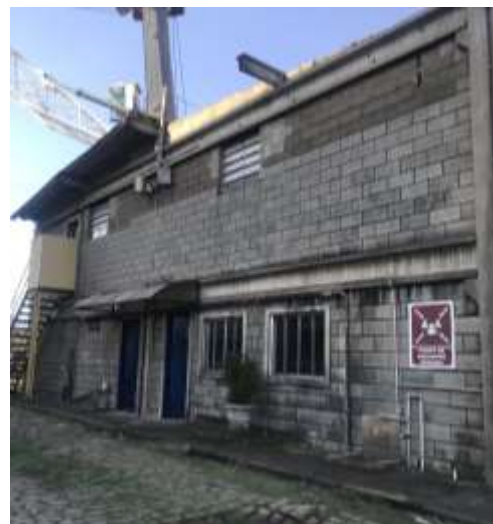
Foto 2 – Área a ser revitalizada para administrativo
