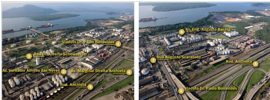
Figura 2: Vias de acesso na região da Alamoia. Fonte: Ministério da Infraestrutura (2019)
