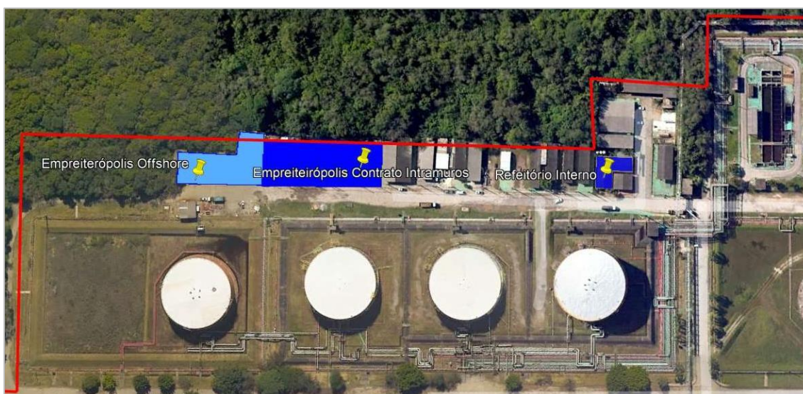
Figura 8: Área destinada ao canteiro das obras intramuros do Terminal de Santos.
