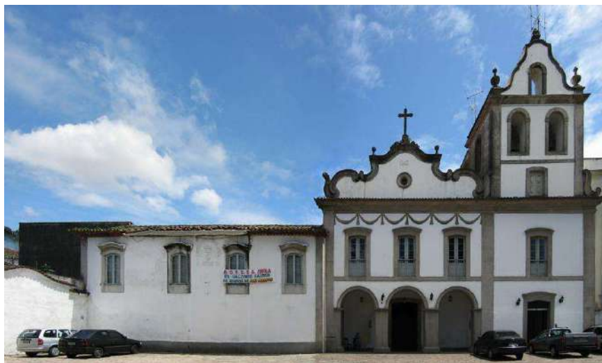
Figura 47 – Conjunto de Santo Antônio do Valongo. Fonte: CONDEPHAAT (2021).
