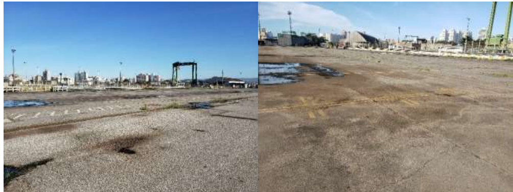
Figura 31 – Piso em concreto armado.
