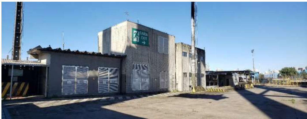
Figura 32 – Subestação, portaria e vestiários.
