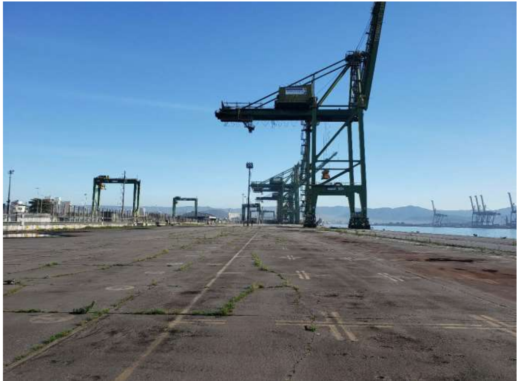
Figura 30 – Visão geral da área do pátio de cargas.
