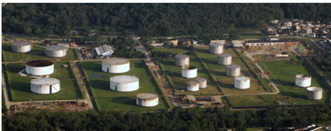
Figura 5.2.3.2-1: Terminal Terrestre de Cubatão (Transpetro). Fonte: http://www.petrobras.com.br/pt/nossas-atividades/principais-operacoes/terminais-e-oleodutos/terminal-cubatao.htm
