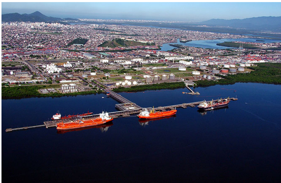
Figura 5.2.3.1-1: Terminal Aquaviário de Santos - Transpetro. Fonte: http://www.transpetro.com.br
