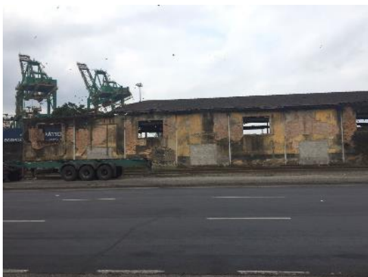
Foto 17: Armazém CODESP – Futuro Porto Valongo Santos
