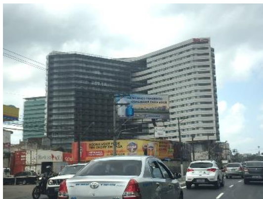
Foto 03: Hotel IBIS e edifício comercial Valongo Brasil.
