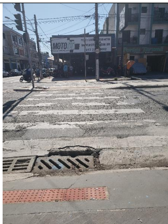
Faixa de pedestre apresentando desgaste na pintura, acesso para cadeirantes com risco - Av. Conselheiro Nébias esquina com a R. Doná Luísa Macuco.
