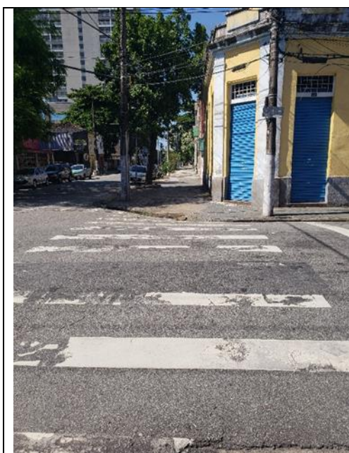
Faixa de pedestre apresentando desgaste na pintura, acesso para cadeirantes adequado - R. Doná Luísa Macuco com a R. Campos Melo.
