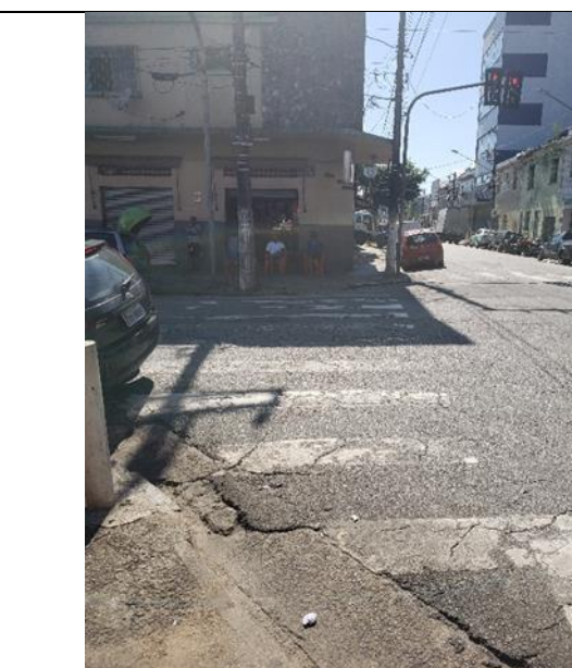
Faixa de pedestre apresentando desgaste na pintura, acesso para cadeirantes adequado - R. Doná Luísa Macuco com a R. Campos Melo.
