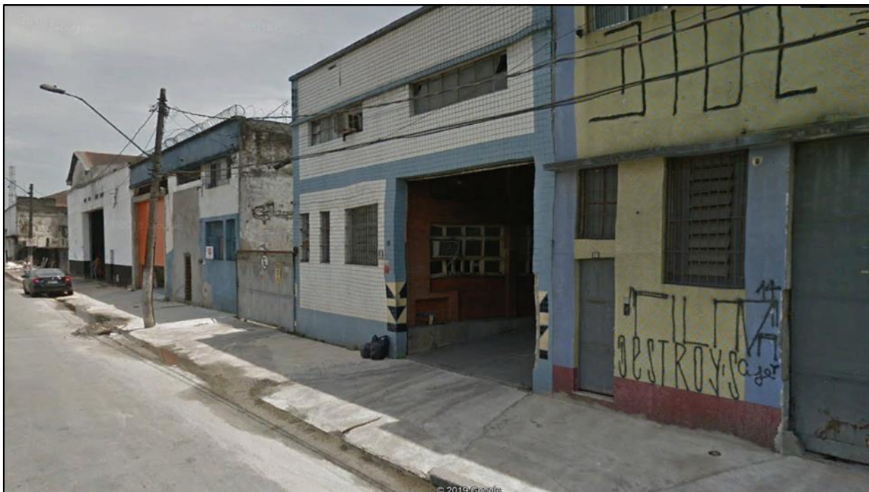
VISTA DAS CONDIÇÕES DE ACESSO À MULTIPORTOS.
