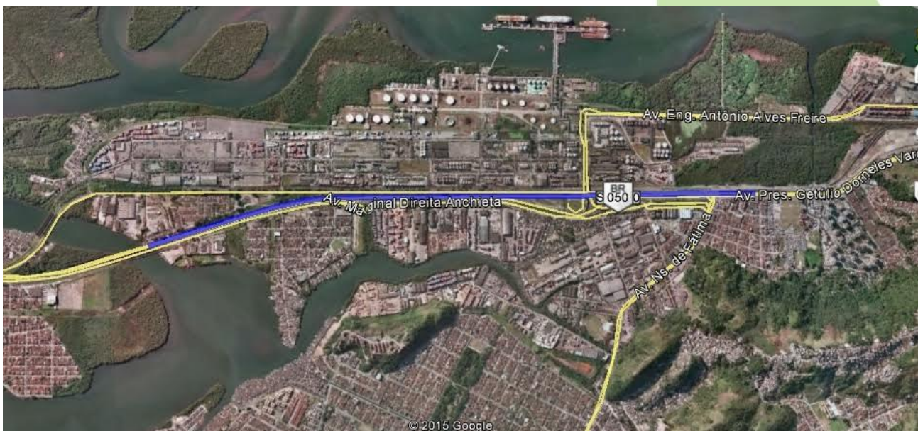
Imagem 01: Trecho onde serão realizadas as obras de adequação viária na Via Anchieta SP-150.
